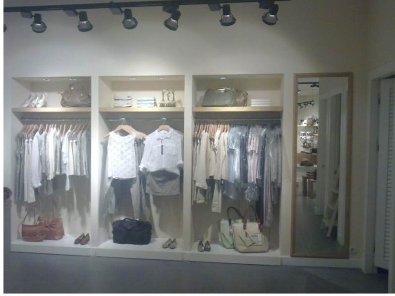
Şekil 5.44. Alçı panel niş raf sistemi – Nautilus
