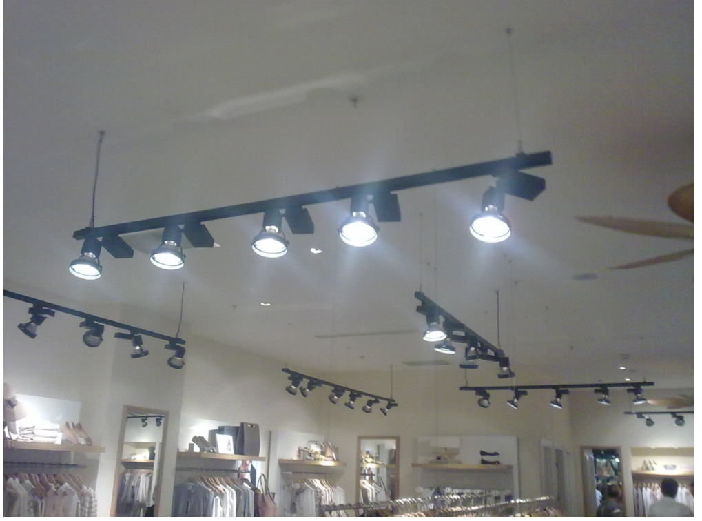
Şekil 5.35. Donatıların aydınlatmasında kullanılan elektro ray spotlar
