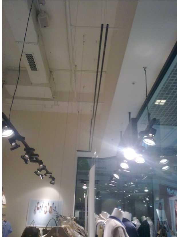
Şekil 5.36. Vitrin aydınlatmasında kullanılan elektro ray spotlar
