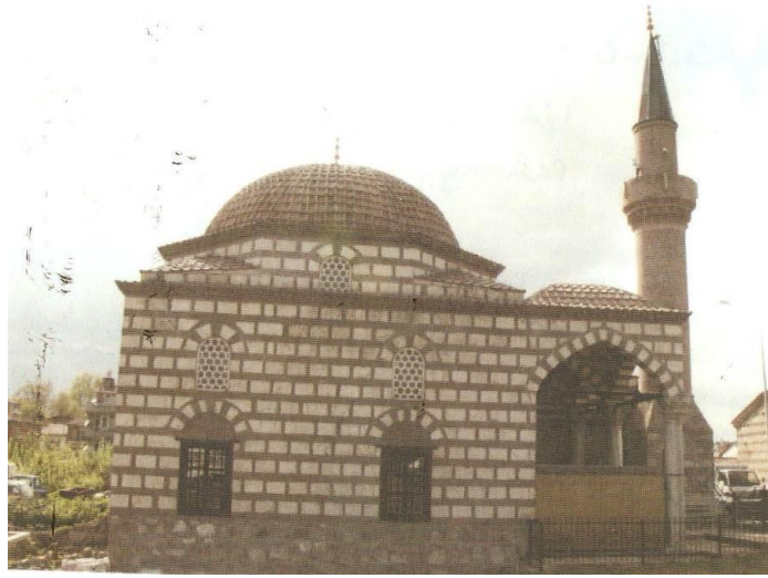
Şekil 6.4 Şeyh Kudbettin Cami'sinin bütünleme yöntemi kullanılarak yapılmış restorasyonu sonrası görünüşü.
