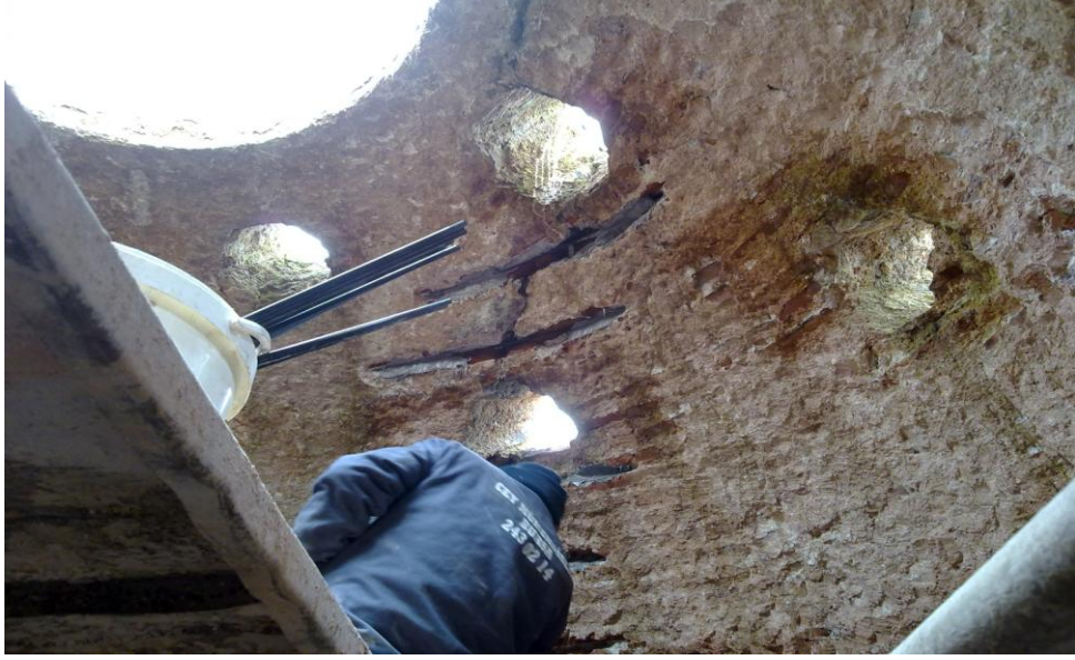
Şekil 3.11 Kayihan Hamamı, kubbede polimer karbon çubuklarla dikiş yapılması
