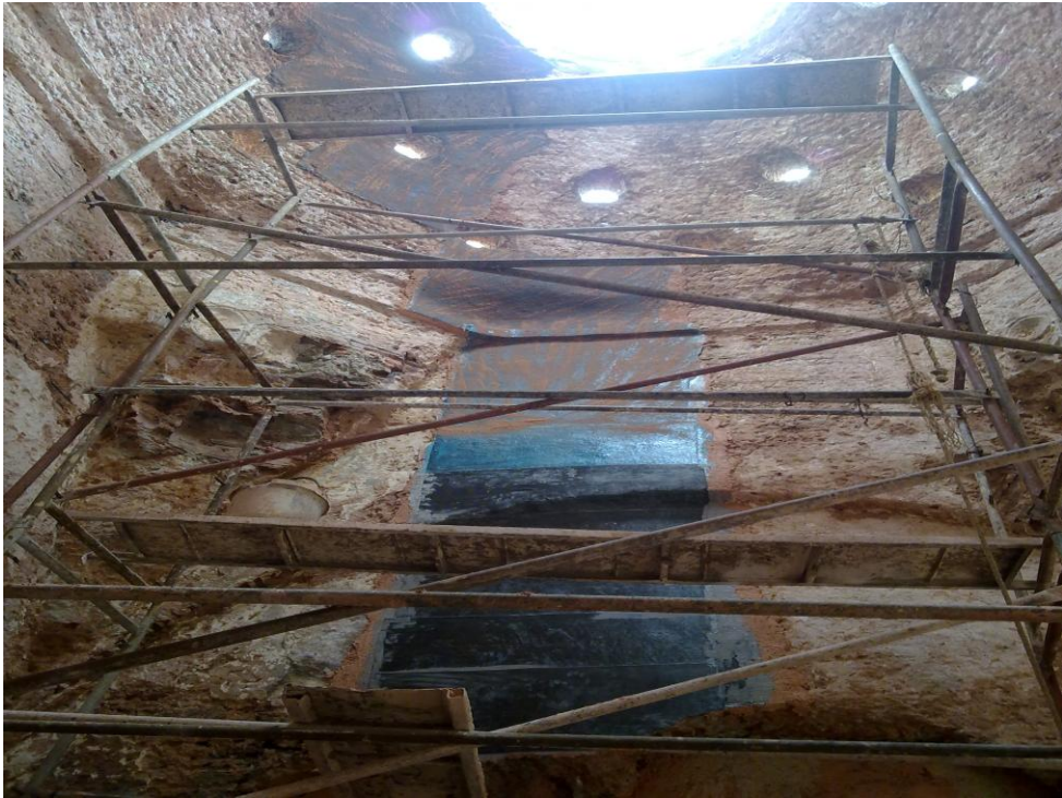
Şekil 3.12 Kayihan Hamamı, kasnak ve kemerlerde karbon polimer kumaşlarla sargı yapılması
