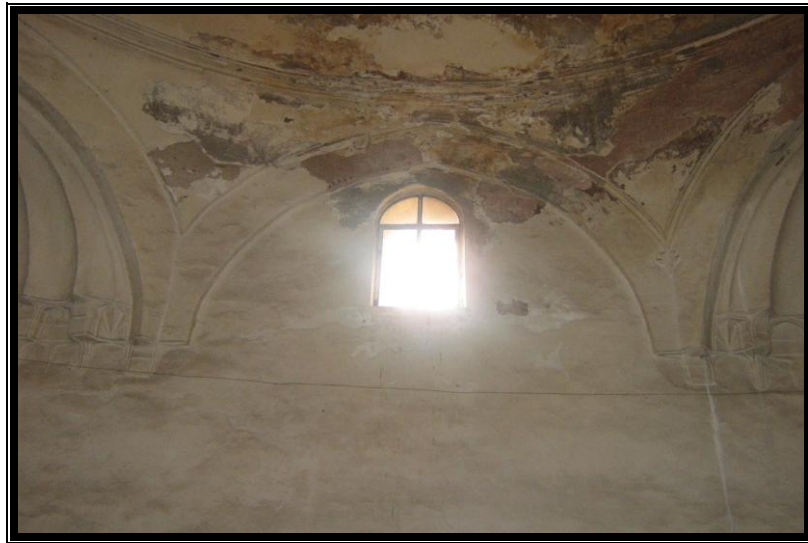
Şekil 3.14 İncirli Hamamı kubbe, kasnak ve kemer sıvalarında meydana gelen kabarma ve dökülmeler
