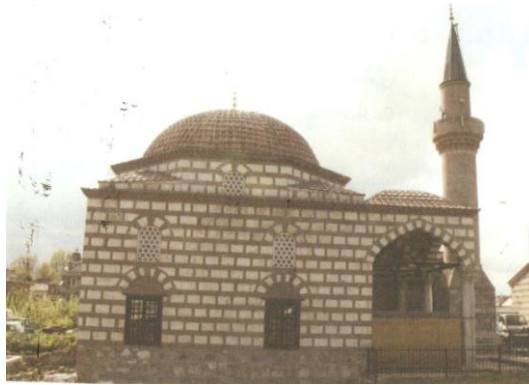
Şekil 4.6 Şeyh Kudbettin Camisi'nin bütünleme yöntemi kullanılarak yapılmış restorasyonu sonrası görünüşü
