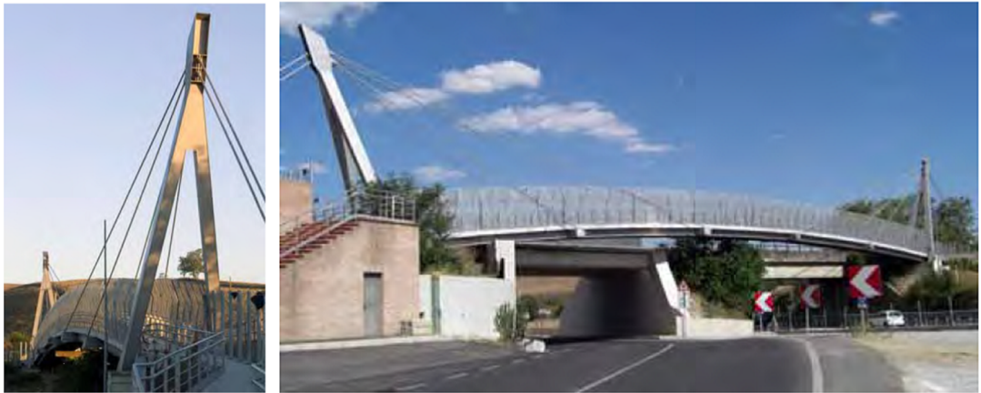
Şekil 1.13 Siena yaya köprüsü.
