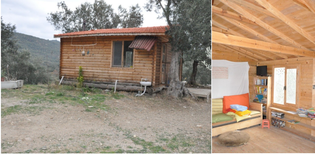
Şekil 5.100. Okul Binası, Dedetepe Yerleşimi (Güleryüz, 2011)
