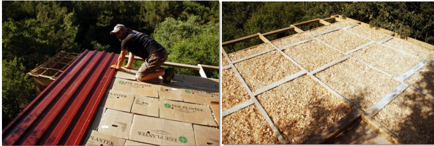
Şekil 5.26. Bungalov Çatı Uygulamaları ( www.marmaric.org ).
