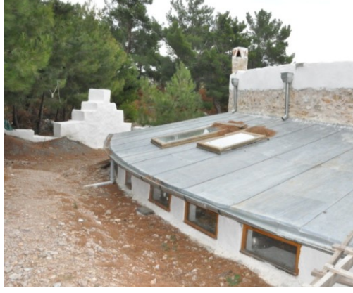
Şekil 5.78. Çamtepe Binası'nın toprağın altında kalan kısmı, (Güleryüz, 2011).
