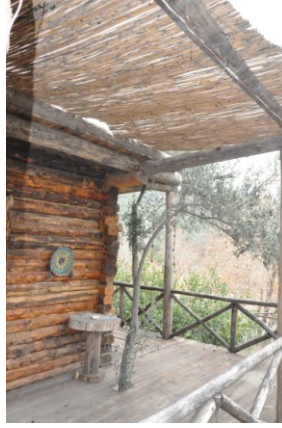
Şekil 5.106. Kütük Evlerde Kullanılan Kamış Çatı Malzemesi (Güleryüz, 2011).
