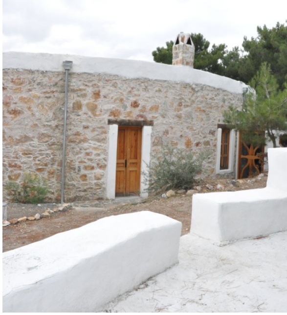
5.81. Çamtepe Binası Dış Kapı (Güleryüz, 2011).
