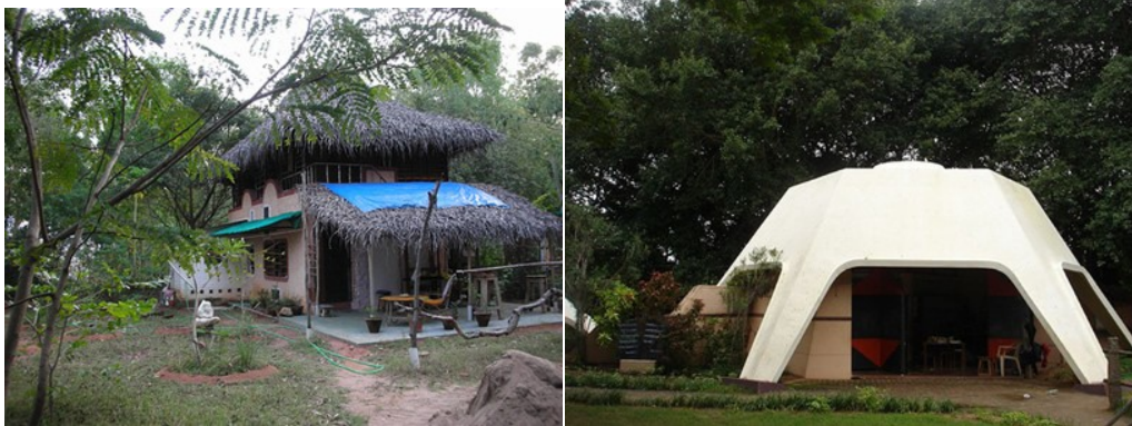
Şekil 4.34. Geleneksel mimari tarzda ve geleneksel yapı malzemeleri ile inşa edilmiş bir bina, Auroville Yerleşimi ( http://www.hotelclub.com/blog/auroville/ )
