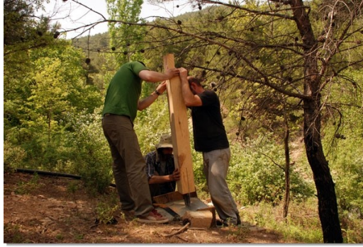
Şekil 5.25. Betonarme Pabuç Üzeri Ahşap Dikmelerin Yerleştirme İşlemi ( www.marmaric.org ).
