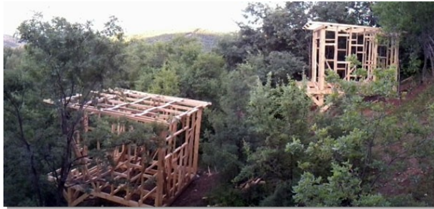
Şekil 5.23. Marmariç'te İnşa Edilen Ahşap Bungalovların İnşası Sırasında Çekilmiş bir Fotoğraf 1 (www.marmaric.org).
