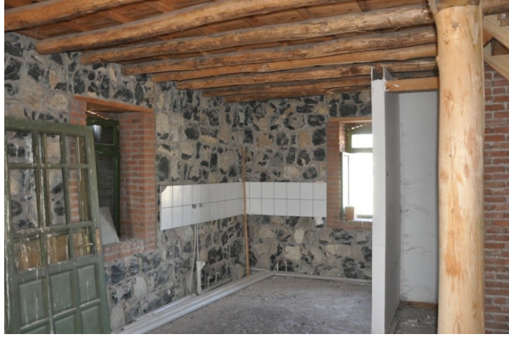
Şekil 5.69. B2 Konut binası iç mekan görüntüsü (Güleryüz, 2011).
