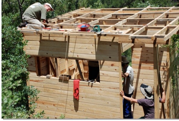
Şekil 5.24. Marmariç'te İnşa Edilen Ahşap Bungalovların İnşası Sırasında Çekilmiş bir Fotoğraf 2 ( www.marmaric.org ).
