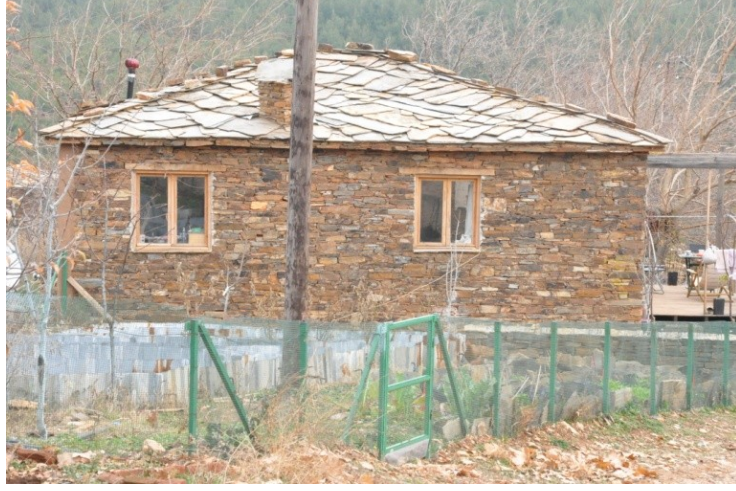
Şekil 5.13. Kayrak taşlarından elde edilmiş konut yapısı (A3), (Güleryüz, 2011).
