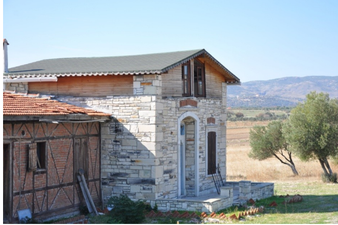
Şekil 5.71. B3 Konut Binası Ek Bina (Güleryüz, 2011).
