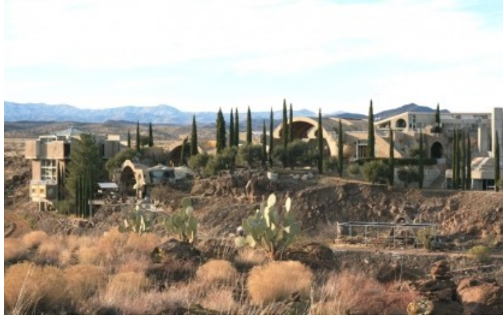
Şekil 2.4. Arcosanti yerleşiminden genel bir görünüm ( http://www.arcosanti.org/ )
