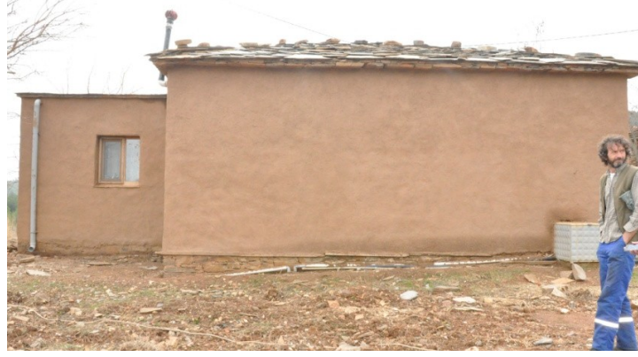
Şekil 5.14. Kuzey Cephesi Toprak Sıvayla Sıvanmış Taş Ev (A3), (Güleryüz, 2012).
