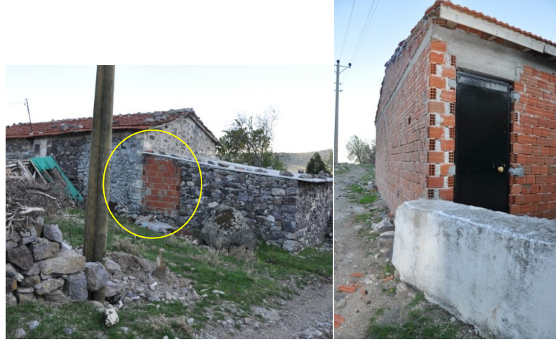
Şekil 5.43. Dutlar Köyü'nde binalara yapılan yeni eklemeler (Güleryüz, 2011).
