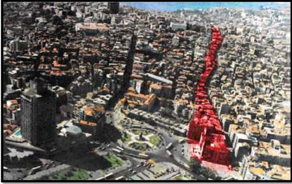
Şekil 4.11: Tarlabası Bulvarı İçin Yıkılan Binalar (Çetin 69)
