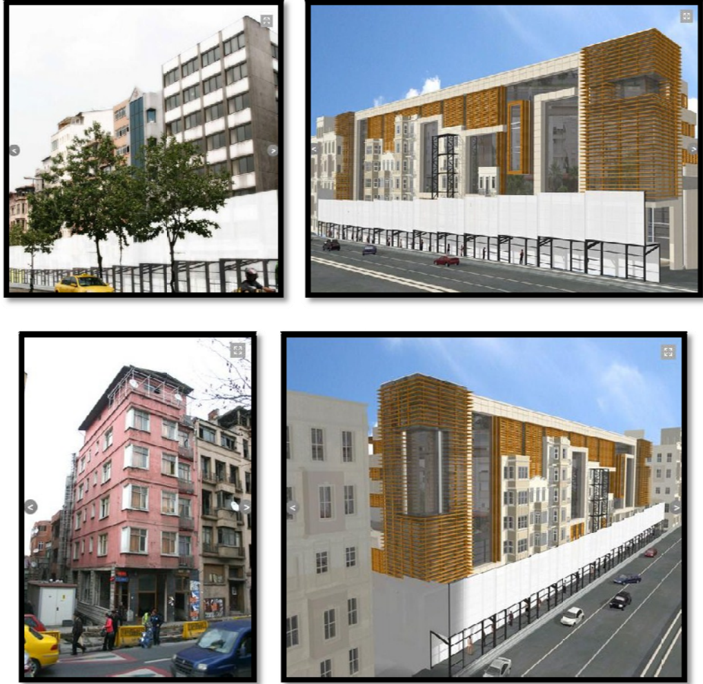
Şekil 4.16: Tarlabaşı Bulvarı Üzerinde Yer Alan Bina Cepheleri Önceki ve Sonraki Durum (İ.B.B.,2013)
