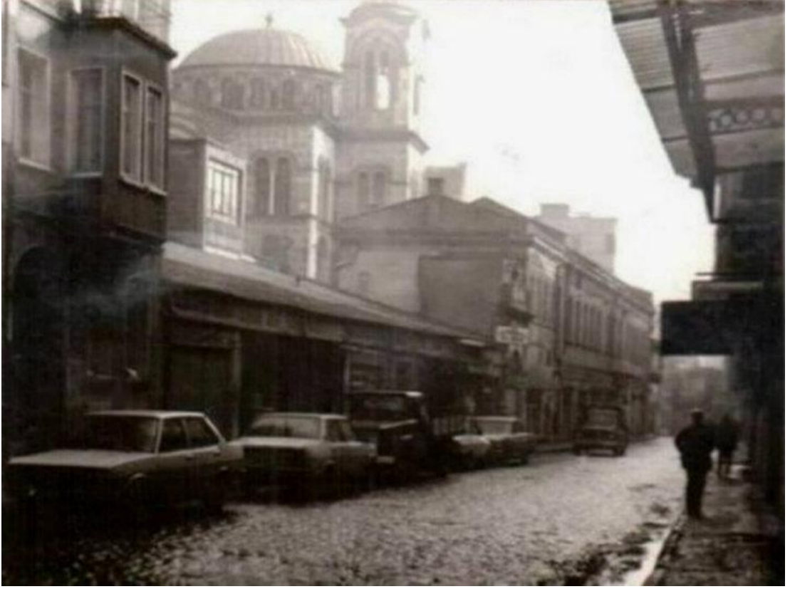
Şekil 2. 17. Ayia Kiryaki Kilisesi Kadırga Caddesi Görünüşü ( https://www.facebook.com/kumkapiyaozlem , 22 Ağustos 2013)
