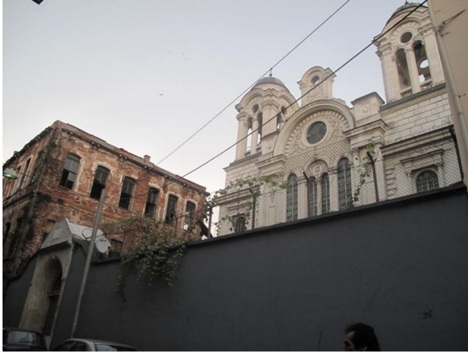
Şekil 2. 13. Panayia Elpida Kilisesi Ön Cephesi (Birgül, 2013)
