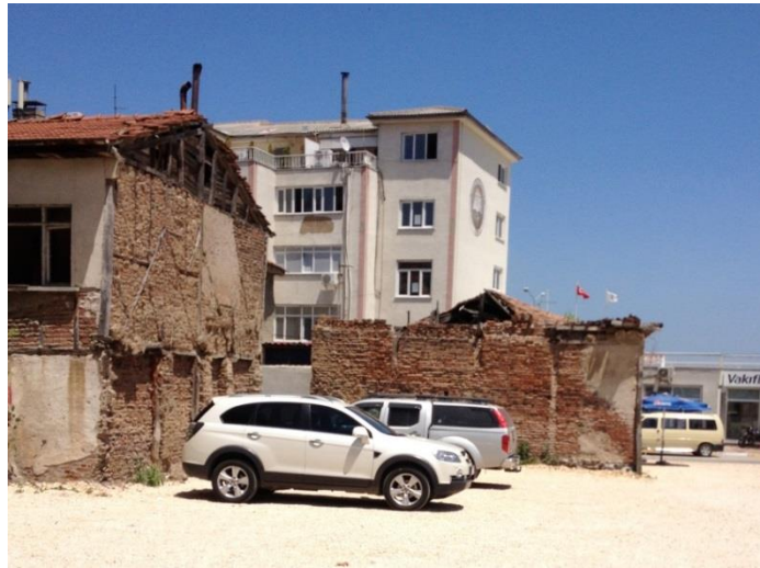
Şekil 4. 60: Hasan Ağa Konağı Günümüzde Yıkıldıktan Sonraki Parselin Görünümü (Ezgi Güner, 2013)
