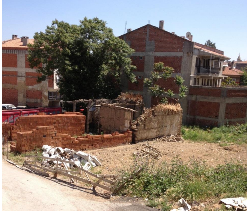
Şekil 4. 58: Halil Ağa Konağı'nın Yıkılmış ve Kalan Duvarlarının Görünümü (Ezgi Güner,2013)
