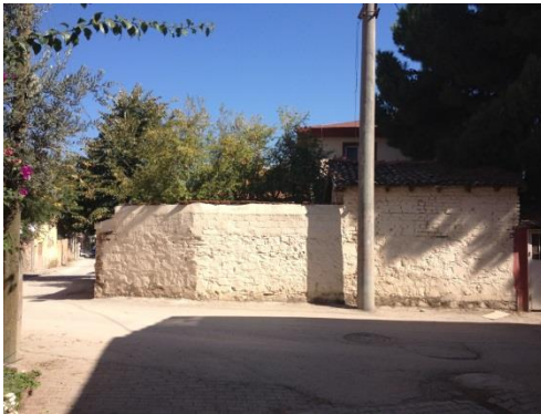
Şekil 8. 21: Selvilik Caddesi 13 numaralı Yapı Bahçe Duvarı Görünümü (Ezgi Güner, 2013)
