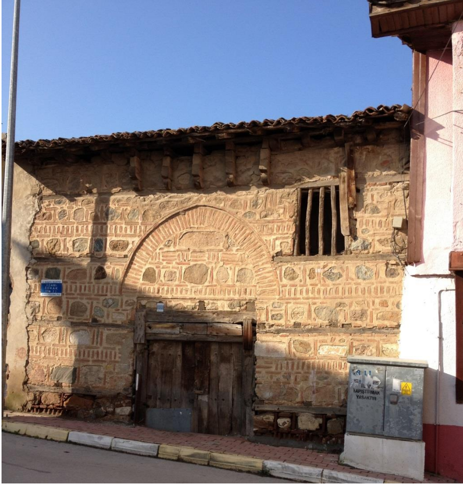
Şekil 4. 63: Eski Belediye Binasının 3.Camii Sokak Cephesi Görünümü (Ezgi Güner, 2013)
