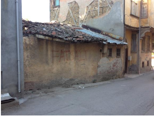
Şekil 8. 19: Selvilik Caddesi Depo Yapısının Görünümü (Ezgi Güner, 2013)
