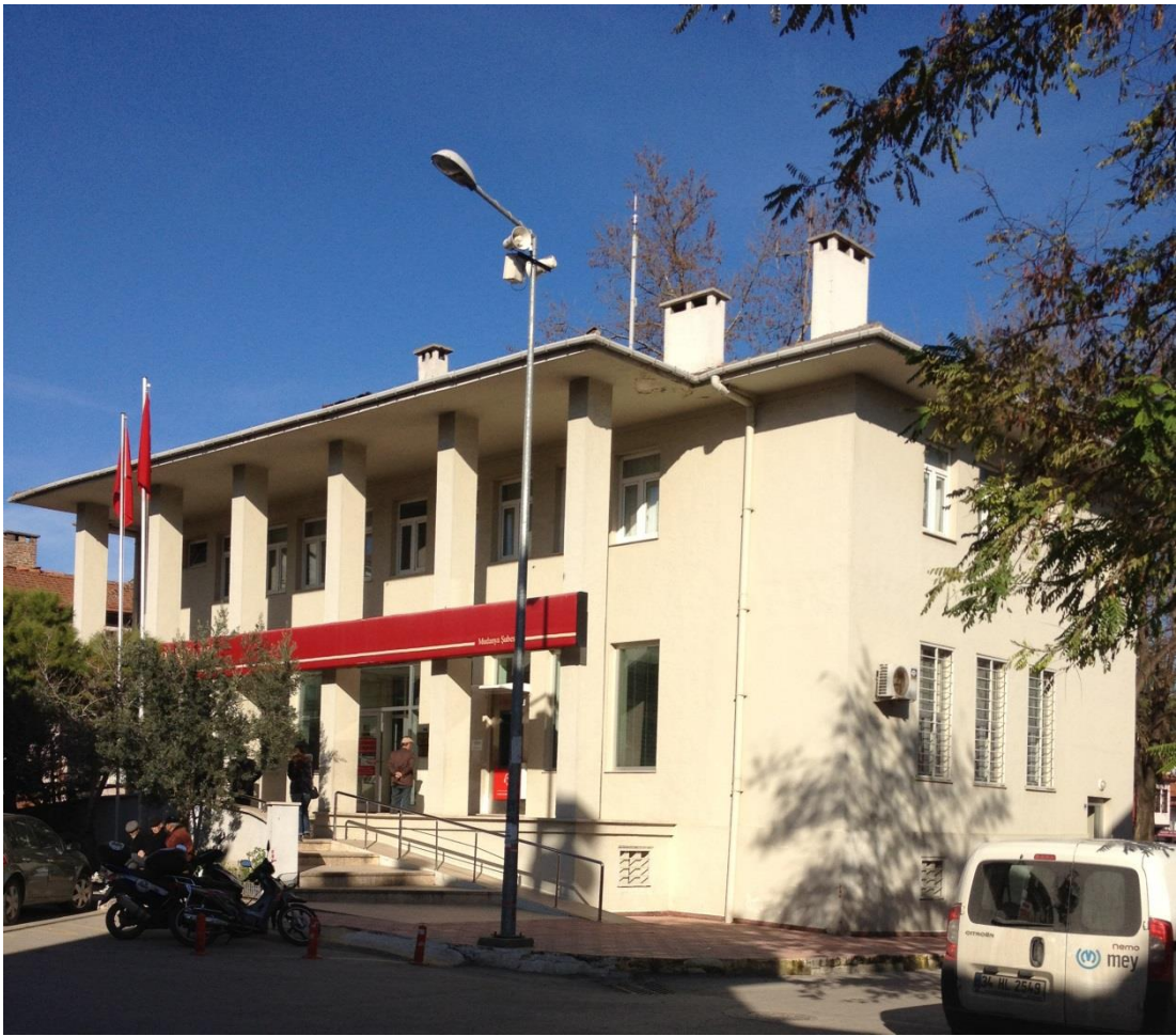
Şekil 4. 65: Ziraat Bankası Giriş Cephesi Görünümü (Ezgi Güner, 2013)
