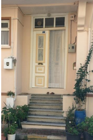
Şekil 4. 90 (solda): Izgara Dokuda Şükrü Çavuş Sok. 5 numaralı Yapıya ait Üst Pencere ve Nişli Çift Kanatlı Kapı Örneği (Ezgi Güner, 2013)
