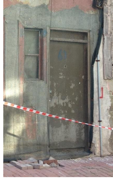
Şekil 4. 86 (solda): Izgara Dokuda 2. Harmanlar Sok. 19 numaralı Yapı Üstü Pencereli Tek Kanatlı Kapı Örneği (Ezgi Güner, 2013)
