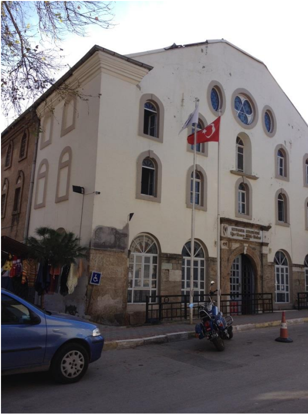
Şekil 4. 61: Eski Kilisenin Batı ve Kuzey Cephesinin Görünümü (Ezgi Güner, 2013)
