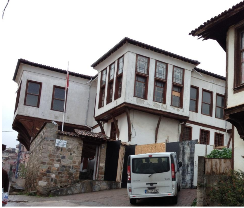
Şekil 4. 53: Tahir Paşa Konağı'nın Kütüphane Olarak Kullanımı(Ezgi Güner, 2013)
