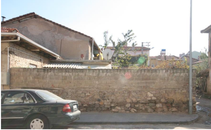
Şekil 5.16; 5 parsel 41 Kapı numaralı yapı bahçe duvarının Gediz Uluyolu Caddesi görünüşü (Karakozak, 2011)
