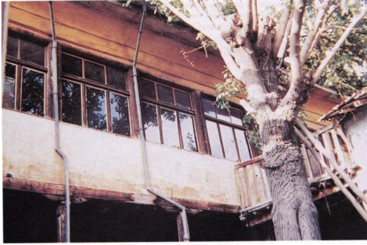
Şekil 3.23; Dokur Evi'nin açık avlusunun sonradan kapatılmış görünüm( Sayan, 1997, 51)
