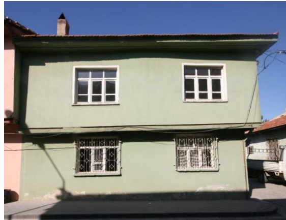
Şekil 5.49; 34 Kapı numaralı yapının cephe görünüşü
