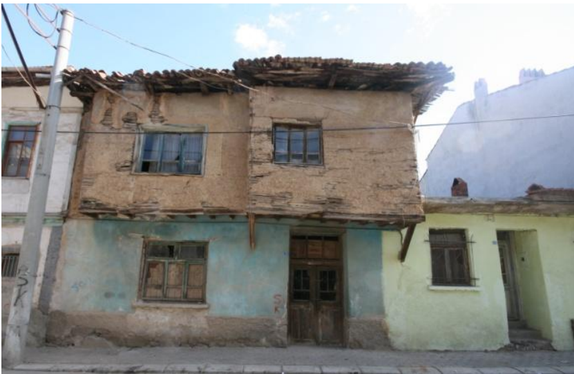
Şekil 5.72; 23 parsel 16 kapı numaralı yapının Gün Sokak görünüşü
