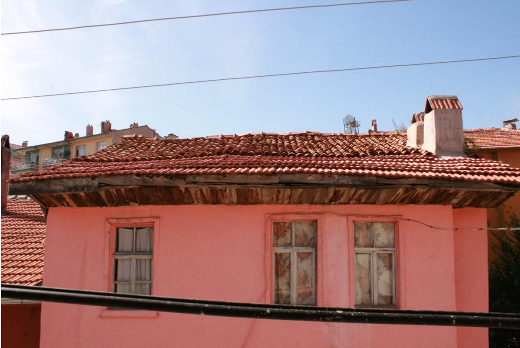
Şekil 5.63; 7 parsel 7 kapı numaralı yapının çatı görünüşü
