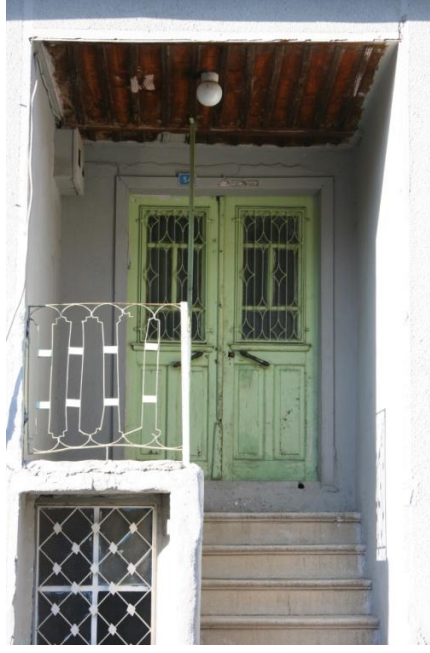
Şekil 5.27; 16 parsel 54 Kapı Numaralı Yapının ana giriş kapısı görünüşü
