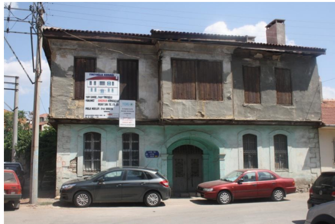
Şekil 3.47; Köme mahallesi Çatak Sokak 27 numaralı yapı, üst katta kepenkli, alt katta kemerli kanatlı penceresi olan yapı örneği (Karakozak, 2011)
