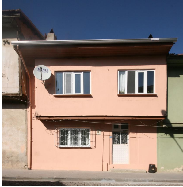
Şekil 5.46; 36 Kapı numaralı yapının cephe görünüşü
