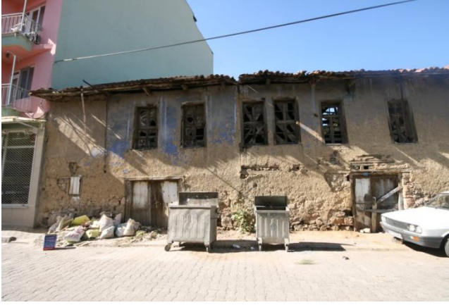
Şekil 5.54; 9 parsel 3 Kapı Numaralı Yapının bir bölümü
