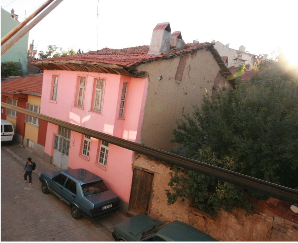
Şekil 5.62; 7 parsel 7 kapı numaralı yapının çatı görünüşü
