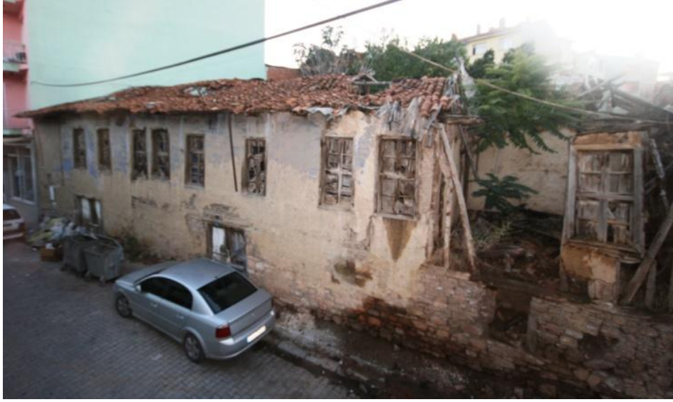
Şekil 3.17; Çalışma alanında bulunan Gün Sokak'ta 3 kapı numaralı tescilsiz olan yapı görünüşü
