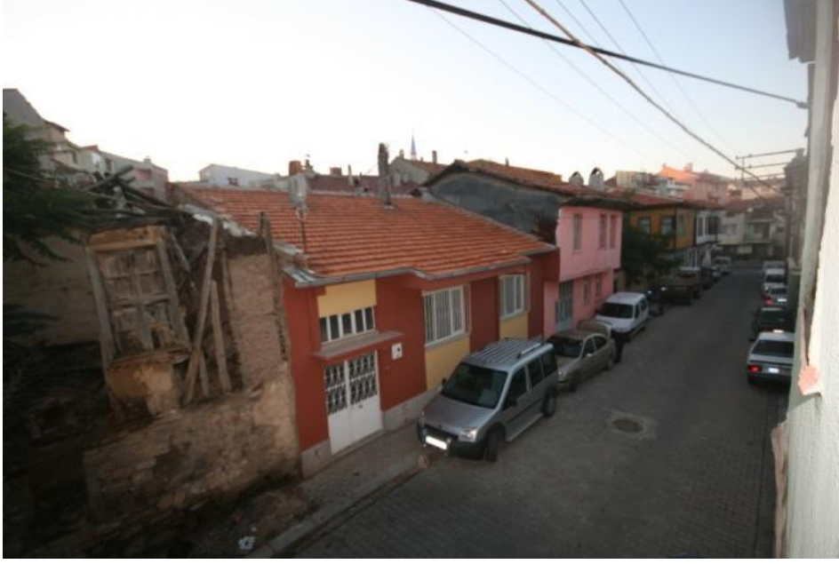
Şekil 5.58; 8 Parsel 5 Kapı numaralı yapının çatısı
