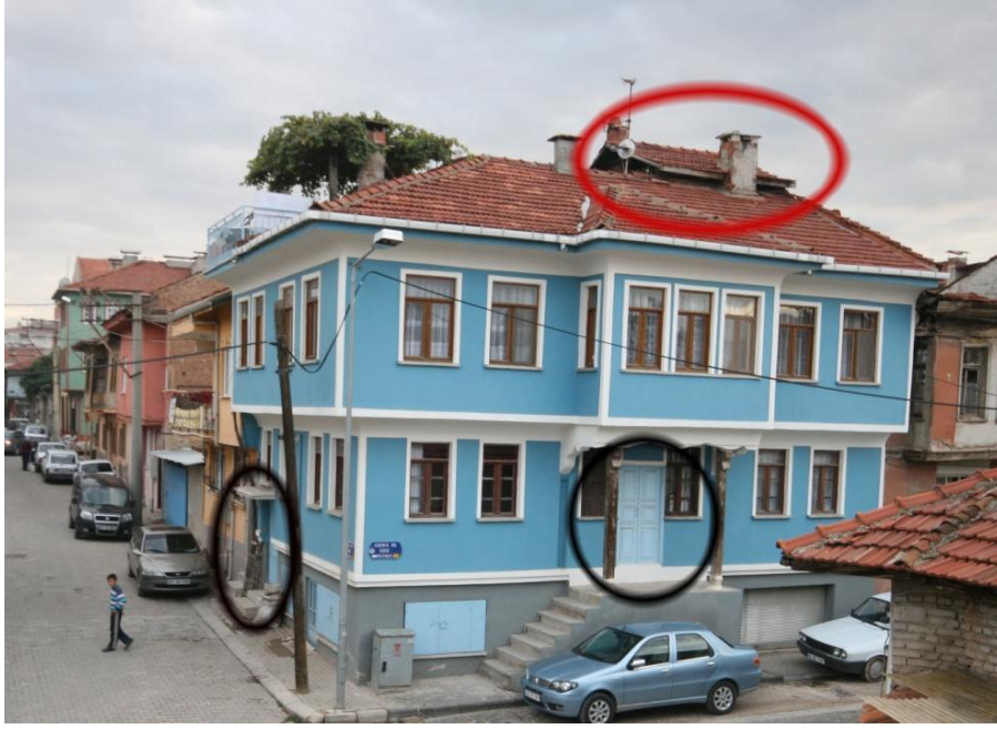
Şekil 5.2: 6-16 parsel 29 Kapı Numaralı Yapı yapının giriş kapıları görünüşü ve çatıda bulunan ek katın görünüşü
