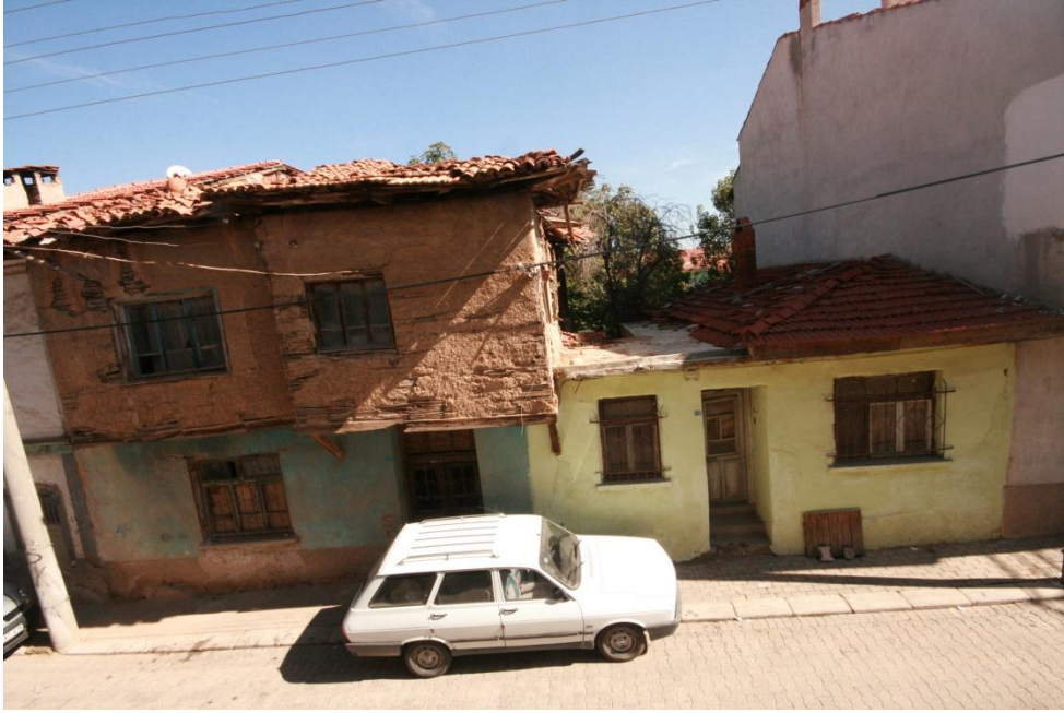
Şekil 5.74; 23 parsel 16-18 kapı numaralı yapının Gün Sokak görünüşü
