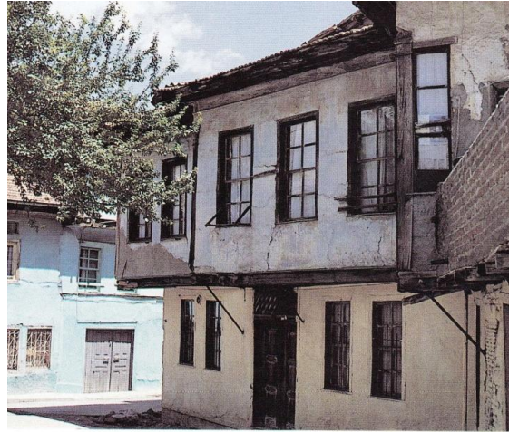
Şekil 3.30; Yuvarlak Çıkma Tipine Örnek( Sayan, 1997: 21)
