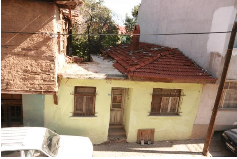
Şekil 5.73; 23 parsel 18 kapı numaralı yapının Gün Sokak görünüşü
