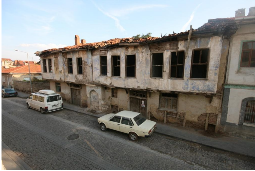
Şekil 5.19; 2 Parsel 47-49 kapı numaralı yapıların cephe görünüşleri
