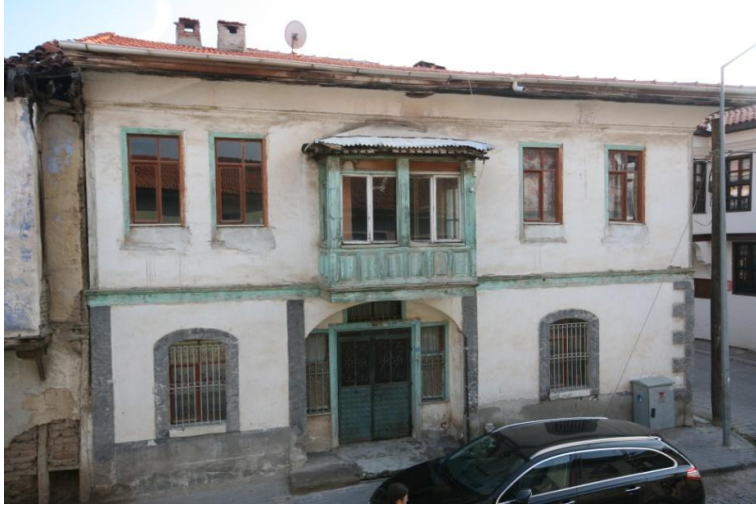
Şekil 5.21; 2 Parsel 51 kapı numaralı yapının cephe görünüşler
