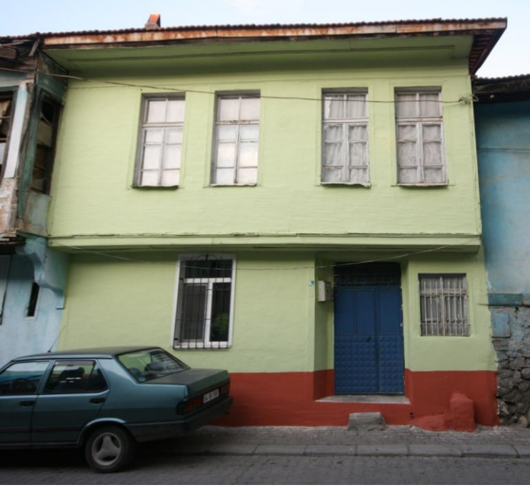
Şekil 5.88; 16 parsel 4 kapı numaralı yapının Gün Sokak görünüşü
