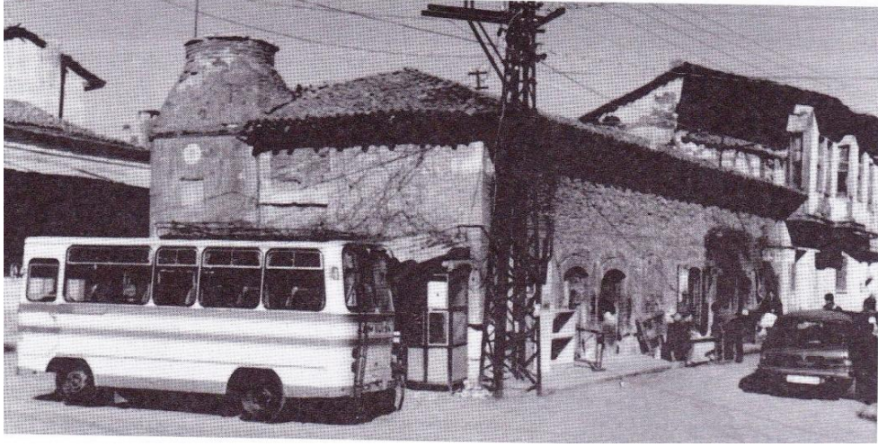
Şekil 2.35: Kırık Minare batı cephesi görünüşü (Keyvanoğlu, 2012:6)
