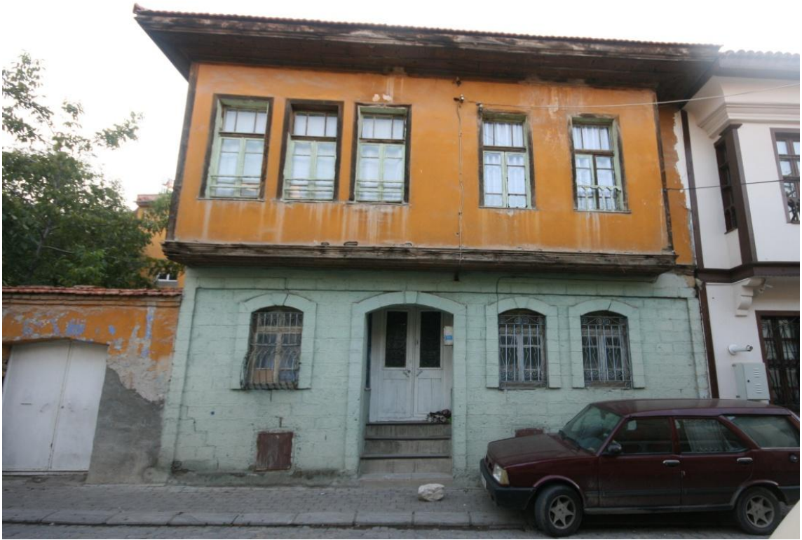
Şekil 5.65; 5 parsel 11 Kapı Numaralı Yapının Gün Sokak görünüşü
