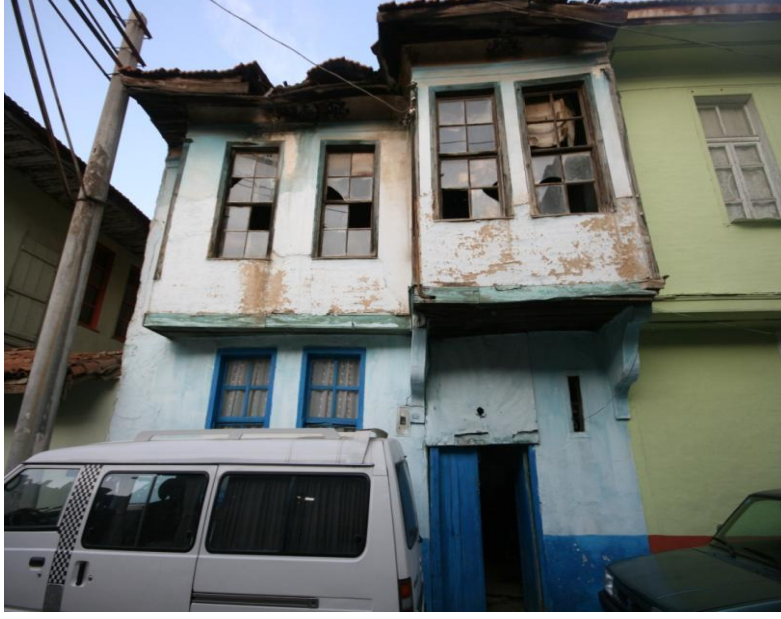
Şekil 5.86; 17 parsel 6 kapı numaralı Yapının Gün Sokak görünüşü
