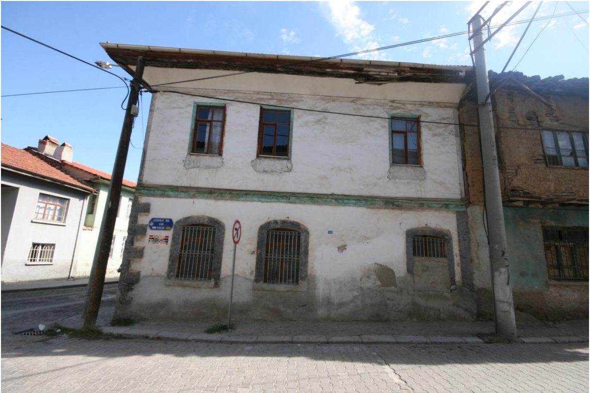
Şekil 5.70; 21 parsel 13 kapı numaralı yapının Gün Sokak görünüşü
