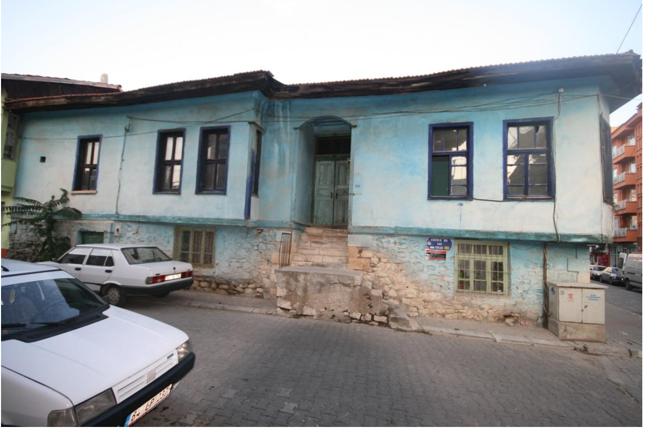
Şekil 5.90; 16 parsel 2 kapı numaralı yapının Gün Sokak Görünüşü
