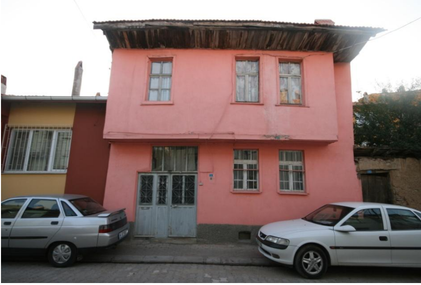
Şekil 5.61; 7 parsel 7 kapı numaralı yapının Gün Sokak görünüşü
