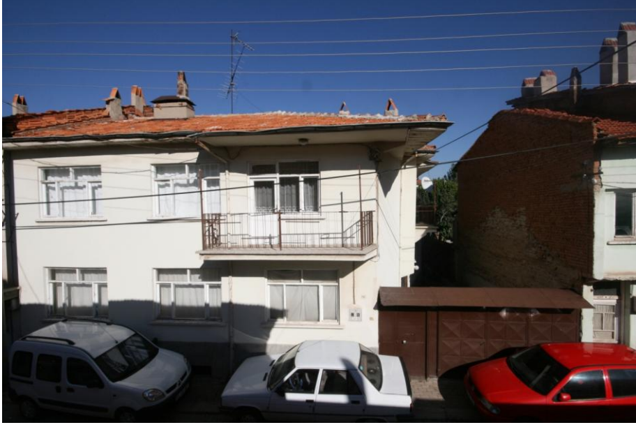
Şekil 5.78; 20-25 parsel 12 Kapı numaralı yapının Gün Sokak görünüşü
