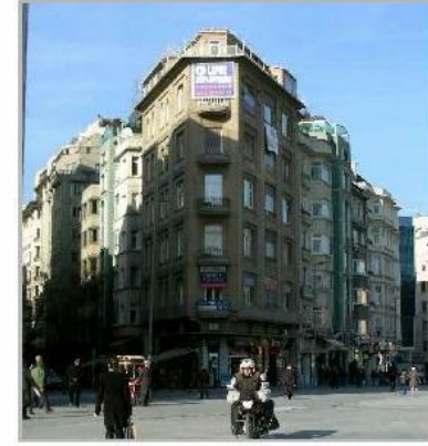
Pertev Apartmanı, Ana Cephe, Beyoğlu / İstanbul
