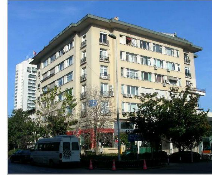
Kervansaray Apartmanı, Ana Cephe, Şişli / İstanbul
