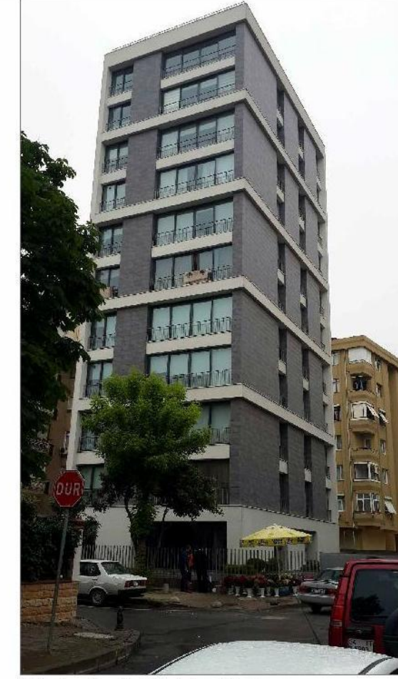
Ada Apartmanı, Ön ve Yan Cephe, Bostancı / İstanbul Kaynak: Tuğçe EREN
