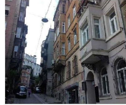
Casaretto Apartmanı, Galata / İstanbul Kaynak: Tuğçe EREN
