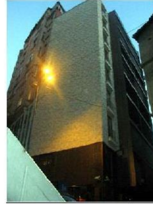
Belkis Apartmanı, Yan Cephe, Galata / İstanbul Kaynak: Tuğçe EREN
