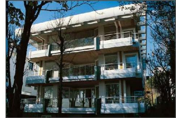
Fazilet Apartmanı, Ana Cephe, Çiftelavuzlar, Kadıköy / İstanbul Kaynak: (Arkiv, 2008) -
