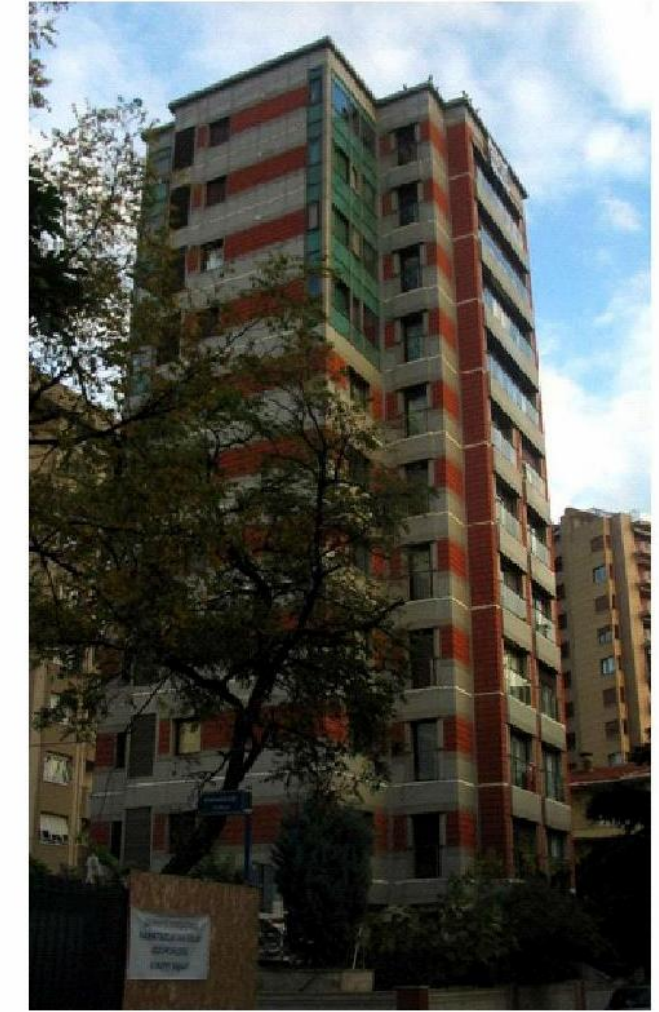
Deniz Apartmanı, Yan Cephe, Kalamış, Kadıköy / İstanbul
