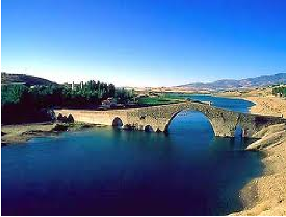
Resim 3.2. Antakya Görüntüsü- Asi Nehri Üzeri Taş Köprü
