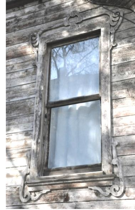
Şekil 3.91: (Solda): Sarıyer Tarihi Köyiçi'nde 1/2 oranda giyotin pencere örneği, Ortaçşeme Caddesi No: 47 (Kaptanoğlu, 2013).
