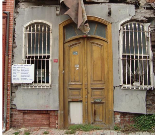
Şekil 3.85 (Solda): Sarıyer Tarihi Köyiçi'nde yan pencerele çift kanatlı kapıya bir örnek, Dursun Fakih Sokak yapı No: 29 (Kaptanoğlu, 2013).
