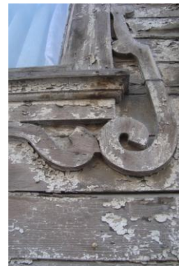
Şekil 6.68 (Solda): Cephede çıkma altındaki ahşabın yer yer koyulaşması ve beyazlaşmasına örnek (Kaptanoğlu, 2104).
