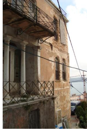
Şekil 3.48: Yenimahalle'den demir putrel destekli tuğla yığma yapı örneği, Ocak Ağası Sokak No: 4 (Kaptanoğlu, 2013).
