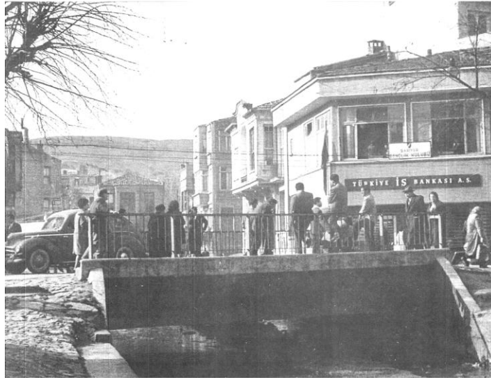
Şekil 2.29: Sarıyer Deresi üzerindeki köprü görünüşü (Mimar Salih İleri Arşivi 9 ).
