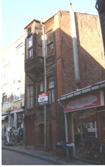
Şekil 3.6 (Solda): Sarıyer Tarihi Köyiçi, Dursun Fakih Sokak No:38'de yer alan yapının yangın duvarı (Kaptanoğlu, 2013).
