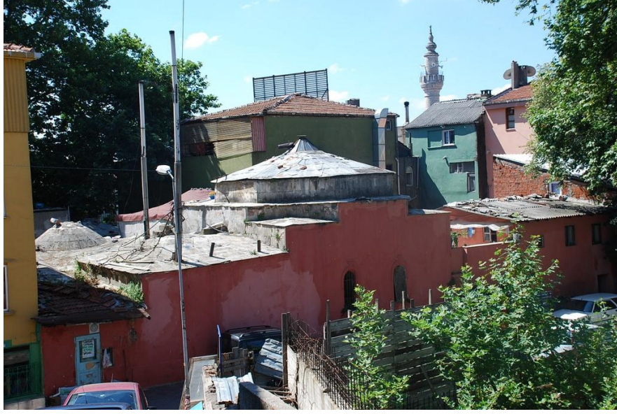
Şekil 2.47: Yapının Hamam Sokak cephesi ( http://www.envanter.gov.tr , Mayıs 2014).
