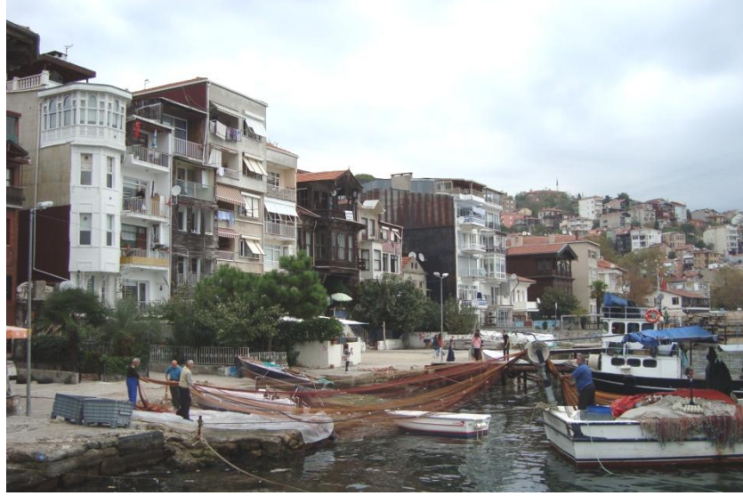
Şekil 3.74: Günümüzde beton kaplı taş rıhtımın gerisine konumlanan kıyı hattındaki yapılar (Kaptanoğlu, 2013).
