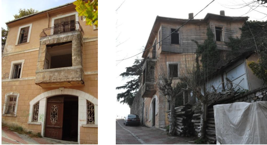
Şekil 3.62: Yenimahalle'de az değişmiş yapı örneği, Yeni Selimiye Sokak No: Bilinmiyor.
