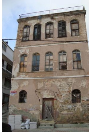
Şekil 3.48: Yenimahalle'den demir putrel destekli tuğla yığma yapı örneği, Ocak Ağası Sokak No: 4 (Kaptanoğlu, 2013).
