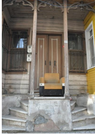
Şekil 3.85 (Solda): Sarıyer Tarihi Köyiçi'nde yan pencerele çift kanatlı kapıya bir örnek, Dursun Fakih Sokak yapı No: 29 (Kaptanoğlu, 2013).
