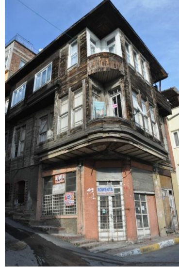
Şekil 3.49 (Solda): Sarıyer Tarihi Köyiçi'nde karma sistemli yapı örneği, Dursun Fakih Sokak No: 31/1 (Kaptanoğlu, 2013).
