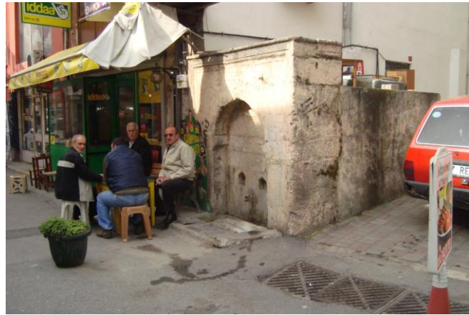
Şekil 2.63: Günümüzde Tekke Çeşmesi'nin Yenimahalle Caddesi'nden görünüşü (Kaptanoğlu, 2013).
