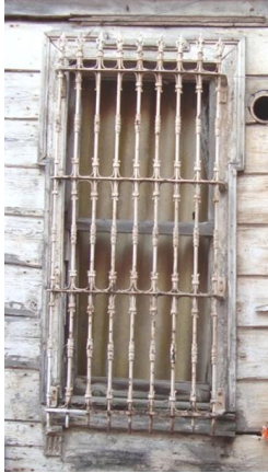
Şekil 3.91: (Solda): Sarıyer Tarihi Köyiçi'nde 1/2 oranda giyotin pencere örneği, Ortaçşeme Caddesi No: 47 (Kaptanoğlu, 2013).
