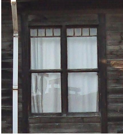
Şekil 3.94 (Solda): Sarıyer Tarihi Köyiçi'nde 1/2 oranda iki birimli giyotin pencere örneği, Atabey Sokak No: 17 (Kaptanoğlu, 2013).
