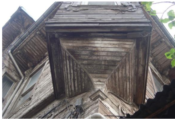
Şekil 6.68 (Solda): Cephede çıkma altındaki ahşabın yer yer koyulaşması ve beyazlaşmasına örnek (Kaptanoğlu, 2104).
