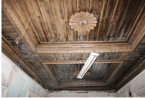
Şekil 6.64 (Solda): Zemin katta ahşap tavanın kararmasına bir örnek (Kaptanoğlu, 2014).
