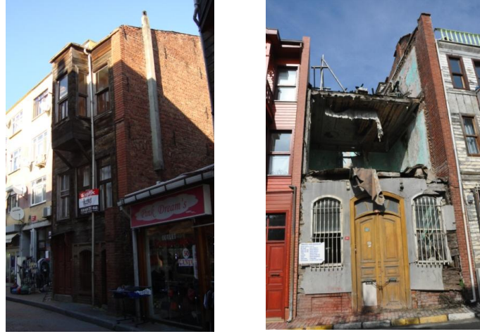
Şekil 3.46 (Solda): Sariyer Tarihi Köyiçi'nde, yangın duvarlarına örnek, Dursun Fakih Sokak No: 38 (Kaptanoğlu, 2013).
