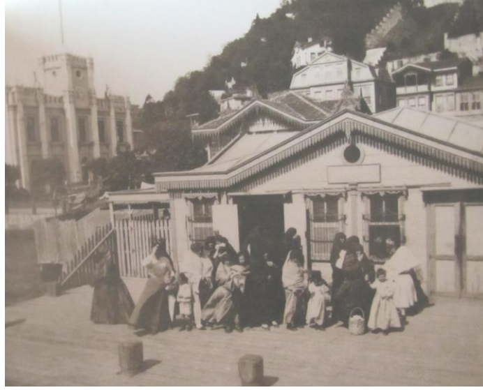
Şekil 2.7: 1910 yılında Mesarburnu Vapur İskelesi, Sarıyer Merkez Mahalle'nin iskelesi (Genim, 2006: 793; Anonim, 1910).
