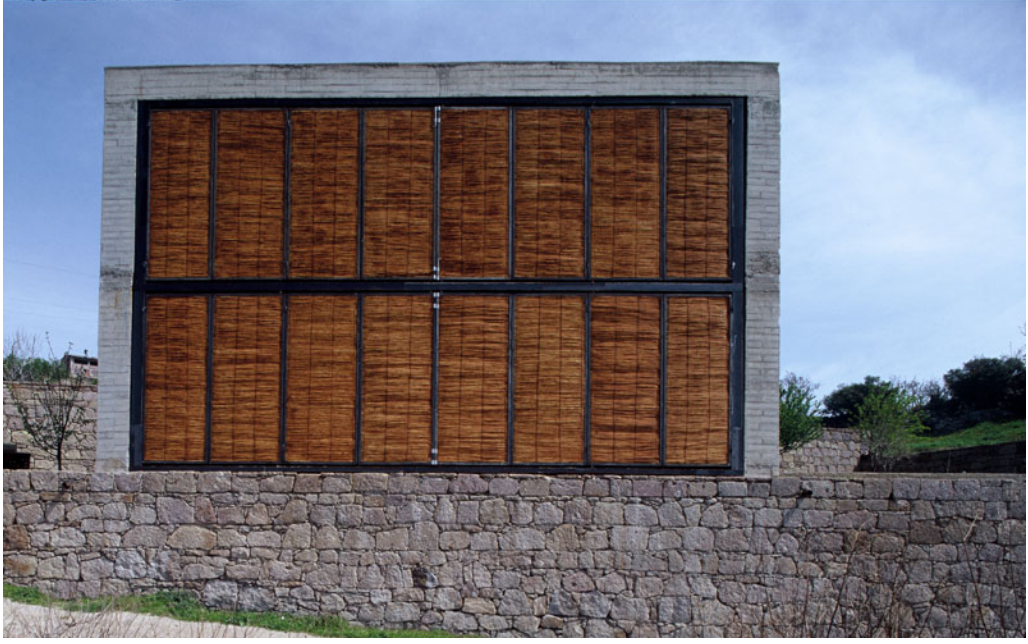
Şekil 3. 41. B2 Evi, Ön Görünüş/Güneş Kontrolü Elemanları Kapalı,-Güney, ( http://www.arkiv.com.tr/proje/b2-evi/1858 ).
