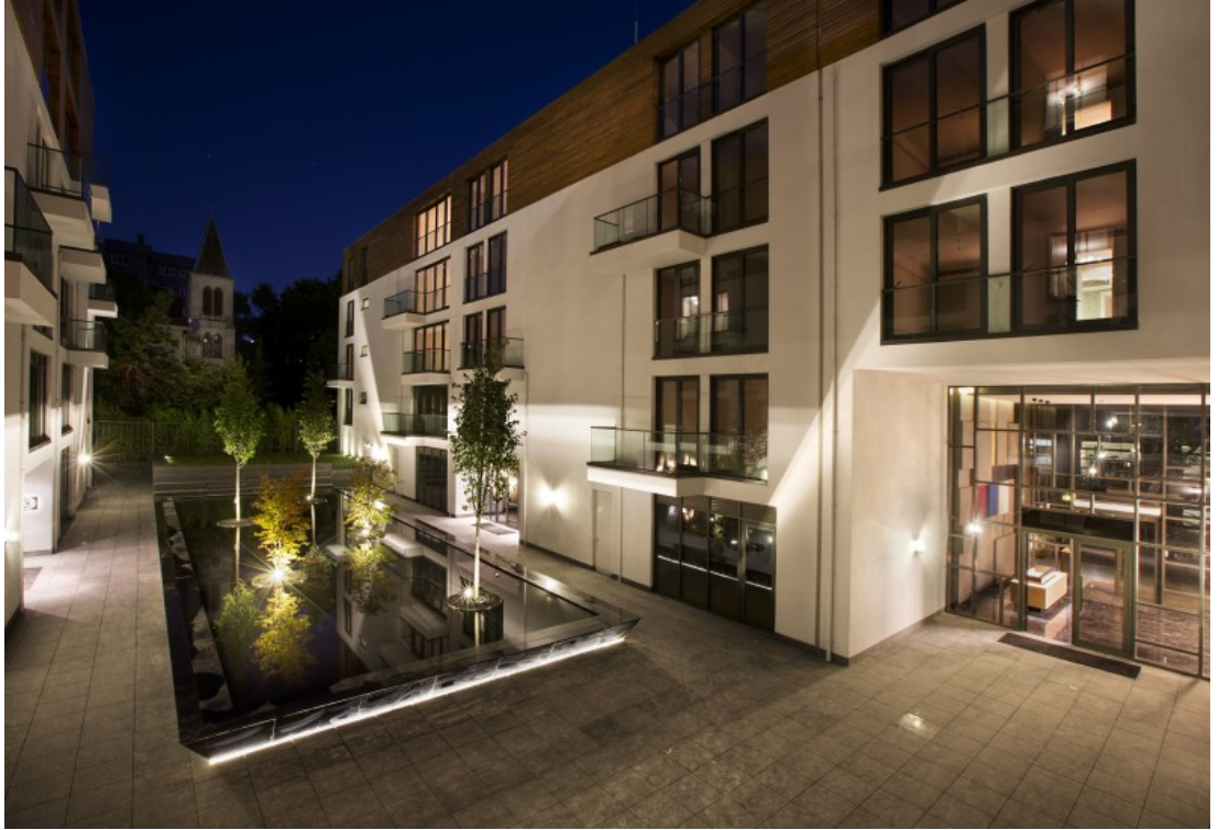
Şekil 6. 3. Tekfen Bomonti Apartmanları – Gündüz Görünüş ( http://www.dbarchitects.com.tr )
