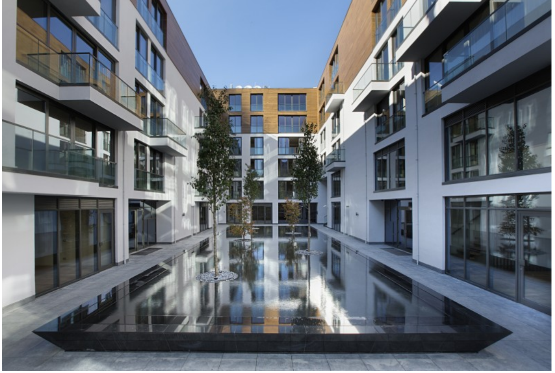
Şekil 6. 2. Tekfen Bomonti Apartmanları – Gündüz Görünüş ( http://www.dbarchitects.com.tr )
