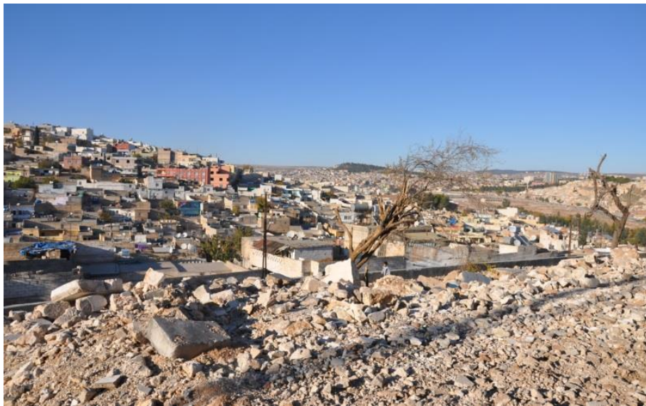
Şekil 4.40 Yıkımlardan Sonra Alanın Görünümü (F. Nihan Kahya Arşivi)
