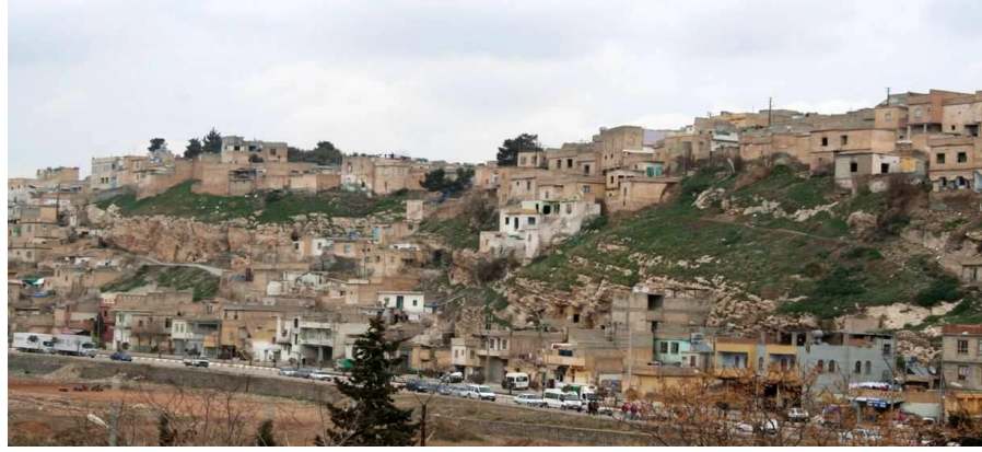
Şekil 4.42 Alanın Yıkılmadan Önceki Hali (Şanlıurfa Belediyesi, 2013)
