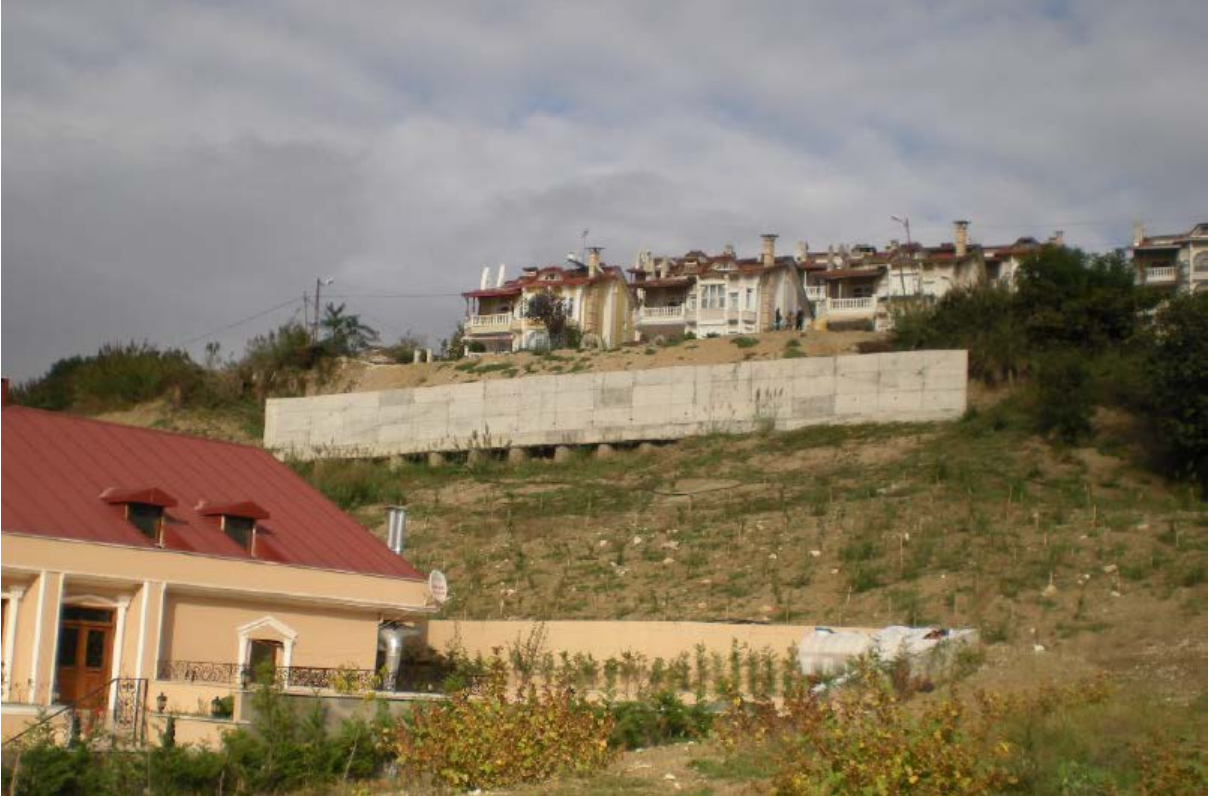
Şekil 2.15: Gürpınar ilçesi Pınarkent mevkiinde kitle hareketlerinin kontrolü için yapılan uygulamalar (İmre, 2011)
