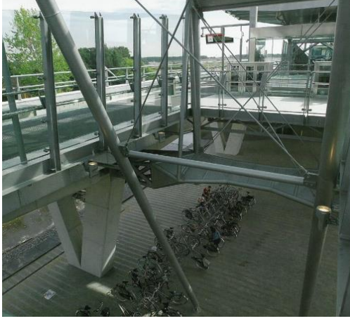
Resim 3.15: Nesselande Metro İstasyonu'nda şeffaflık (Uffelen, 2010)
