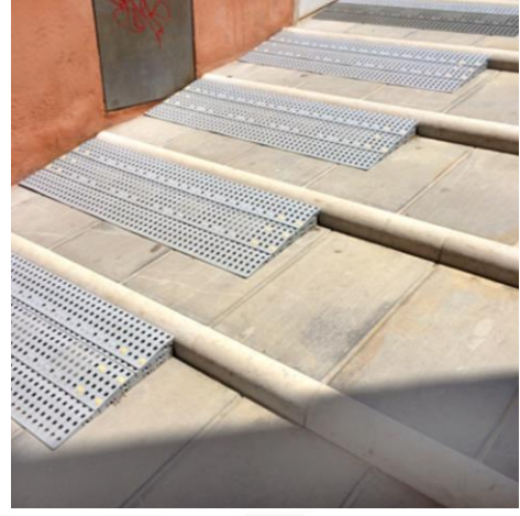
Resim 3.7: İtalya'da tarihi köprüde çelik rampa (Enginöz, 2015a)
