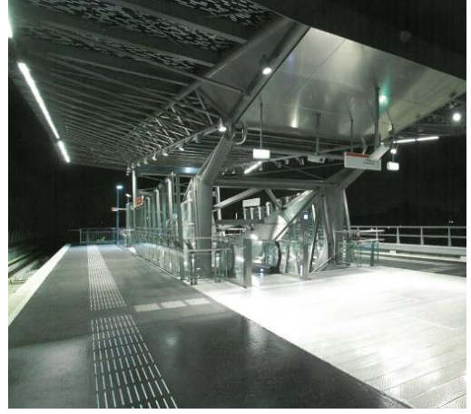
Resim 3.16: Nesselande Metro İstasyonu peron kaplaması (Uffelen, 2010)
