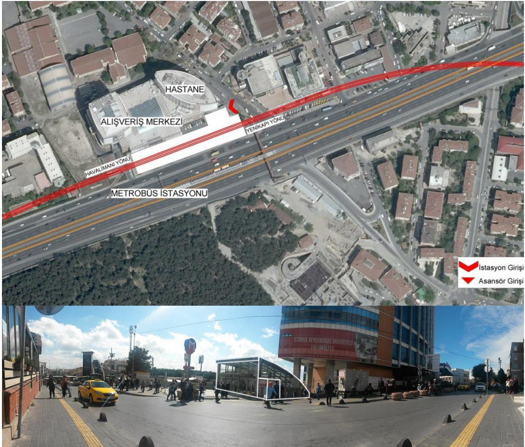
Resim 4.24: Bahçelievler İstasyonu hava fotoğrafı ve yakın çevresi
