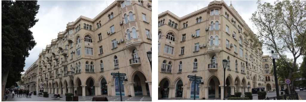
Şekil 3.14. “Azneftzavod” Apartmanının GörSELLERİ
