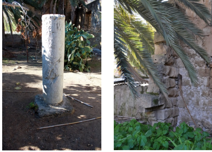
Şekil 3.27: A-03 avlusundaki taş sütun ve kapı izi (2015)
