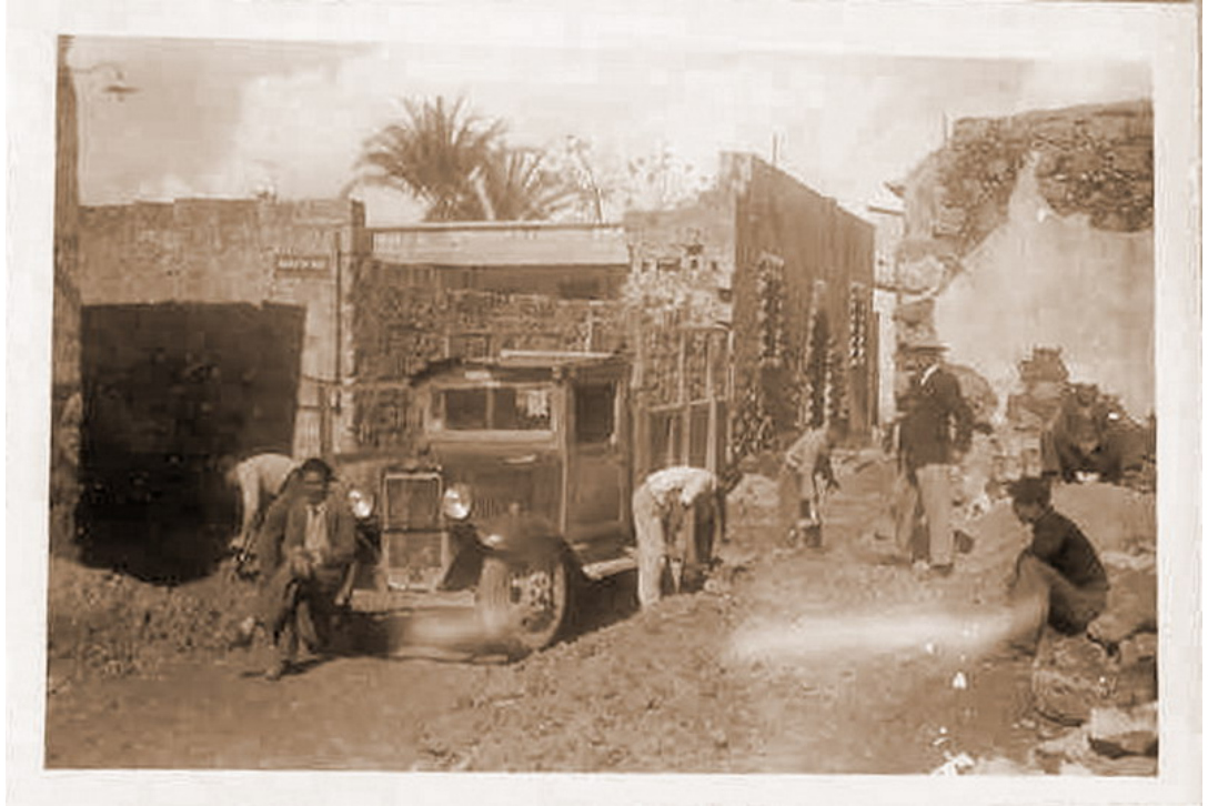
Şekil 4.18: T. Mogabgab yürütücülüğünde gerçekleştirilen restorasyonlar, Naim Efendi Sokak üzerinde yapılan yol çalışmaları
