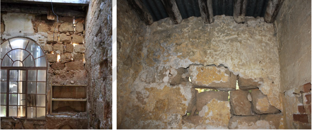
Şekil 3.84: Z-02 mekanı güneybatı duvarı ile Z-05 mekanı güneybatı duvarında görülen derz boşalmaları (2015)
