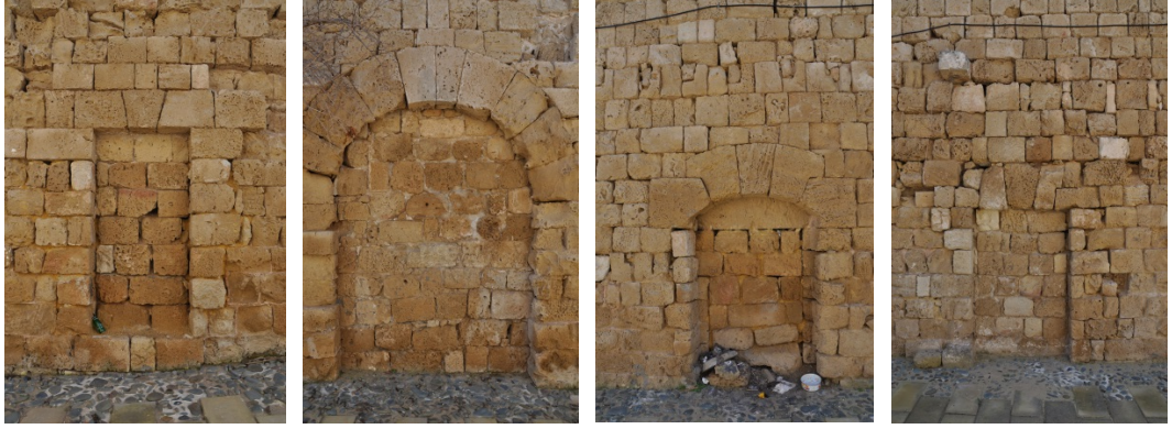
Şekil 3.61: Kuzeybatı avlu cephesinde zemin kat seviyesinde yer alan kapatılmış kapı-pencere açıklıkları (2015)
