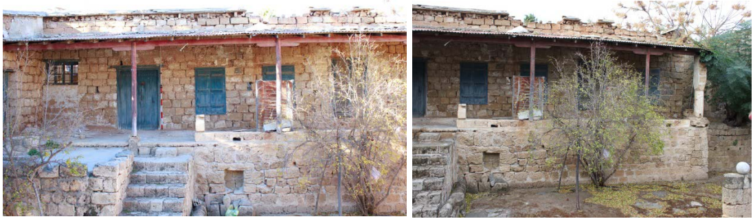
Şekil 3.66 : Ana Yapı (1 No'lu Yapı) – Güneydoğu Cephesi (2015)
