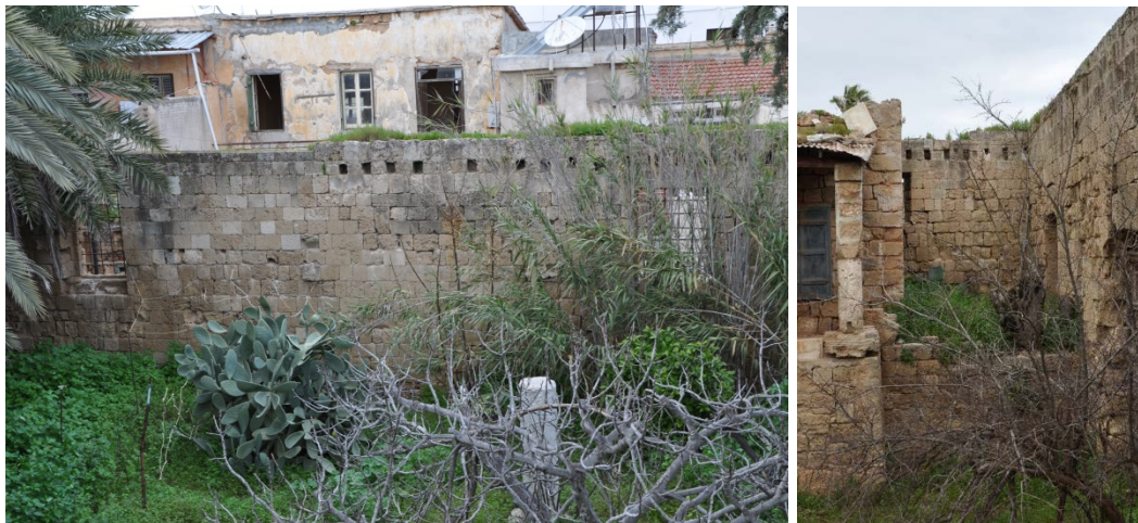
Şekil 4.9: A-03 avlusunun kuzeybatı cephesindeki giriş izleri (2015)
