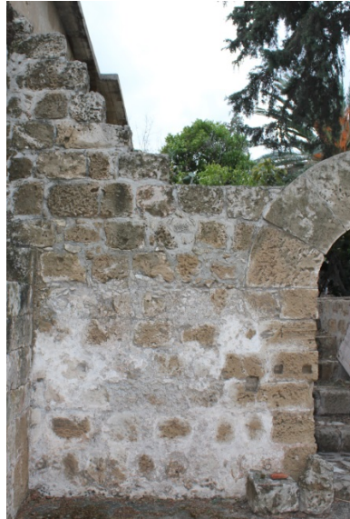
Şekil 3.74: A-01 avlusu güneybatı cephesinde tuzlanma örneği (2015)
