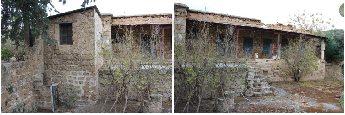
Şekil 3.11: A-01 Avlusu sınırında yer alan Ana Yapı - 1 No'lu Yapı (2015)
