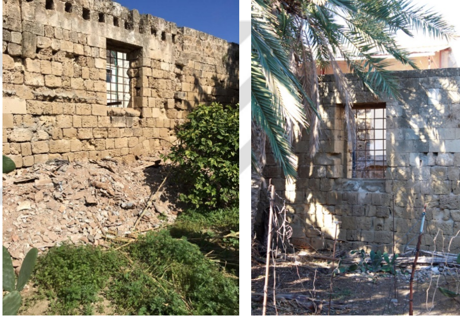
Şekil 3.25: A-03 avlusu kuzeybatı duvarındaki pencere görünüşleri (2015)
