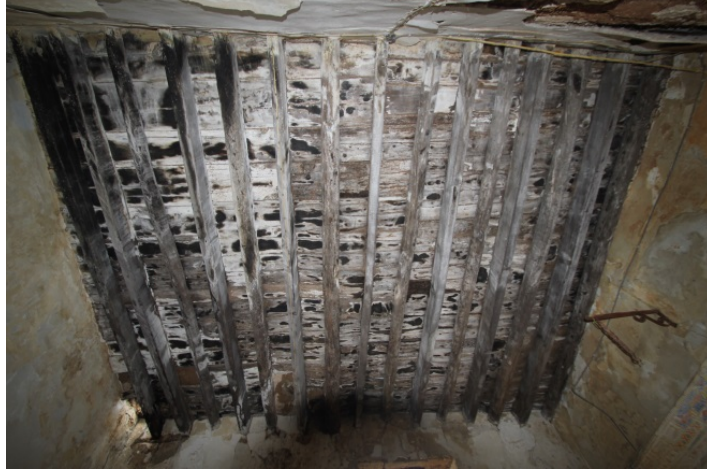
Şekil 3.34: Z-01 mekanın taşıyıcı sistem elemanı olan kirişleri (2015)
