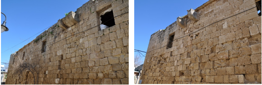
Şekil 4.11: Kuzeybatı avlu cephesindeki taş konsollar (2015)
