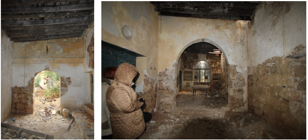
Şekil 3.30: Z-01 mekanı-kuzeydoğu ve güneybatı görünüşü (2015)
