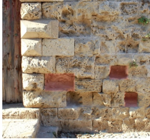
Şekil 3.77: A-03 avlusunun kuzeybatı cephesi ile kuzeydoğu avlu duvarında görülen duvardaki eksik taşlar (2015)
