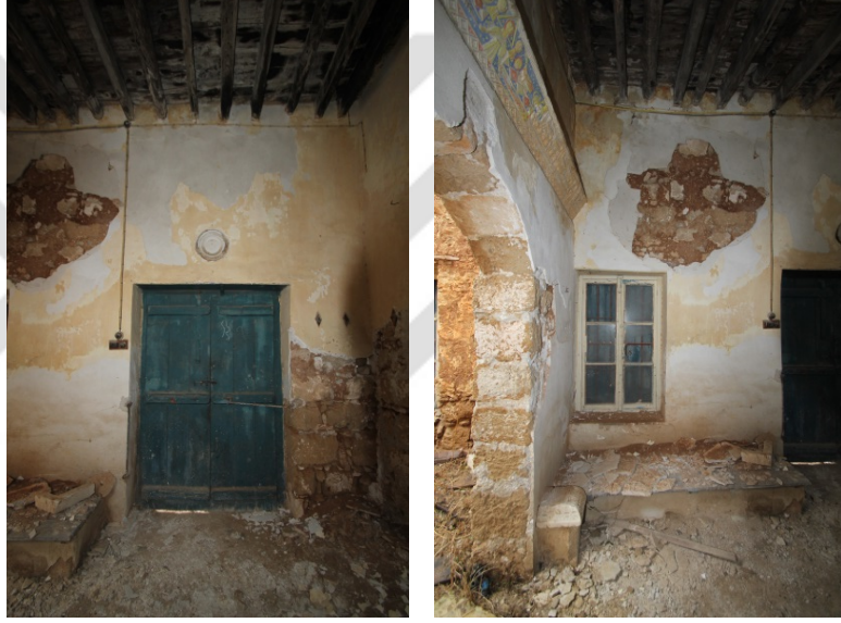
Şekil 3.32: Z-01 mekanı-güneydoğu görünüşü (2015)
