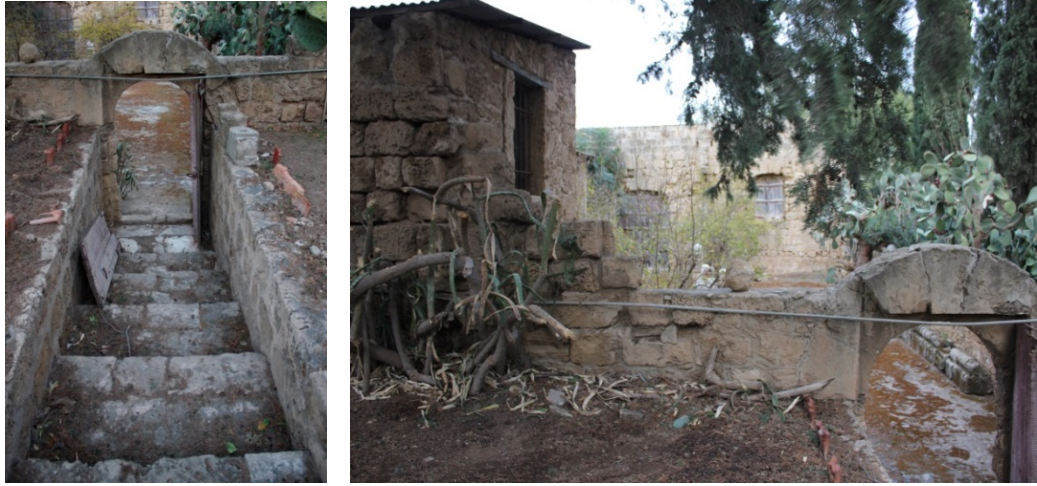
Şekil 3.20: A-03 avlusuna giriş merdivenleri (2015)
