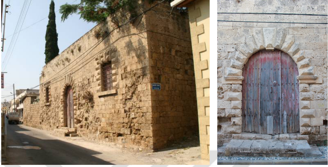
Şekil 3.55: Kuzeydoğu avlu cephesi (2015)
