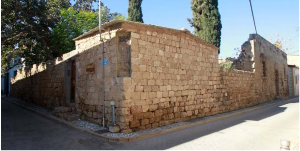
Şekil 3.54: Kuzeydoğu avlu cephesi (2015)
