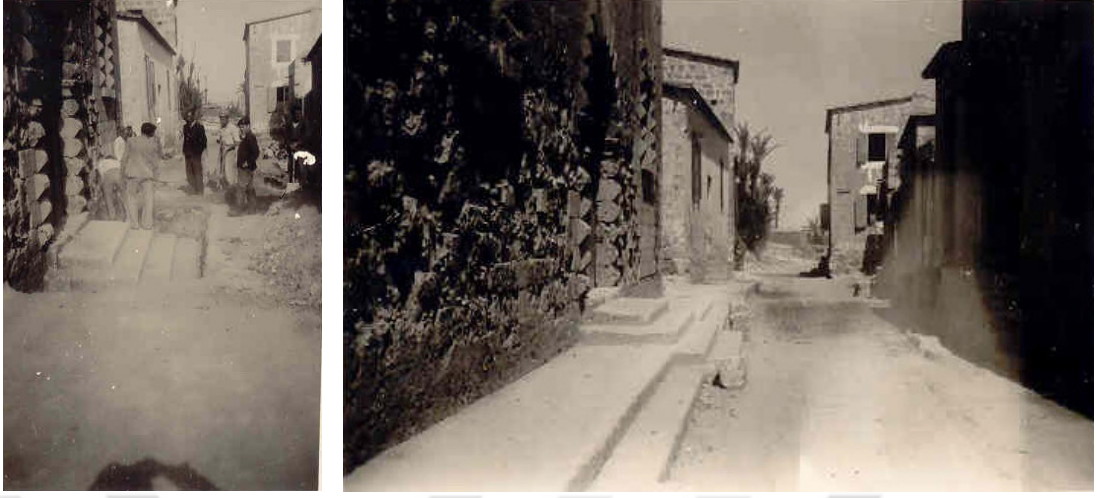
Şekil 4.19: T. Mogabgab yürütücülüğünde gerçekleştirilen restorasyonlar, Naim Efendi Sokak üzerinde yapılan yol kotunu indirme çalışmaları sonucu
