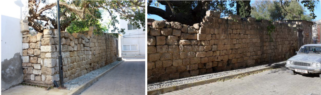
Şekil 3.58 : Bedesten Sokak üzerindeki güneydoğu avlu cephesi (2015)
