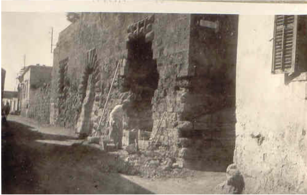
Şekil 4.16: T. Mogabgab yürütücülüğünde gerçekleştirilen restorasyonlar, Kapatılmış kapı-pencere açıklıklarının yeniden açılması çalışmaları, 1941-1942
