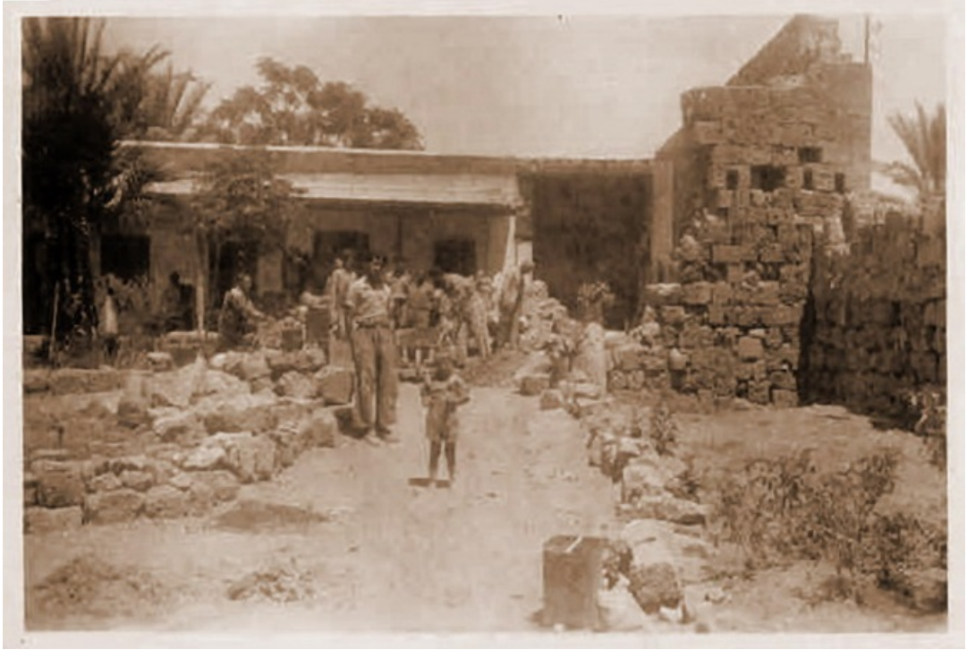
Şekil 4.20: T. Mogabgab yürütücülüğünde gerçekleştirilen restorasyonlar, Venedik Evi'nde avlu kotunda kazı çalışmaları yapılmadan önceki durum
