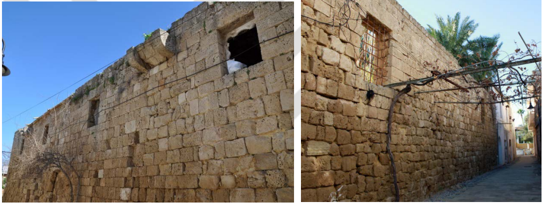
Şekil 3.62: Kuzeybatı avlu cephesinde birinci kat seviyesinde yer alan pencereler (2015)
