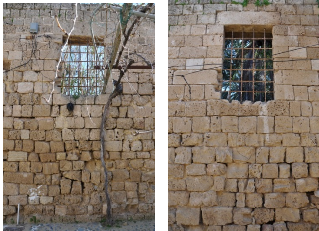
Şekil 3.63: Kuzeybatı avlu cephesinde birinci kat seviyesinde yer alan pencereler
