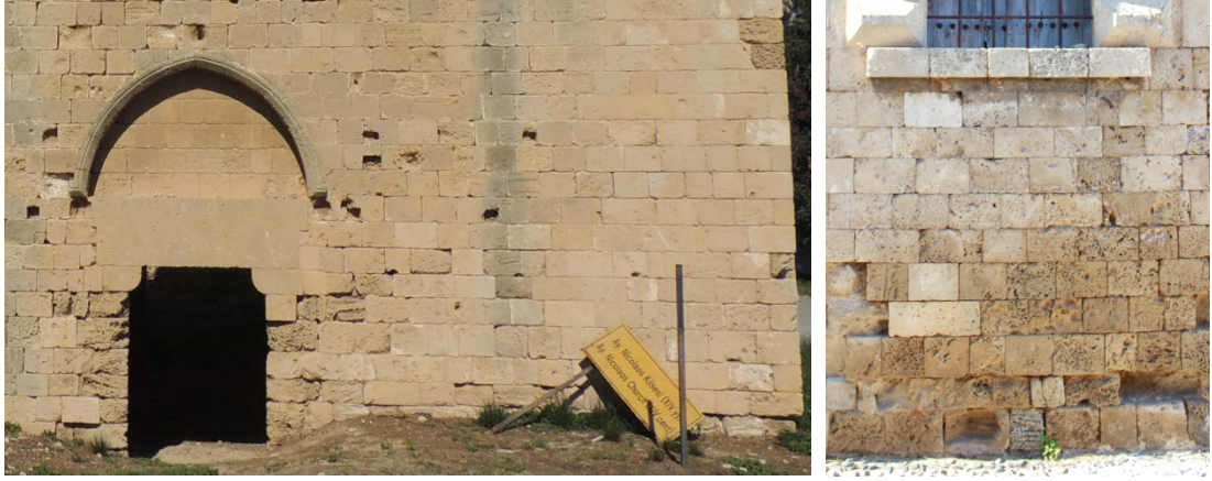
Şekil 4.6: Ay. Nicolaos Kilisesi ve Venedik Evi'nin duvar örgüsü karşılaştırılması (famagustawalledcity.net)
