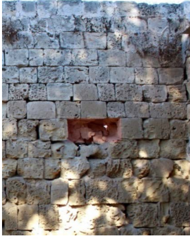
Şekil 3.77: A-03 avlusunun kuzeybatı cephesi ile kuzeydoğu avlu duvarında görülen duvardaki eksik taşlar (2015)
