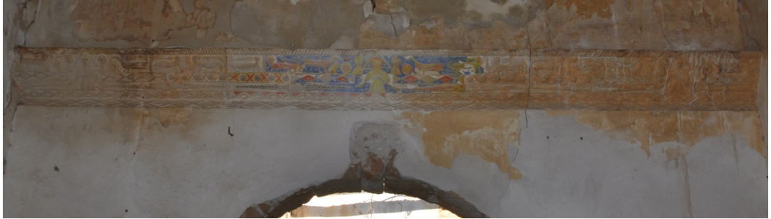
Şekil 3.33: Z-01 mekanı-kuzeydoğu yönündeki duvar üzerinde yer alan sergen ve freskolar (2015)
