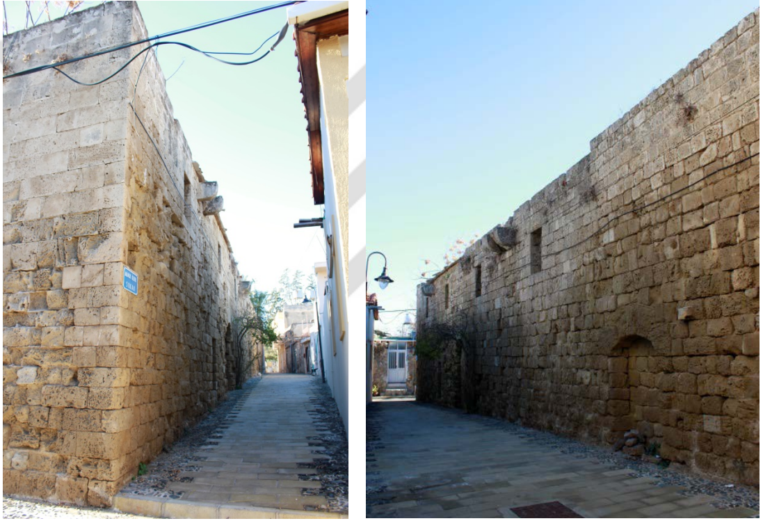
Şekil 3.60 : Kuzeybatı avlu cephesi (2015)
