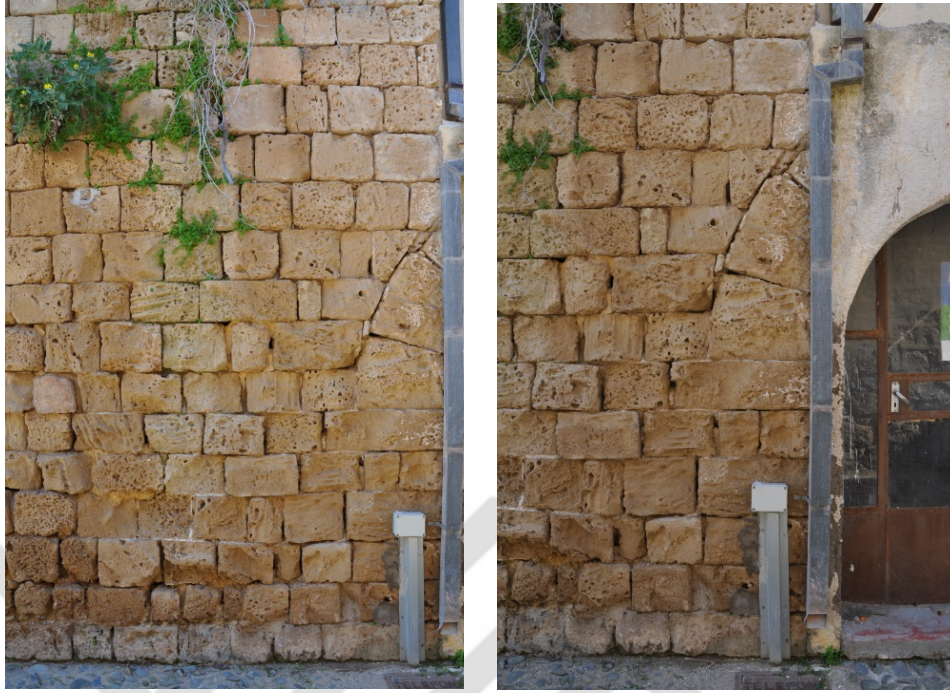
Şekil 4.4: Kuzeybatı avlu cephesinin, güneybatı kenarında bulunan kemer başlangıcına ait iz (2015)
