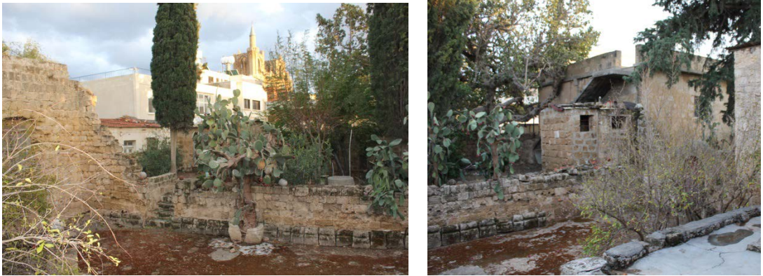
Şekil 3.12: A-01 Avlusu güneydoğu sınırı (2015)
