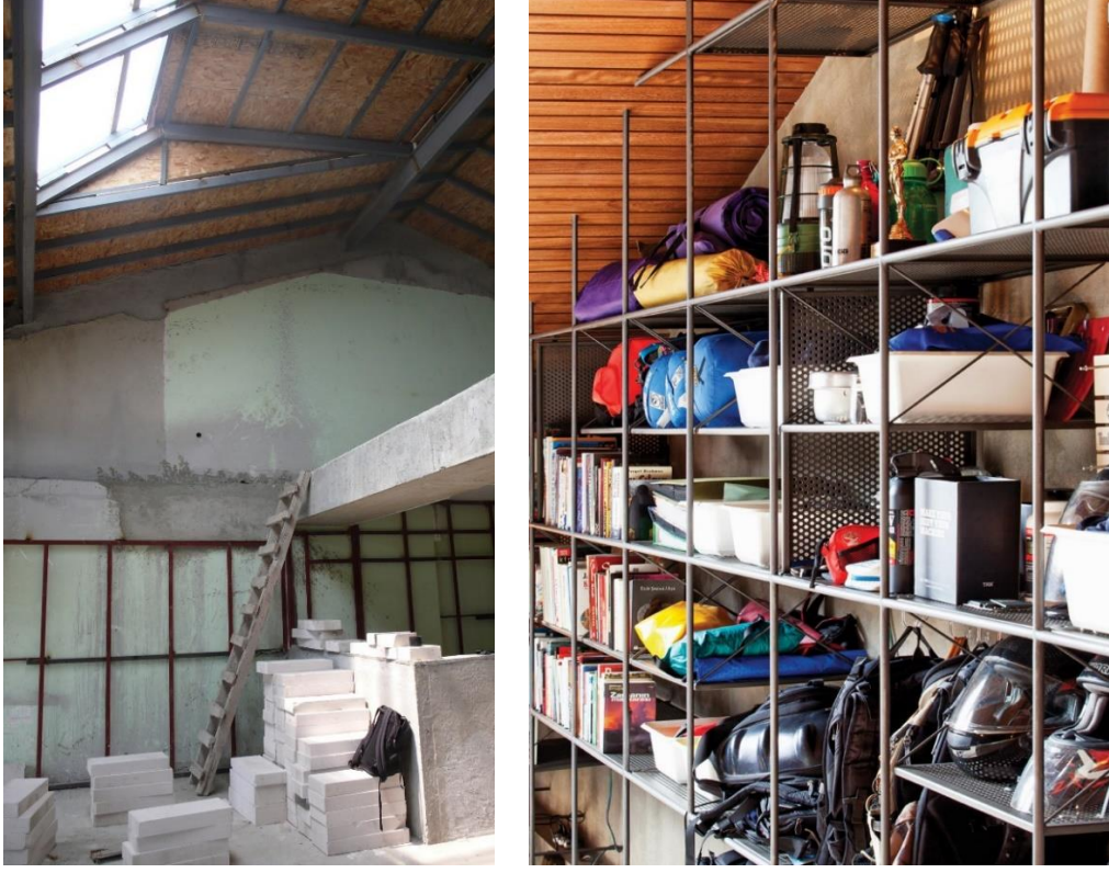
Şekil 4.48.49: Karaköy Loft İç Mekân Görünüşü – Raf Sistemi
