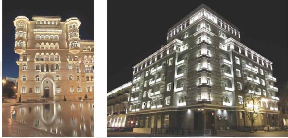
Şekil 6.24. Eski Konut Binalarının Cephelerinin Aydınlatılması.
