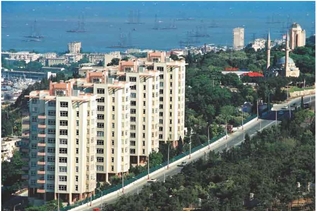
Şekil 6.3. Bayholding İnşaat Şirketi'nin 2000 Yılında Bakü'de İnşa Ettiği Konut Binaları. (Qasımzade, 2013).
