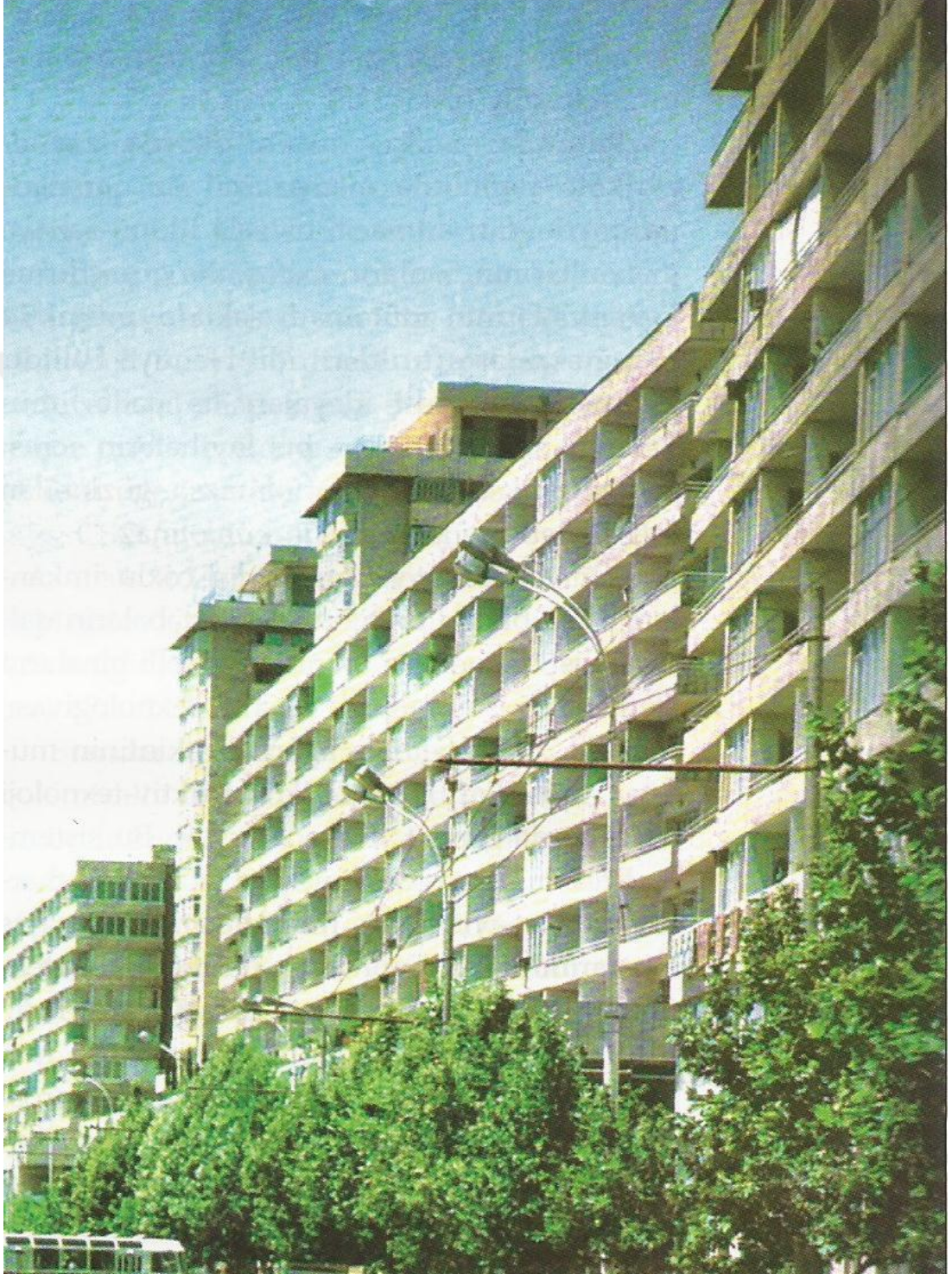
ekil 5.20. Bak'de Panel Konut Binaları. (Nađıyev, Hseynov, 2013)
