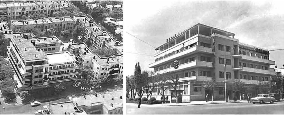
Şekil 5.6. Mahalle-komünü Sisteminde İnşa Edilen Galeri Tip Konut Binası.
