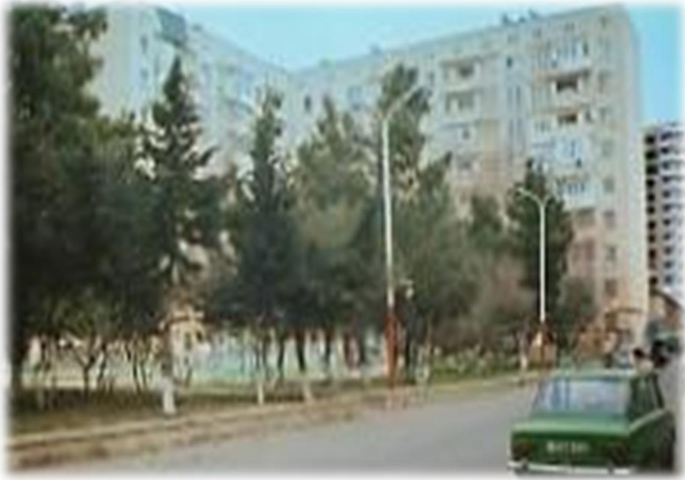
Şekil 6.2. Deneysel Projeler Kapsamında İnşa Edilen Konut Binası.
