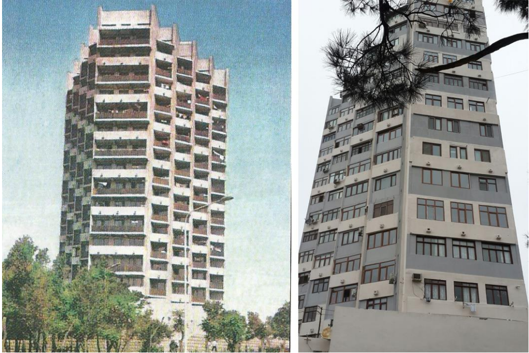
Şekil 5.25. Tibilisi Caddesi'nde Bulunan 18 Katlı Konut Binası'nın Cephe Görünümü.
