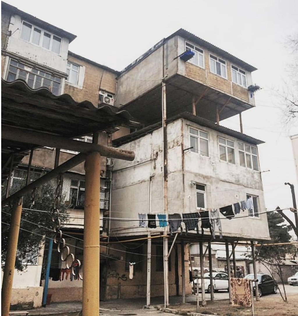
Şekil 6.26. Beş Katlı Konut Binalarında Uygulanan Çıkmalar. (Kamran 2016)
