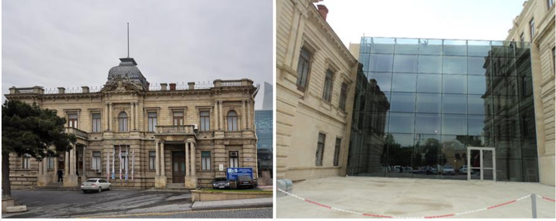
Şekil 4.30. Niyazi Sokağındaki Konut Binası ve Eklenen Bölüm. ( http://az.trend.az/azerbaijan/culture/2095669.html ), (17.12.2015)
