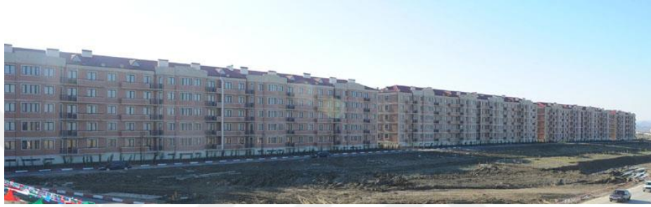
Şekil 6.1. Göçmenler İçin İnşa Edilmiş Konut Binaları.
