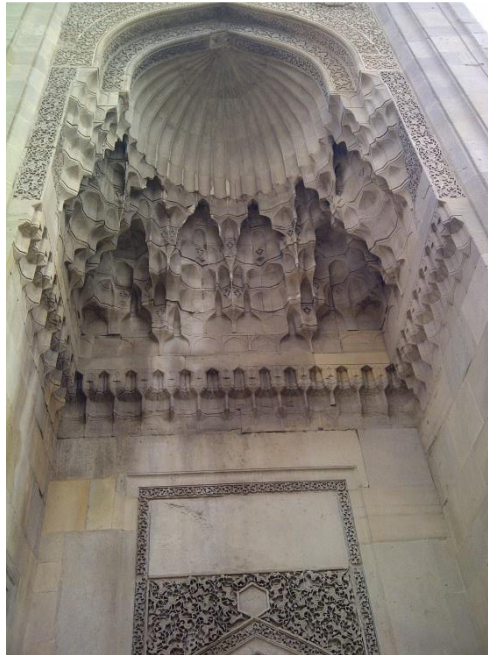
Şekil 3.8. Saray Binası. Sarayın Giriş Bölümü. (Garayeva N., 2013)
