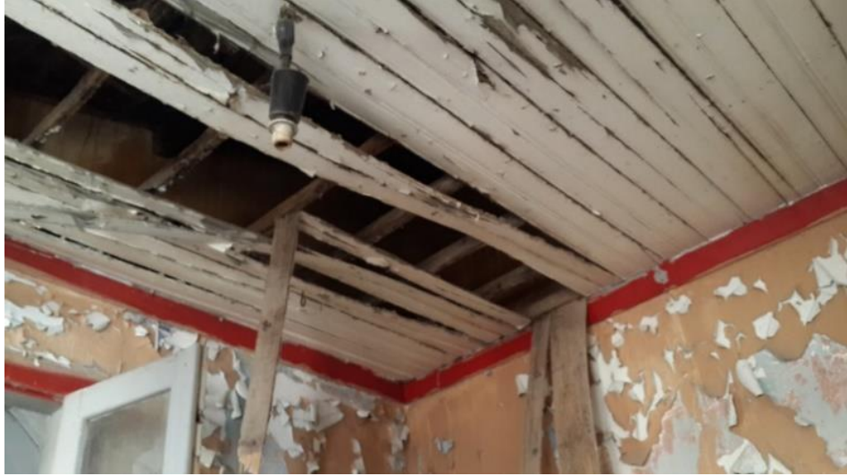
Şekil 4.39: Z03 mekânının tavan kaplaması (Konuk, Kuşadası, 2016).
