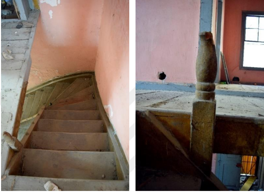
Şekil 4.108: Soldan sağa, M01 ahşap merdivenine 101 sofadan bakış ve merdivenin korkuluğu (Konuk, Kuşadası, 2016).
