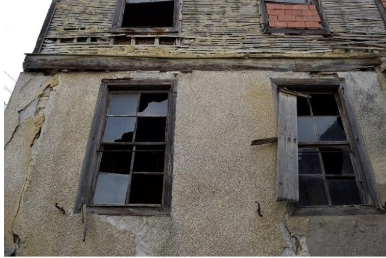
Şekil 4.82: Bahçeden doğu cephesinin zemin kat hizasına bakış (Konuk, Kuşadası, 2016).
