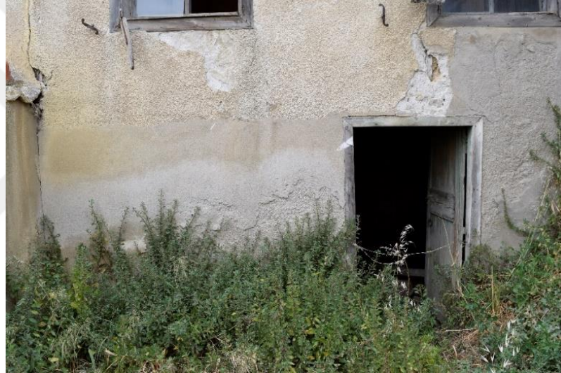
Şekil 4.83: Bahçeden doğu cephesinin bodrum kat hizasına bakış (Konuk, Kuşadası, 2016).
