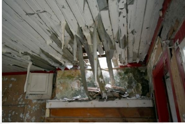
Şekil 4.44: Yukardan aşağı, Z04 mekânının ahşap tavan kaplaması ve mekânın doğu yönünde çöken tavan bölümü (Konuk, Kuşadası, 2016).
