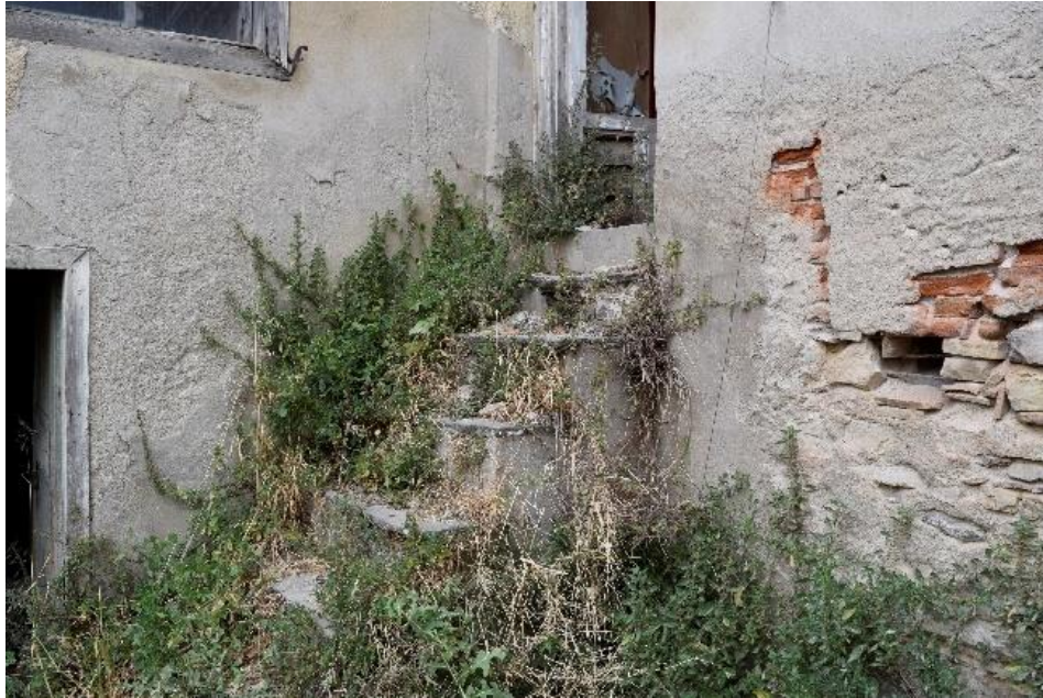
Şekil 4.109: Bahçenin kuzeybatı köşesindeki merdiven (Konuk, Kuşadası, 2016).
