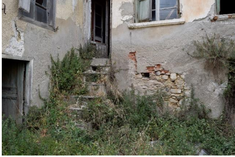
Şekil 4.89: Bahçe kuzey duvarı Z02 hol ile bağlantıyı sağlayan merdiven (Konuk, Kuşadası, 2016).
