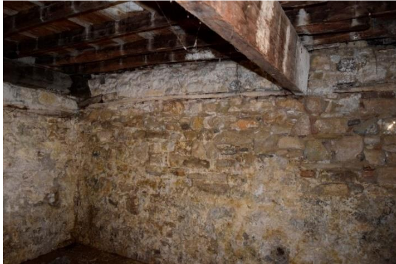
Şekil 4.13: B01 mekânı kuzey duvarı (Konuk, Kuşadası, 2016).
