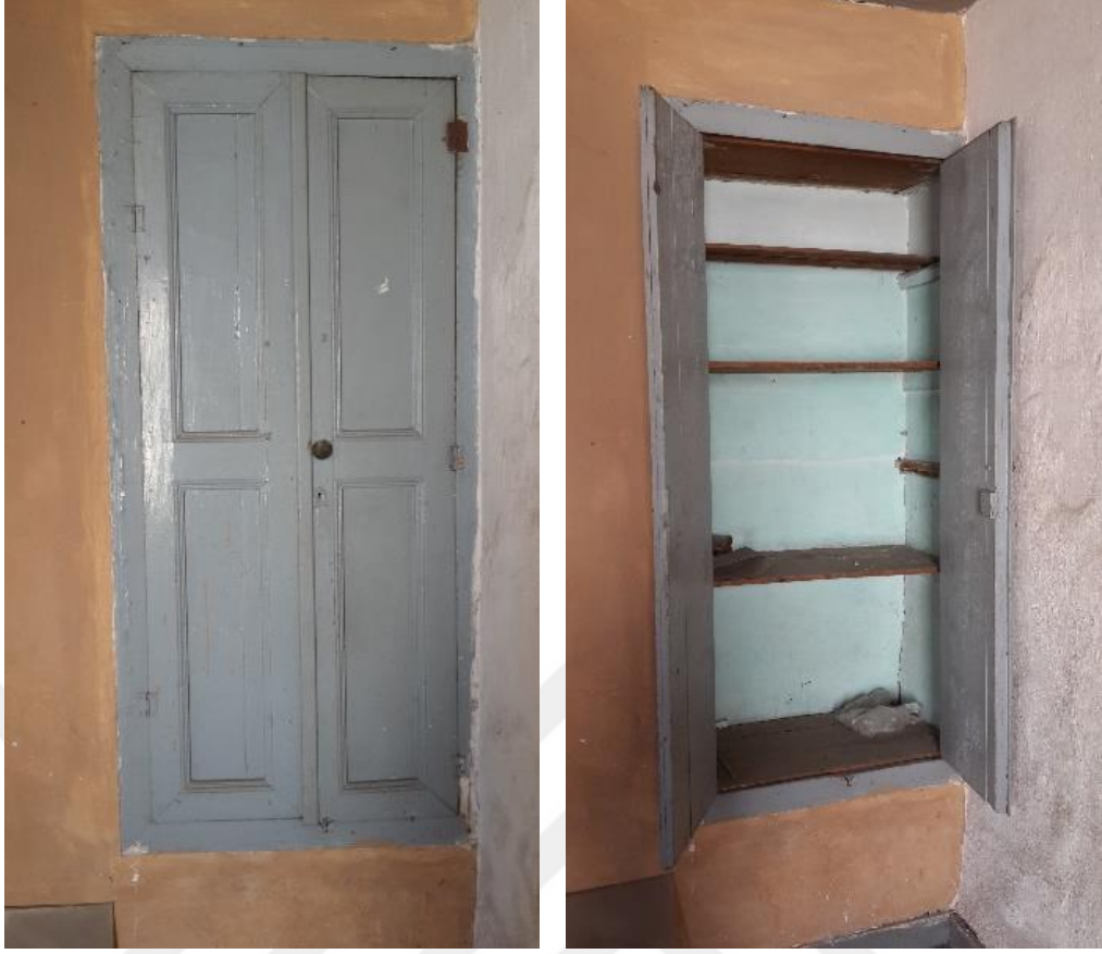
Şekil 4.112: Z02 mekânının batı duvarındaki gömme dolap (Konuk, Kuşadası, 2016).
