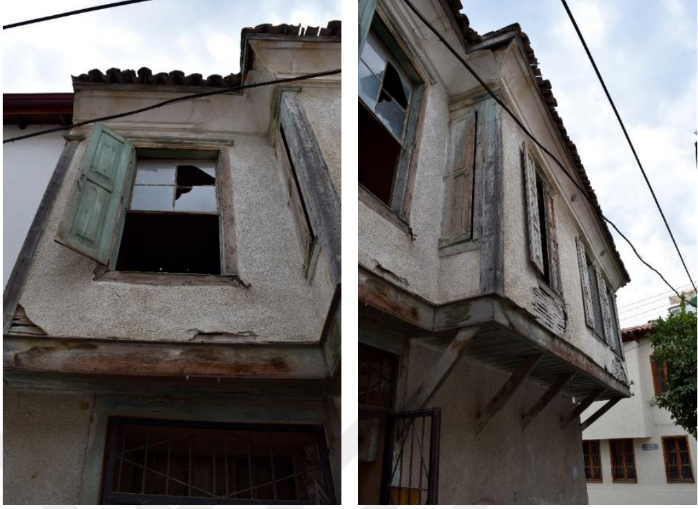
Şekil 4.71: Soldan sağa, birinci kat hizasında batı cephesi ve batı cephesine Kutlu Sokak'tan bakış (Konuk, Kuşadası, 2016).
