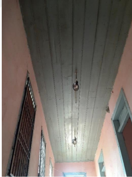
Şekil 4.52: 101 mekânının tavan kaplaması (Konuk, Kuşadası, 2016).
