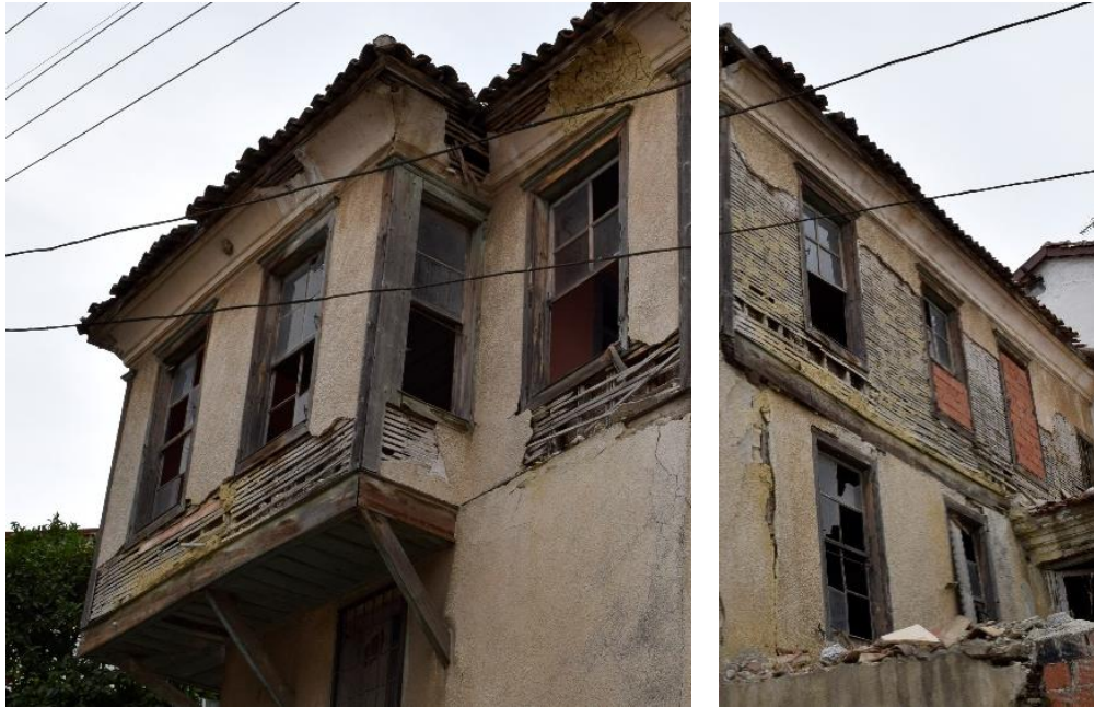
Şekil 4.102: Soldan sağa, Güney cephesi birinci kat hizası ve doğu cephesi görünüşü (Konuk, Kuşadası, 2016).
