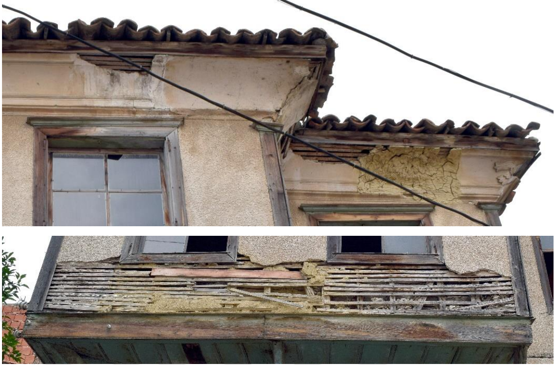
Şekil 4.115: Güney cephesi / bağdadi saçak ve duvar örgüsü (Konuk, Kuşadası, 2016).
