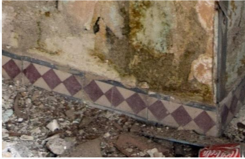
Şekil 4.111: Z04 mutfağı zemin kaplaması ve süpürgeliği (Konuk, Kuşadası, 2016).
