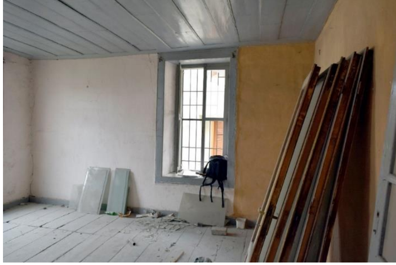
Şekil 4.28: Z02 mekânının güney duvarının görünüşü (Konuk, Kuşadası, 2016).
