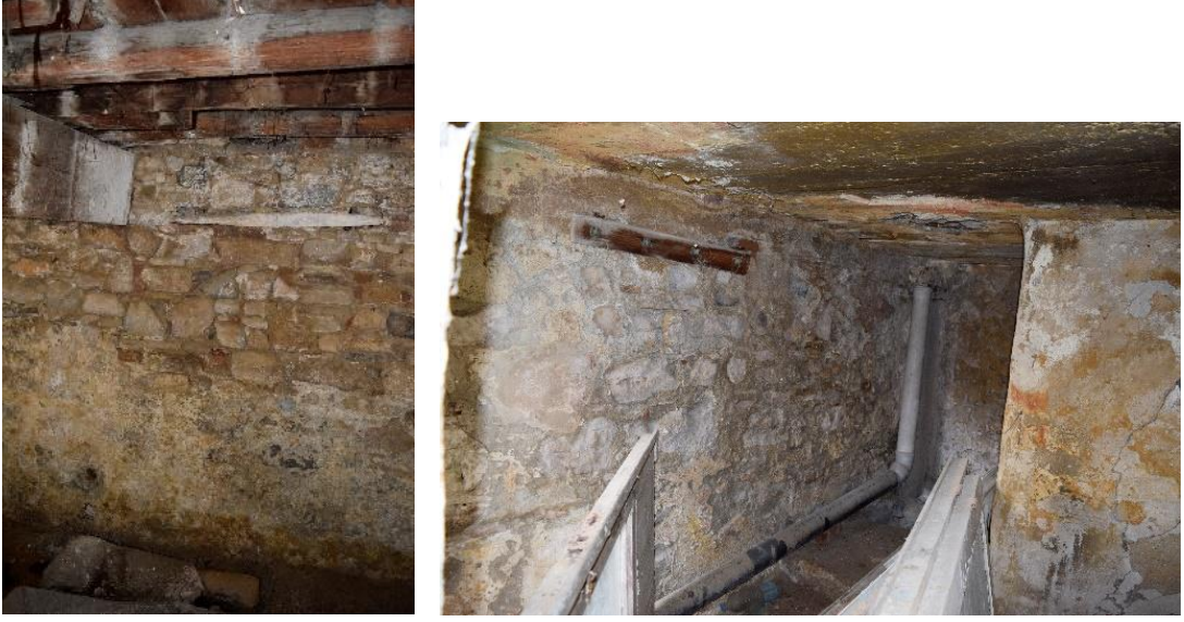
Şekil 4.117: Soldan sağa, B01 mekânının kuzey duvarı ve B02 mekânının batı duvarı (Konuk, Kuşadası, 2016).
