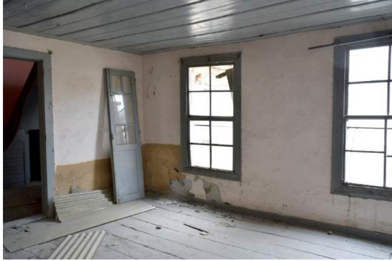
Şekil 4.31: Z02 mekânının kuzey ve batı duvarları (Konuk, Kuşadası, 2016)
