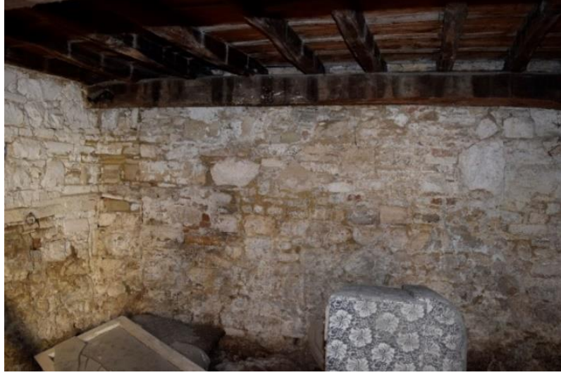
Şekil 4.14: B01 mekânı batı duvarı (Konuk, Kuşadası, 2016).
