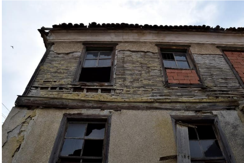
Şekil 4.81: Bahçeden doğu cephesinin birinci kat ve zemin kat hizasına bakış (Konuk, Kuşadası, 2016).
