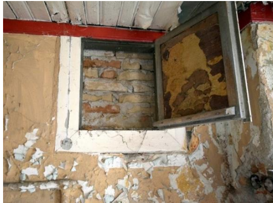
Şekil 4.45: Yukardan aşağı, Z04 mekânının doğu duvarında yer aşan ocak ve aynı duvarda bulunan üst pencere (Konuk, Kuşadası, 2016).
