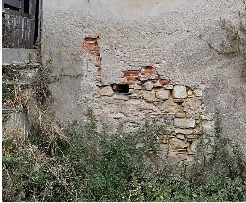
Şekil 6.3: Bahçenin kuzey duvarına bakış (Konuk, Kuşadası, 2016).
