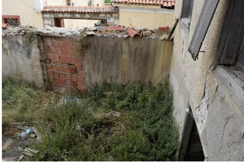
Şekil 4.7: Bahçenin güney duvarı (Konuk, Kuşadası, 2016)
