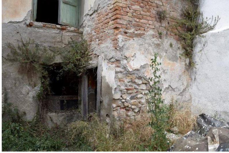
Şekil 4.10: Bahçenin kuzeydoğu köşesinde çıkma yapan cephe (Konuk, Kuşadası, 2016)
