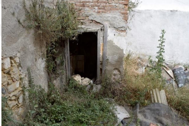
Şekil 4.92: Bahçeden doğu cephesinde yer alan B02 mekânının girişine bakış (Konuk, Kuşadası, 2016).
