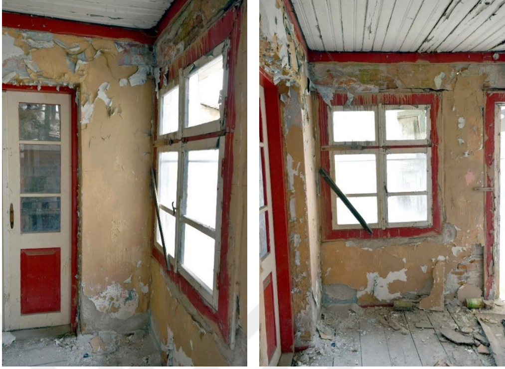
Şekil 4.37: Soldan sağa, Z03 mekânının güneydoğu köşesi ve güney duvarı (Konuk, Kuşadası, 2016).
