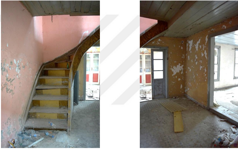
Şekil 4.22: Soldan sağa, Z01 sofanın girişten M01 merdivenine bakış ve mekânın güneydoğu köşesine bakış (Konuk, Kuşadası, 2016).
