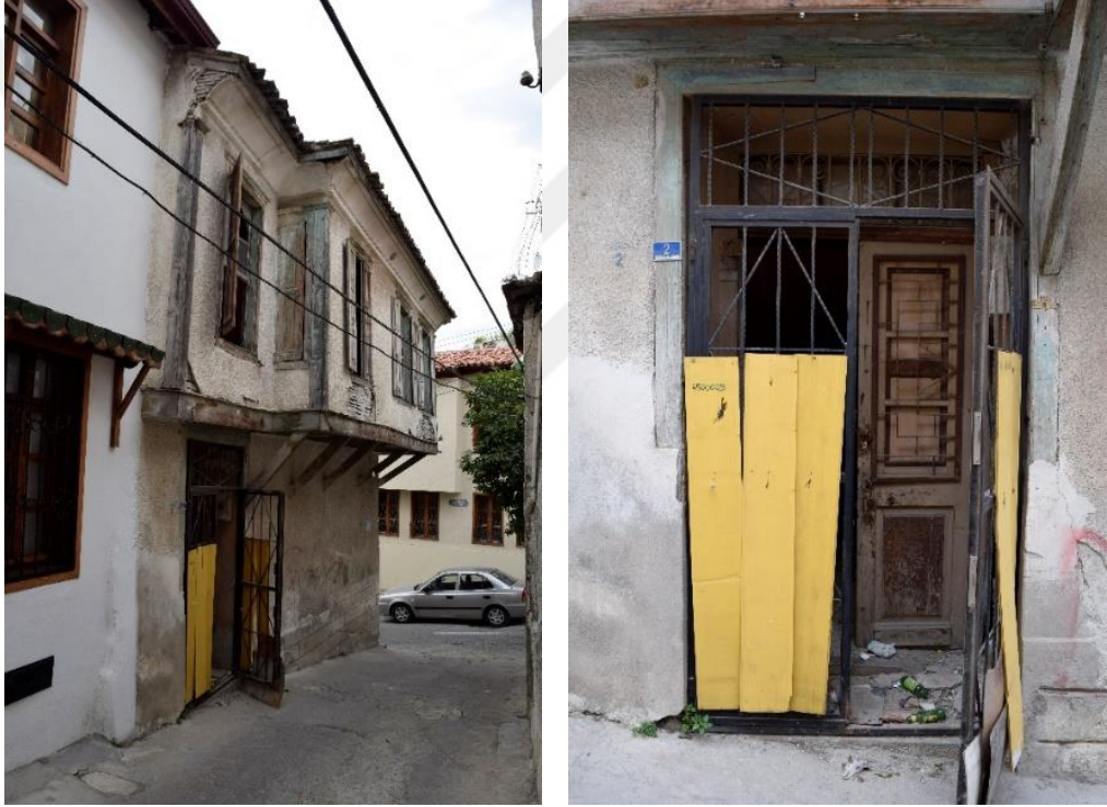
Şekil 4.70: Soldan sağa, batı cephesi ve aynı cephede yer alan giriş (Konuk, Kuşadası, 2016).
