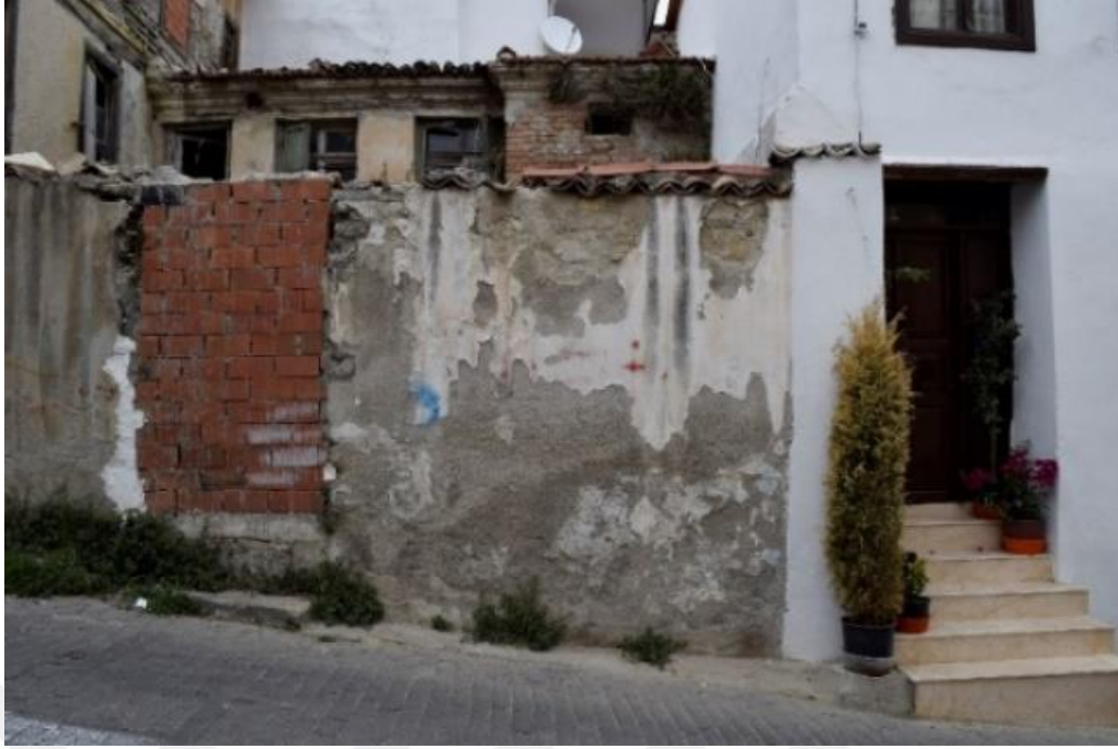
Şekil 4.78: Güney cephesi bahçe duvarı ve komşu binanın girişi (Konuk, Kuşadası, 2016).
