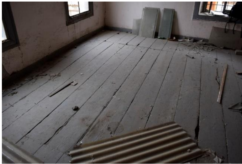
Şekil 4.33: Z02 mekânının zemin döşemesi (Konuk, Kuşadası, 2016).
