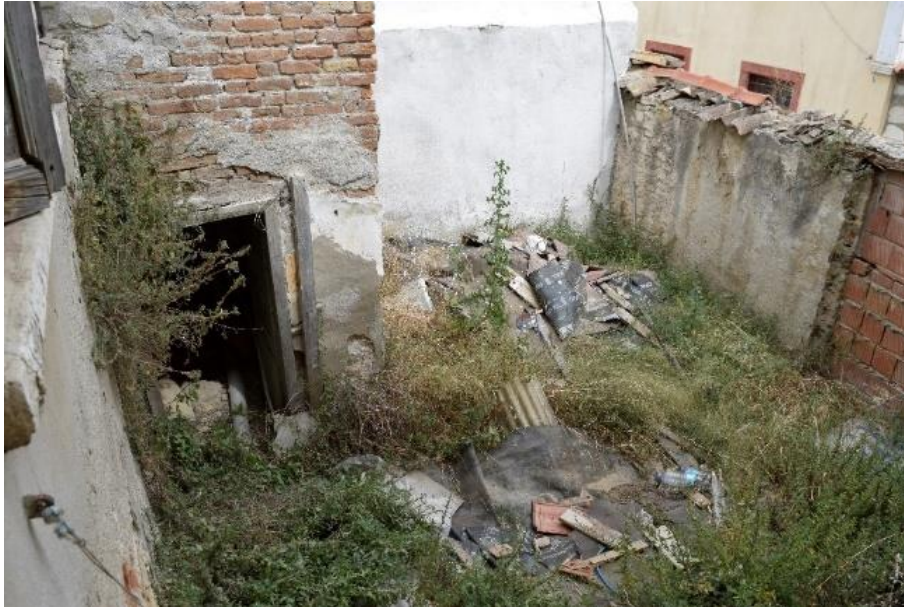
Şekil 4.6: Bahçenin kuzeybatı köşesinden bahçeye bakış ve B02 mekânının girişi (Konuk, Kuşadası, 2016)
