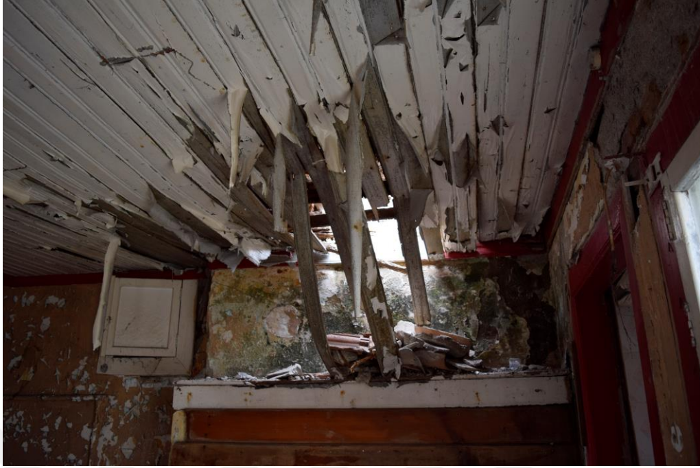
Şekil 5.2: Z04 mekânının çöken tavanı (Konuk, Kuşadası, 2016).
