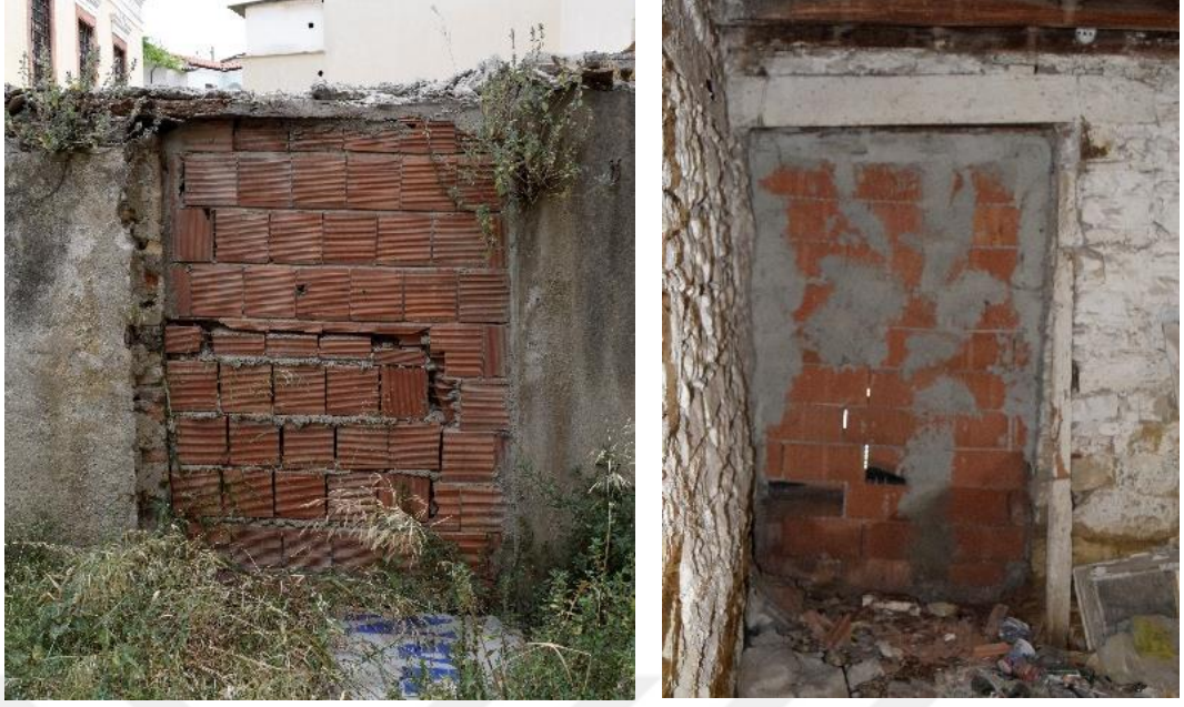
Şekil 6.2: Soldan sağa, bahçenin kuzey duvarında v B01 mekânının kuzey duvarında yer alan kapı izleri (Konuk, Kuşadası, 2016).
