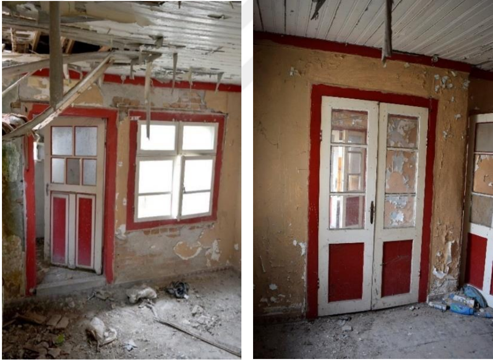
Şekil 4.41: Soldan sağa, Z04 mekânının güney duvarı ve batı duvarındaki kapı (Konuk, Kuşadası, 2016).
