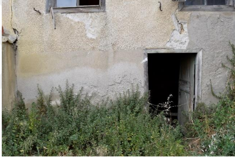
Şekil 4.8: Bahçenin batı duvarı ve B01 mekânının giriş kapısı (Konuk, Kuşadası, 2016)
