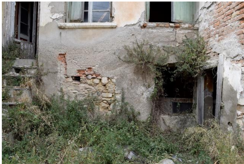
Şekil 4.88: Bahçe cephesi kuzey duvarı (Konuk, Kuşadası, 2016).
