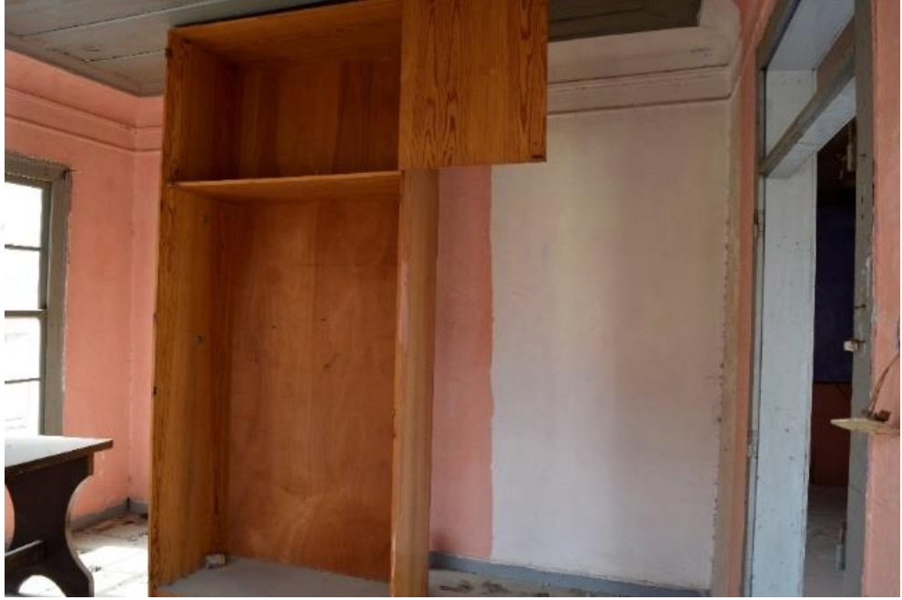
Şekil 4.56: 102 mekânının kuzey duvarı (Konuk, Kuşadası, 2016).
