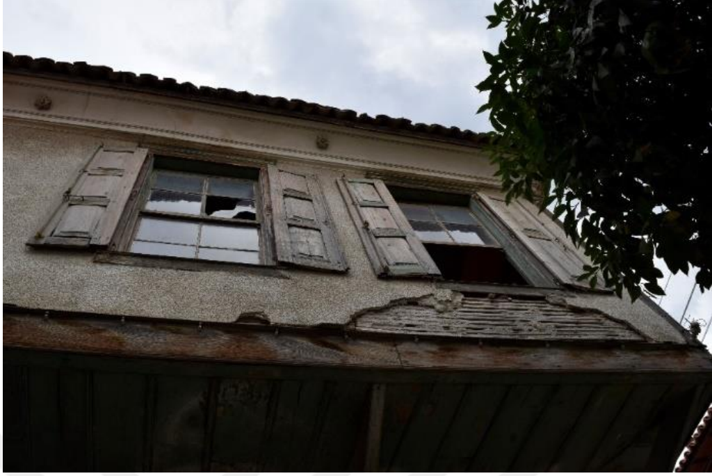
Şekil 4.73: Batı cephesinin birinci kat hizasının görünüşü (Konuk, Kuşadası, 2016).
