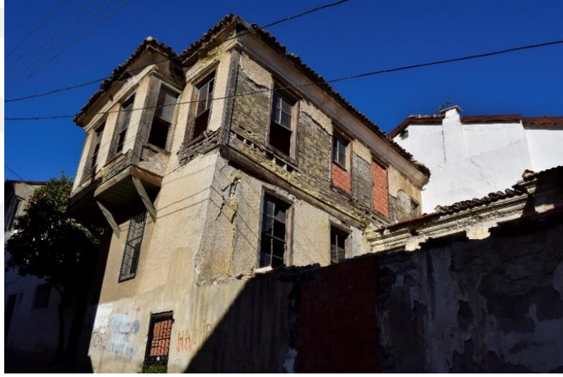
Şekil 4.80: Aslanlar Caddesi'nden doğu cephesine bakış (Konuk, Kuşadası, 2016).
