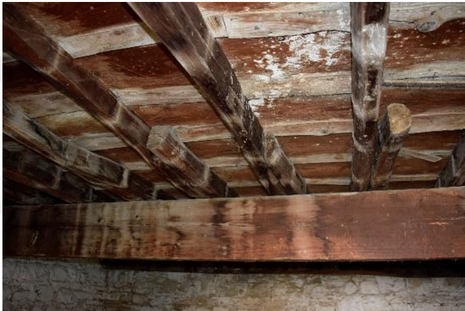
Şekil 4.118: B01 mekânının ahşap kiriş ve döşemesi (Konuk, Kuşadası, 2016)
