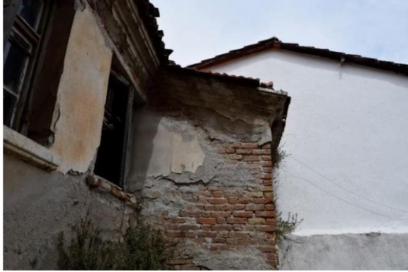
Şekil 4.91: Bahçeden doğu cephesi Z05 tuvalet duvarına bakış (Konuk, Kuşadası, 2016).
