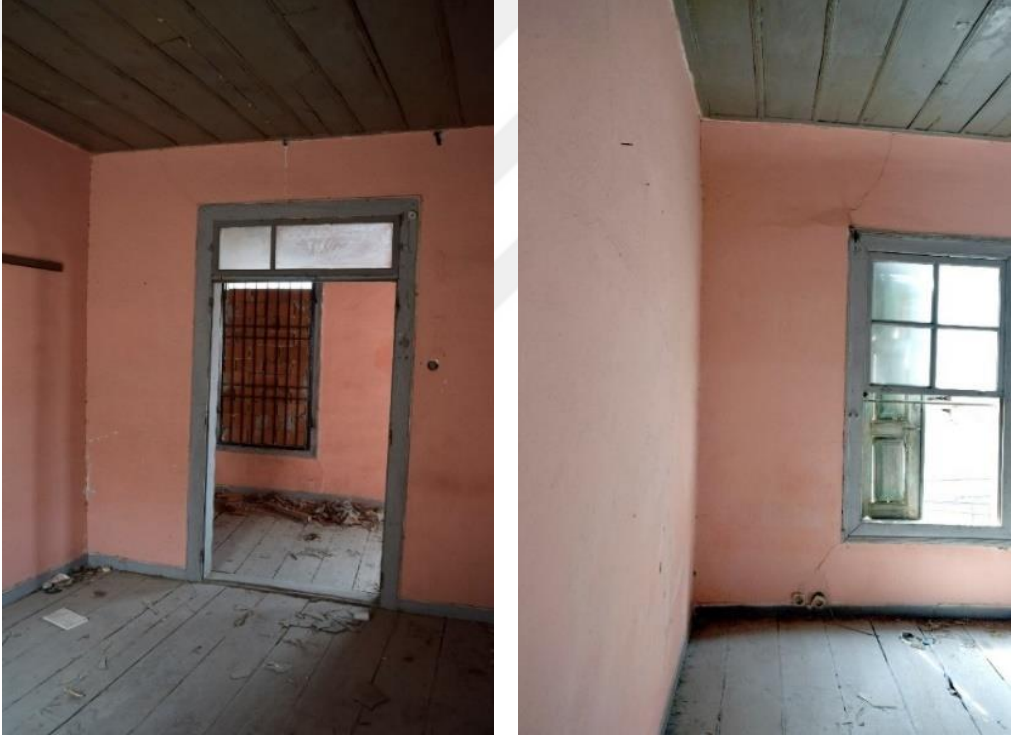
Şekil 4.59: Solda sağa, 103 mekânının girişi ve mekânın batı duvarı (Konuk, Kuşadası, 2016).
