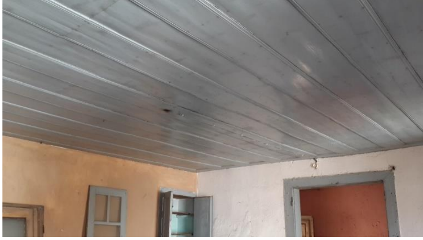
Şekil 4.34: Z02 mekânının tavan kaplaması (Konuk, Kuşadası, 2016).
