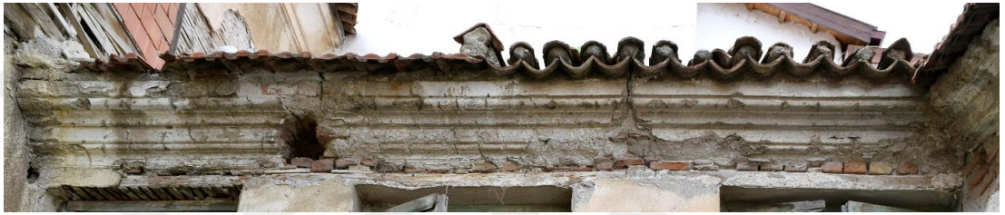
Şekil 4.114: Bahçe içi güney cephesi saçak görünüşü (Konuk, Kuşadası, 2016).
