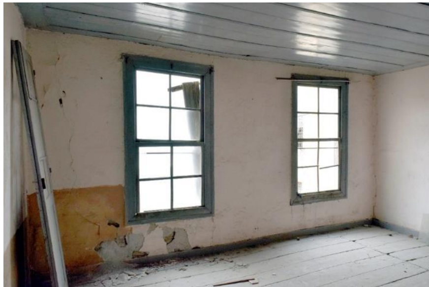
Şekil 4.27: Z02 mekânının doğu duvarının görünüşü (Konuk, Kuşadası, 2016).
