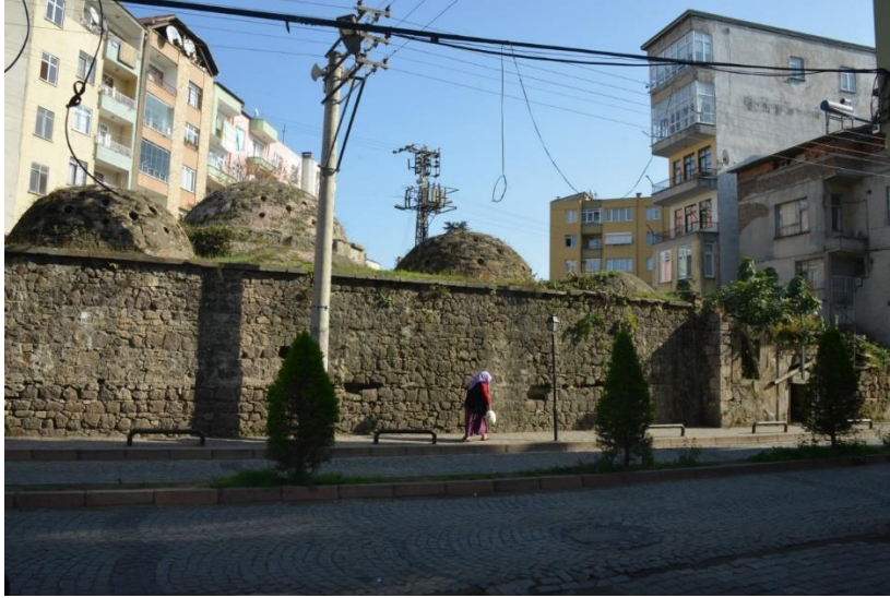
Şekil.3.28: Saray Hamamı Giriş Cephesi (Saray Caddesi) Restorasyon Öncesi 2015
