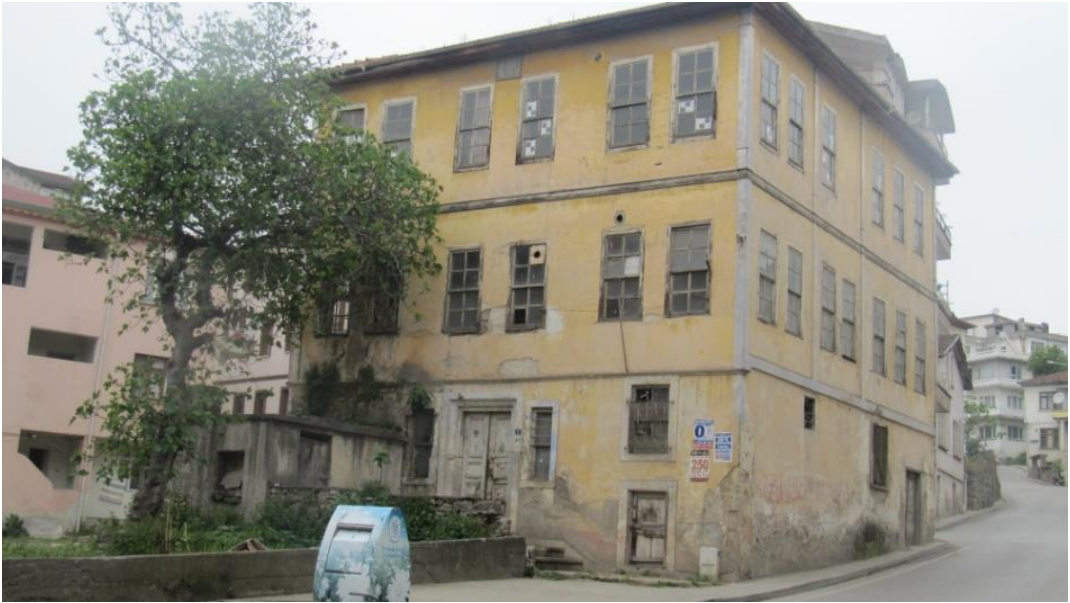
Şekil.4.10. Rasim Sırmabıyık Evi, Güneydoğu (ana giriş) ve Kuzeydoğu Cepheleri
