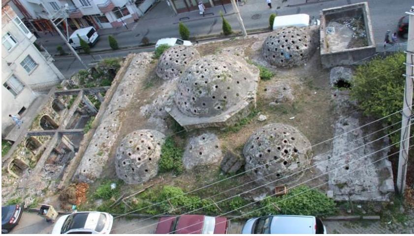
Őekil.3.28: Saray Hamamı st rt, Restorasyon ncesi (2015)
