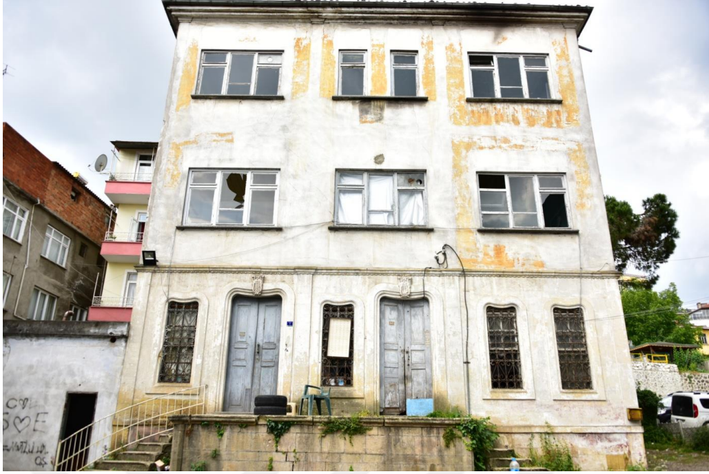
Şekil.3.70: Kaledere Mahallesi, 76 Ada, 6 Parsel Giriş Cephesi (Doğu Cephesi) (2018)
