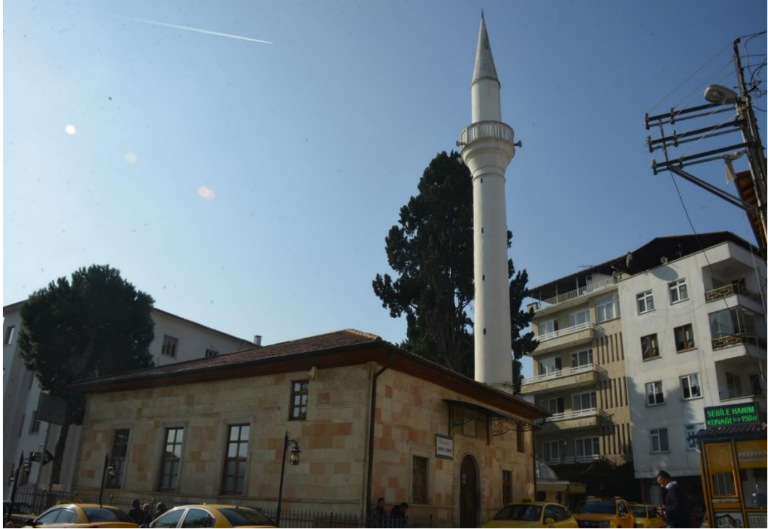
Şekil.3.15: Saray Cami (Kaledere Mahallesi)(2018)
