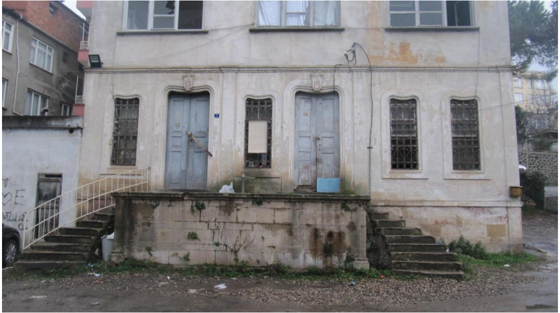
Şekil.3.91: Kaledere Mh., 76 Ada, 6 Parseldeki Yapının Kapı ve Pencereleri
