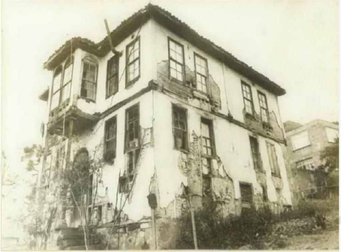
Şekil.3.9: Envanter no:69, Çamurlu Mahallesi, Aslanağa Sokak, No:19'daki kaybedilen tescilli yapı 1
