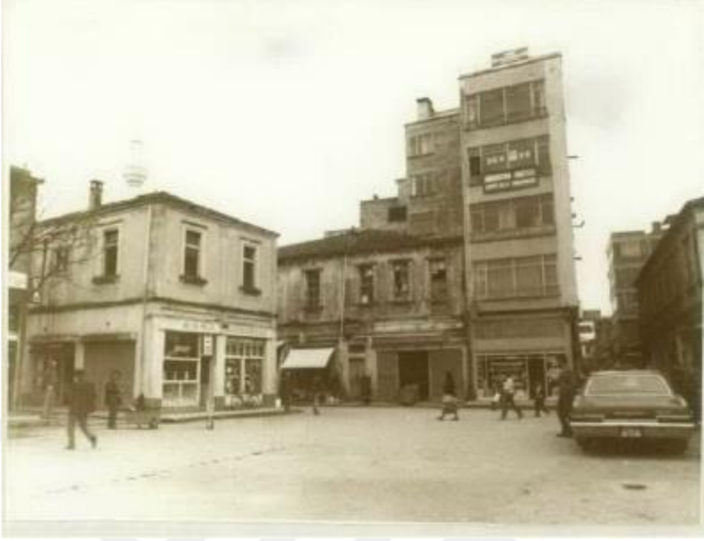
Şekil.3.48: Kaledere Mahallesi, 83 Ada, 1 Parsel ve Döner Çeşme Meydanı
