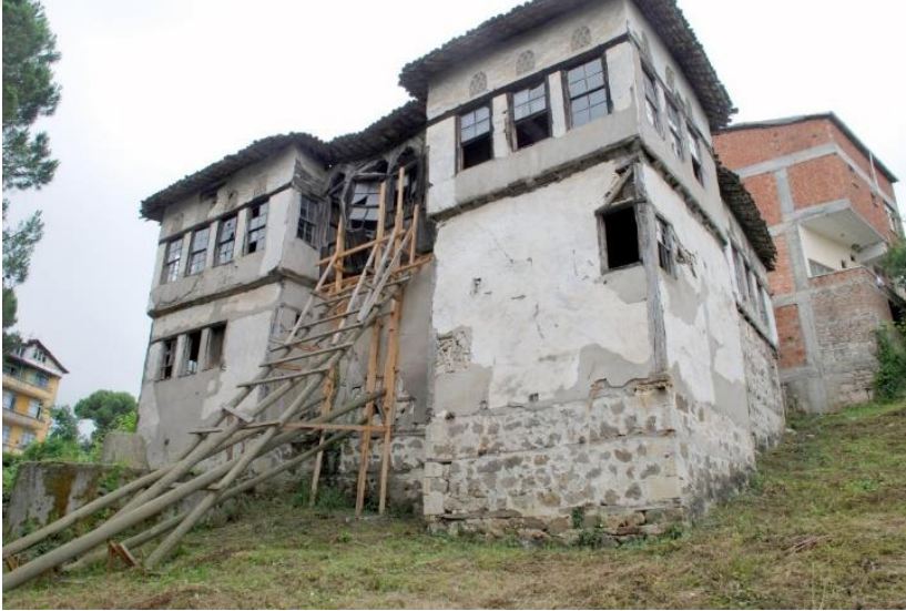
Şekil.3.72:Hamidiye Mahallesi, 193 Ada, 14 Parsel (Restorasyon Öncesi)
