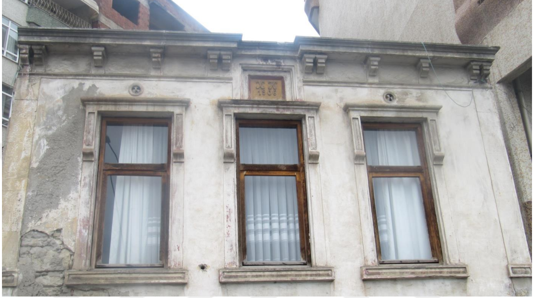
Şekil.5.17. Burunucu Mahallesi, 333 ada, 5 Parseldeki Yapının Pencere Boyutları
