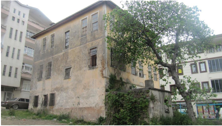
Şekil.4.2. Rasim Sırmabıyık Evi, Güneybatı Cephesi (2018)
