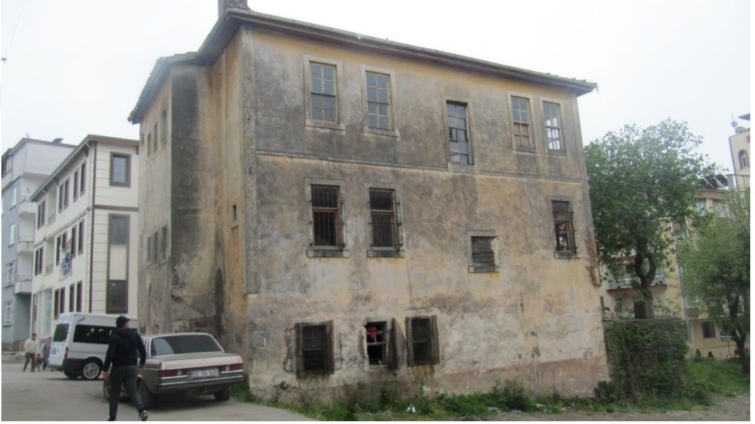
Şekil.4.11. Rasim Sırmabıyık Evi, Güneybatı ve Kuzeybatı Cepheleri
