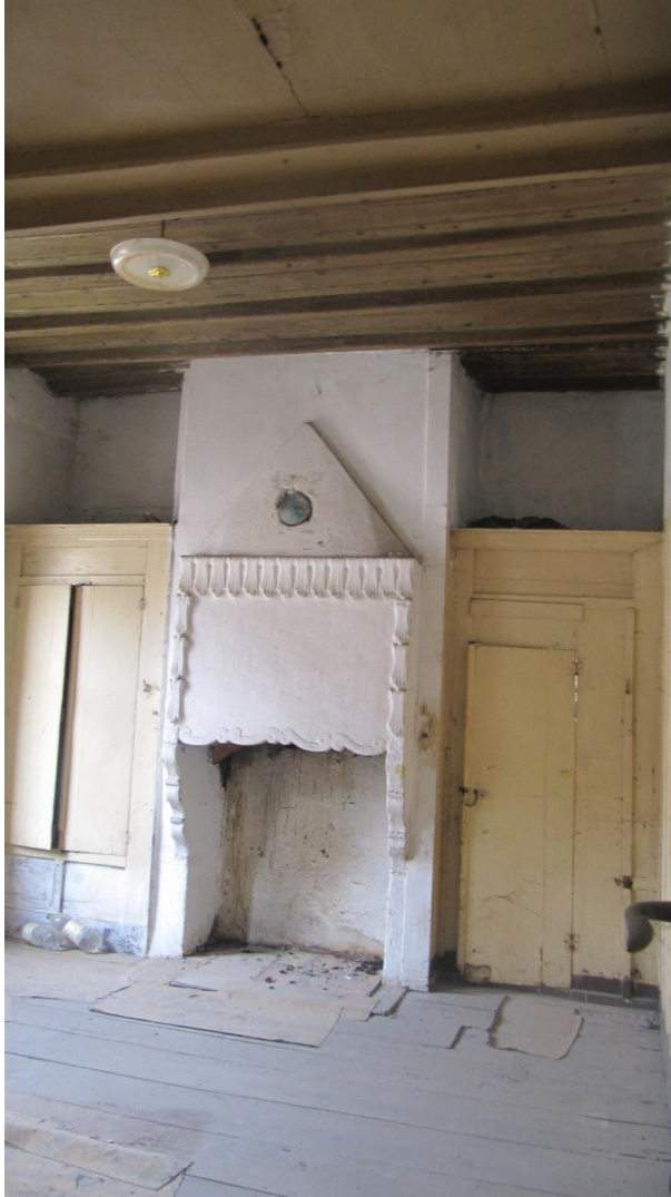
Şekil.4.5. Rasim Sırmabıyık Evi, 101 no'lu Mekan
