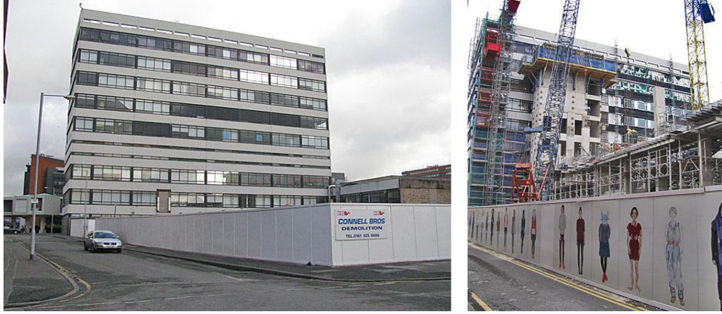
Şekil 56 Manchester School of Art'ın İnşa Aşaması (Manchester History, 2018)
