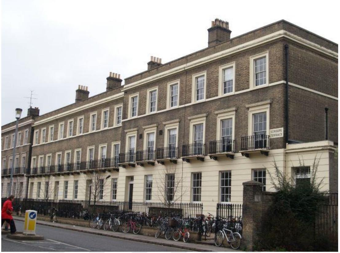
Şekil 66 Scroope Terrace Binası (Brown, 2018)
