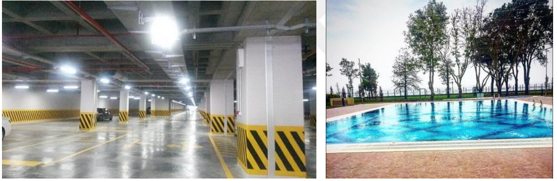
Şekil 4.72. ve 4.73. Yalı Ataköy, otopark katları ve açık yüzme havuzu
