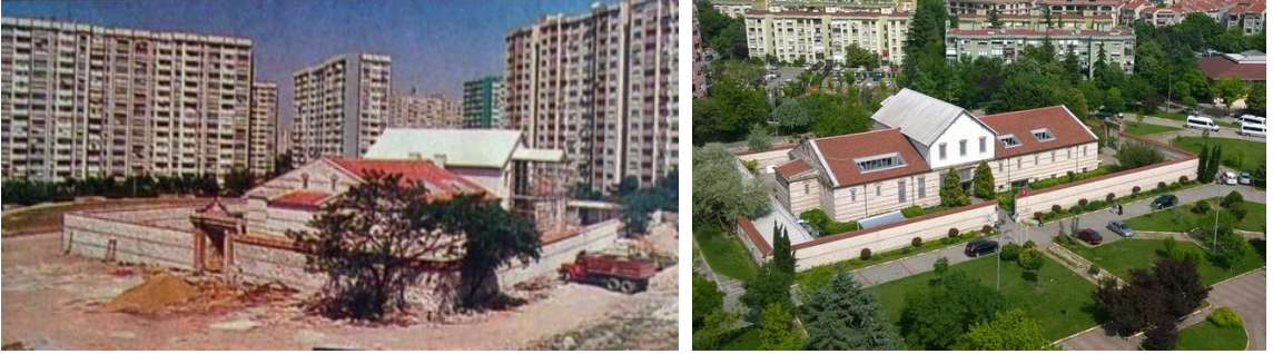
Şekil 4.6. ve 4.7. İspirtohane, restorasyondan önce ve sonra
