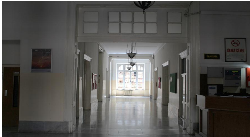
Şekil 4.18. Zemin Kat , Dođu yönündeki Kuzey- Güney Koridoru, 2017
