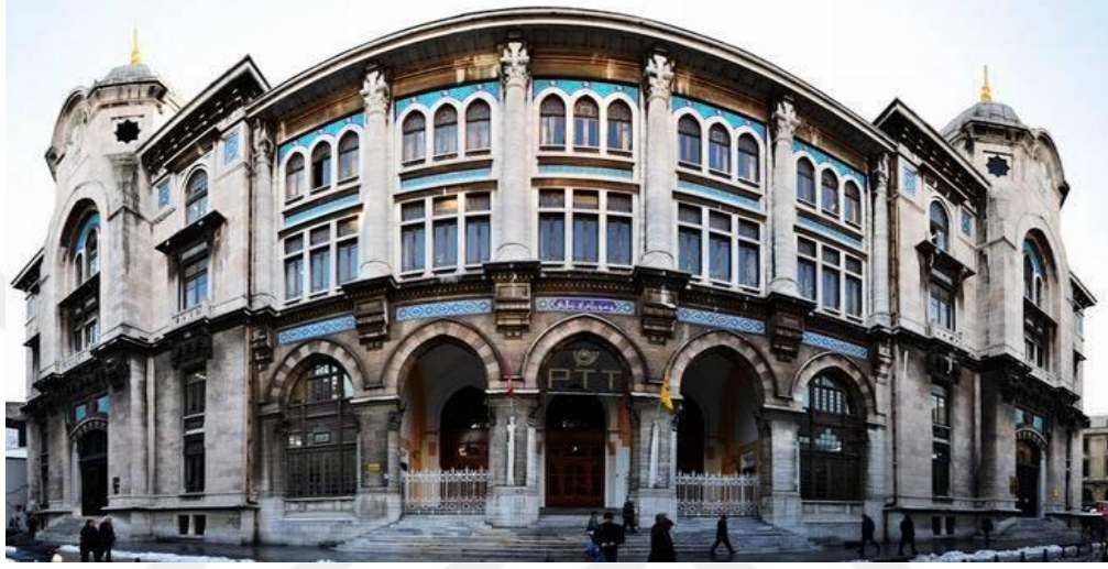
Şekil 3.9. Büyük Postane Binası(www.telecomcular.dernegi.com)
