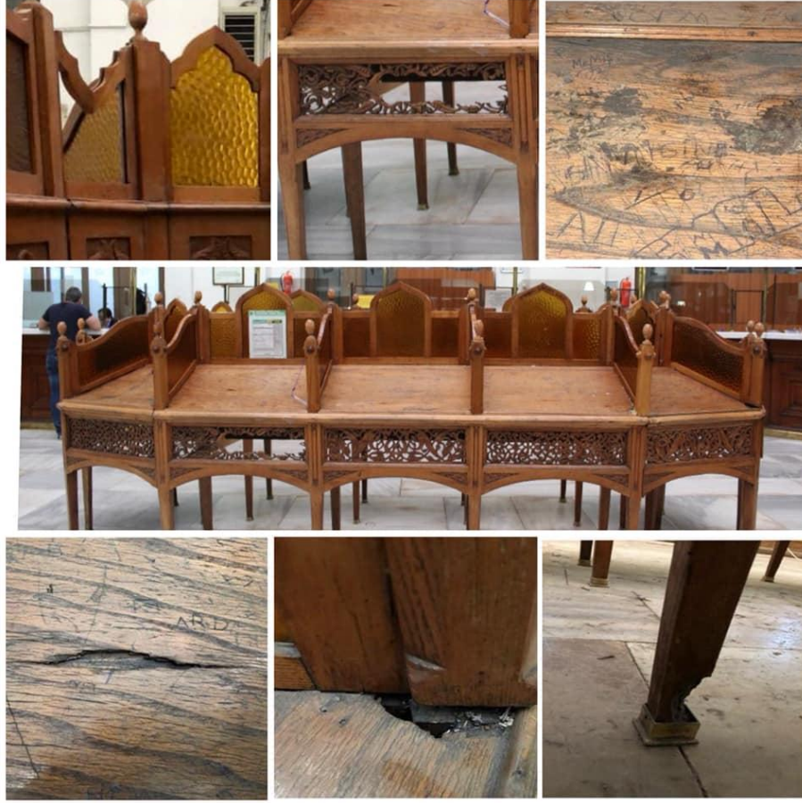
Şekil 5.25. Halk Yazı Masasındaki Bozulmalar, 2017
