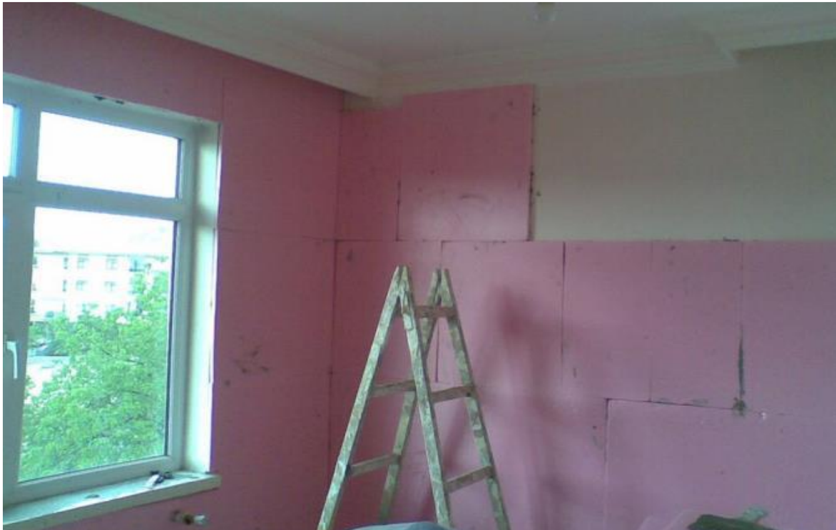
Resim 4. 9: Duvara Yapıştırılmış Olan Levhalar
