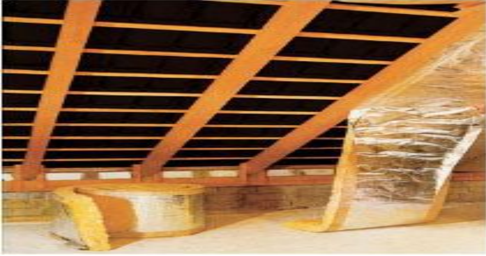
Resim 4. 16: Mertek Arası Şilte Uygulaması
