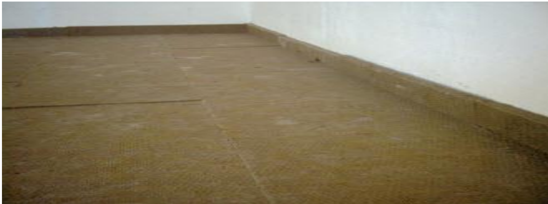
Resim 4. 12: Serbest Olarak Yerleştirilmiş Olan Isı Yalıtım Malzemeleri
