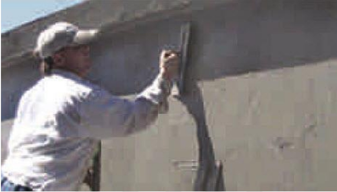
Resim 4. 2: Yüzeylerin Düzeltilmesi
