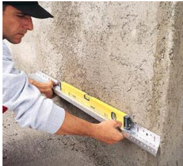
Resim 4. 3: Su basman profillerinin yerleştirilmesi
