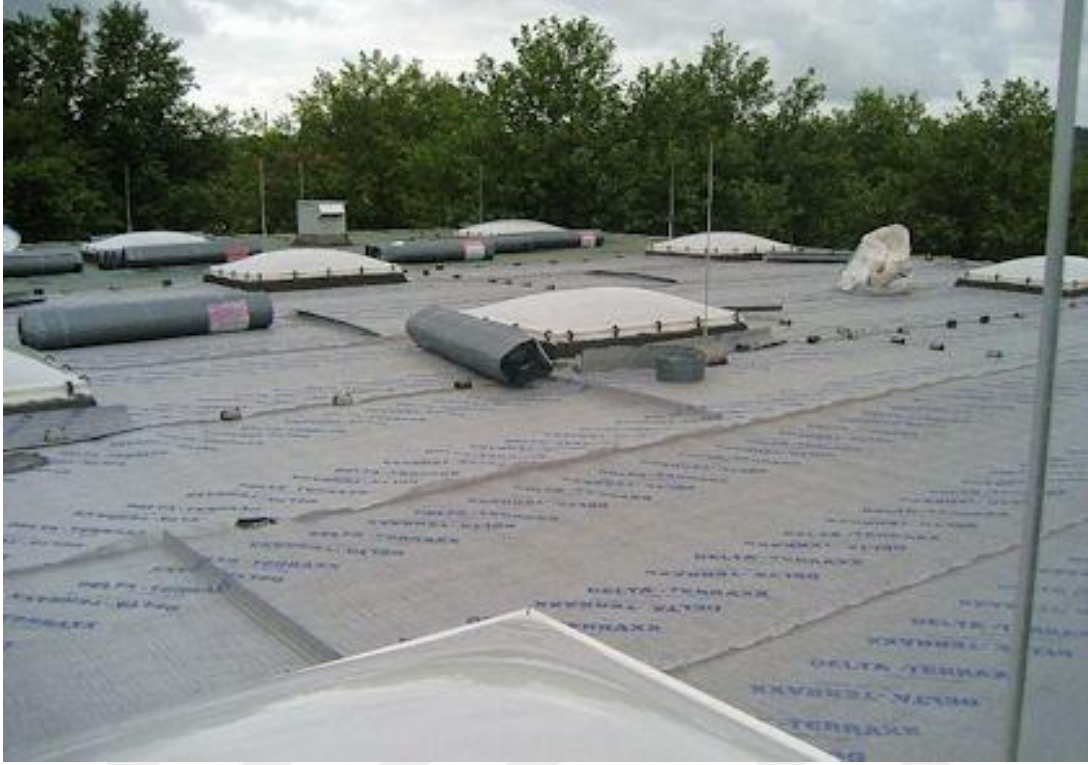
Resim 4. 21: Filtre Tabakasının Uygulanmış Olduğu Teras
