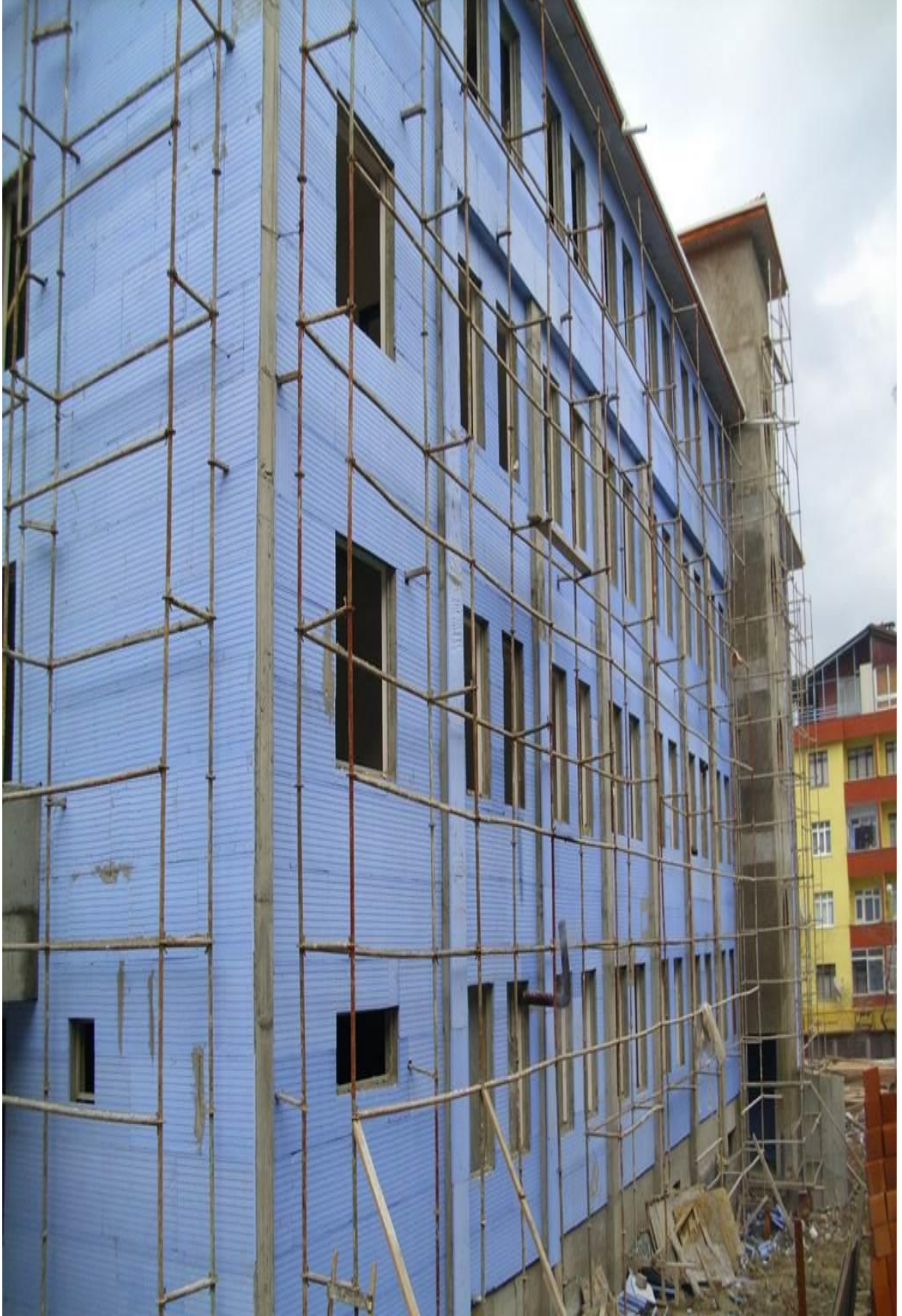
Resim 3. 4 : XPS Kullanmış Olan Bina
