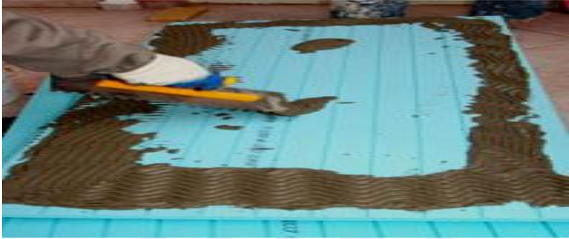
Resim 4. 8 : Yapıştırıcı Harcın Yüzeye Uygulanışı
