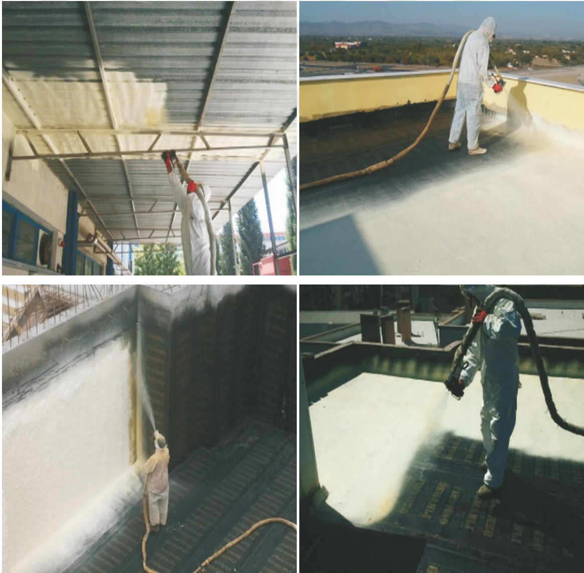
Resim 3. 2: Yerinde İmal Edilmiş Poliüretan Köpük Malzemelerin Kullanım Alanları
