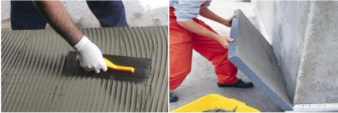
Resim 4. 4: Isı Yalıtım Levhalarının Yapıştırılması
