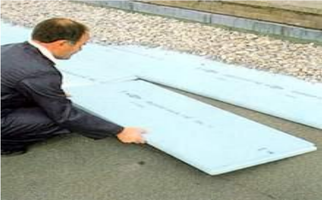
Resim 4. 20: Isı Yalıtım Levhaların Döşenmesi
