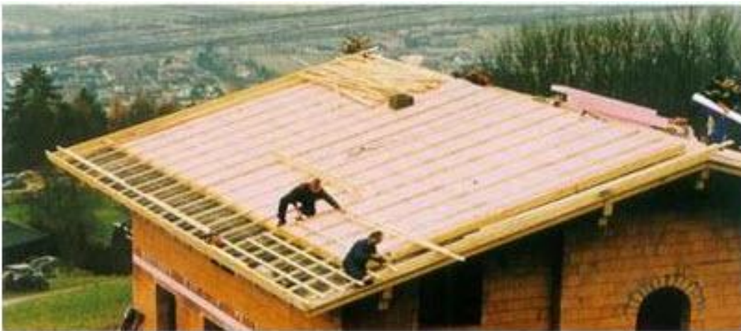
Resim 4. 17 :Polistren Köpük Levhaları Isı Yalıtımı
