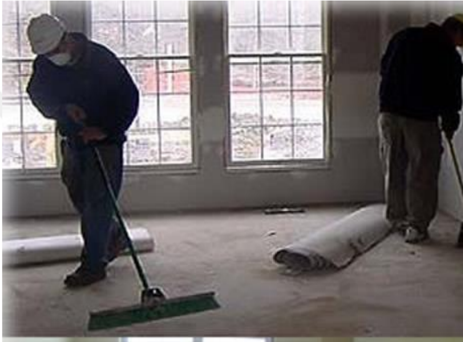
Resim 4. 11: Yalıtım Yapılacak Olan Yüzeyin Temizlenmesi
