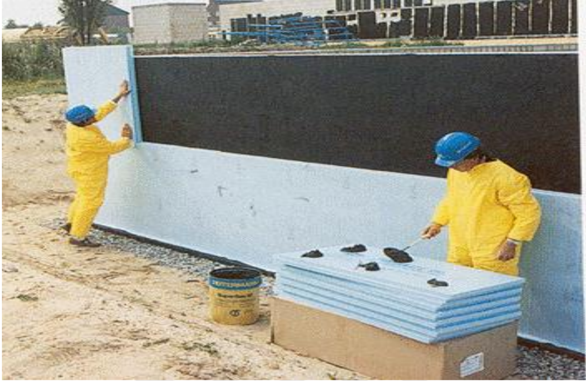
Resim 4. 10: Yalıtım Levhalarının Döşenmesi
