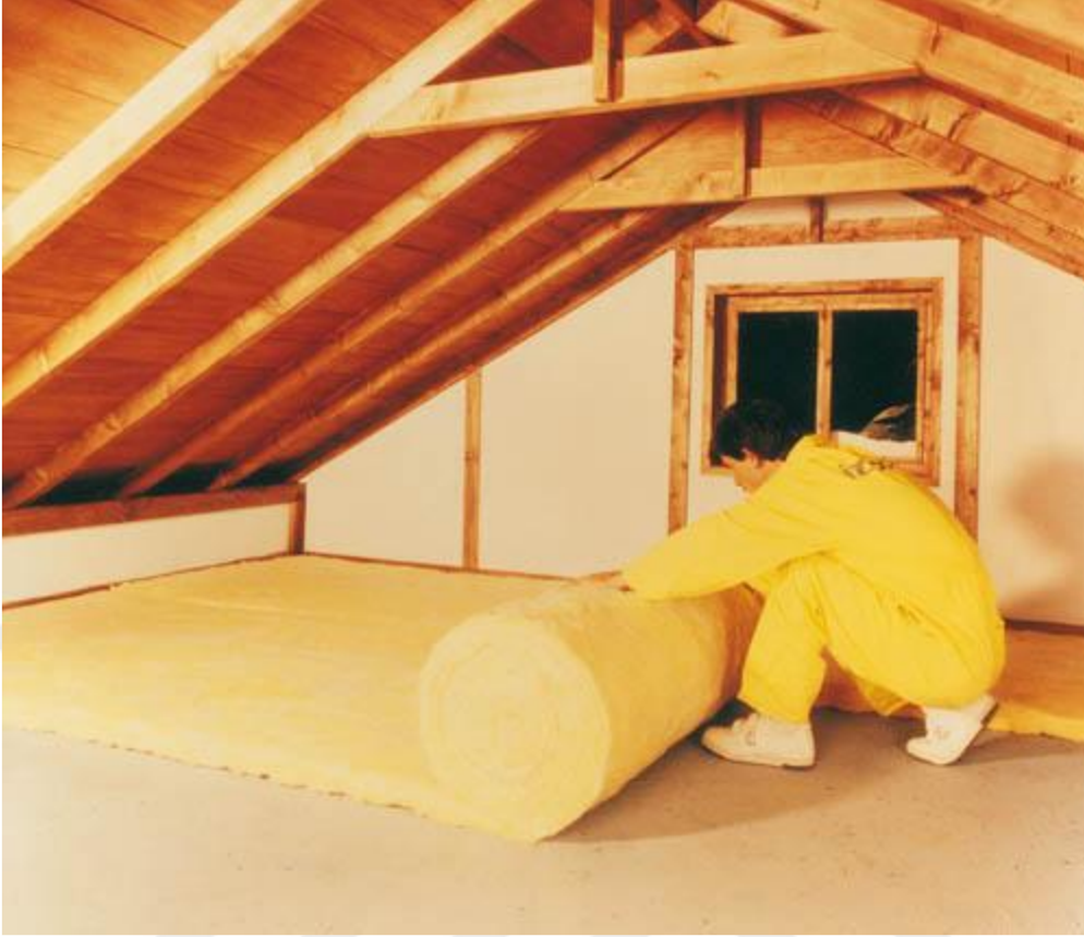
Resim 4. 15: Mineral Esaslı Şilteleni Çatı Döşemesi Serilmesi
