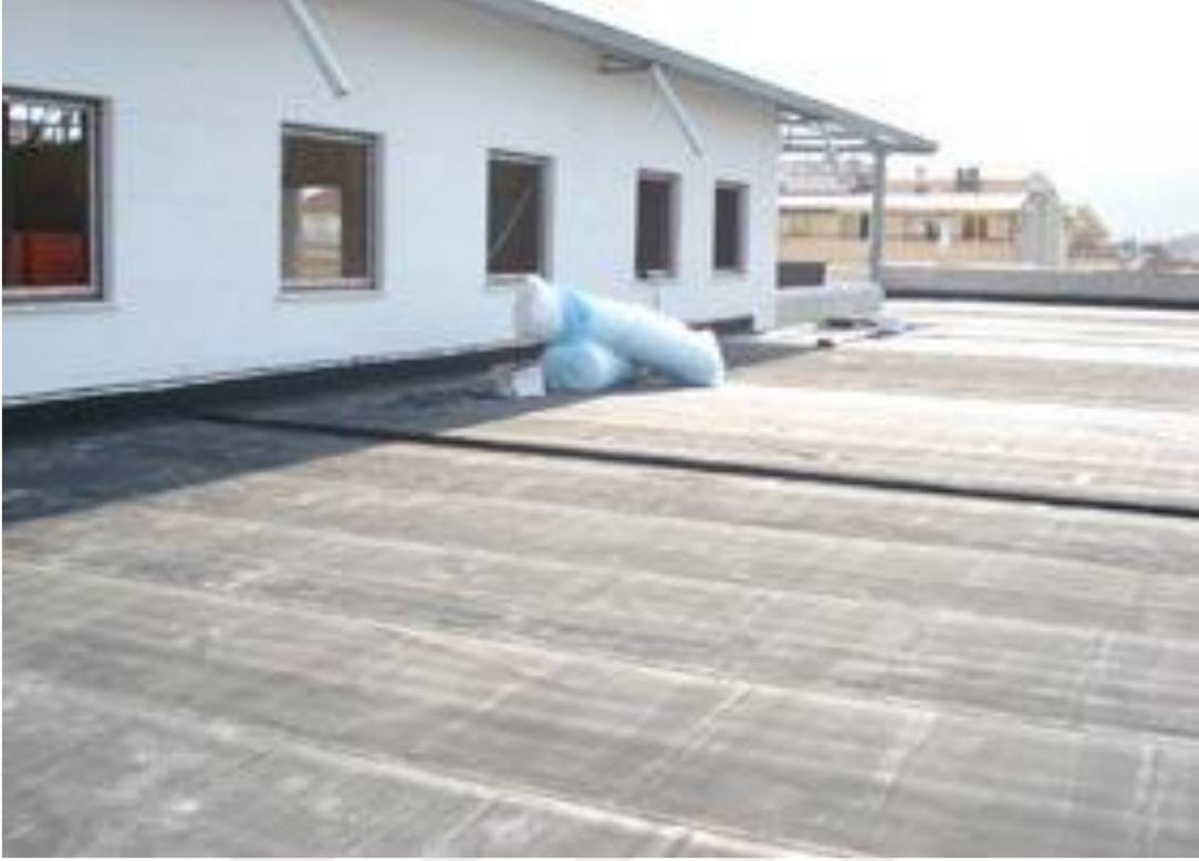
Resim 4. 19 :Isı Yalıtımı İçin Hazır Olan Teras
