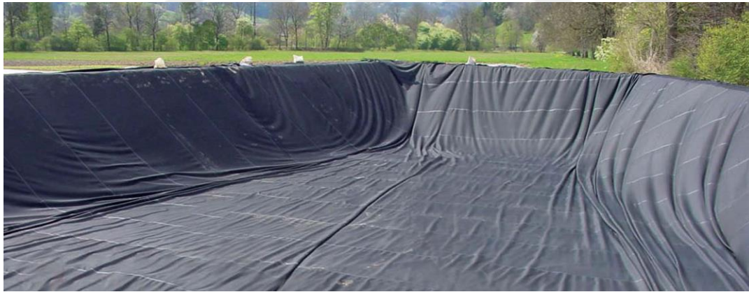
Resim 2.5. Geomembran uygulaması [12]
