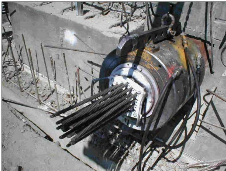
Şekil 2.12. Öngerme işlemi [11]
