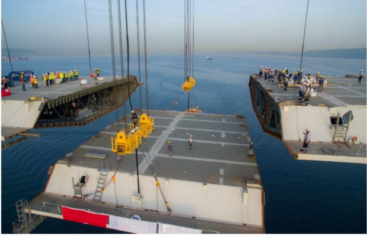
Resim 4.2. Köprü yapım çalışmaları [17]
