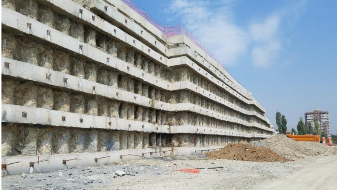
Resim 4.2. İksa uygulama görüntüsü (6. sıra ankraj imalatı, 2 aksı, yüksek kot)
