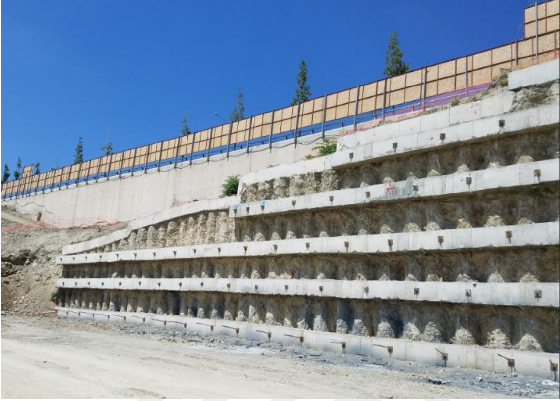
Resim 4.3. İksa uygulama görüntüsü (6. sıra ankraj imalatı, 1 aksı, düşük kot)
