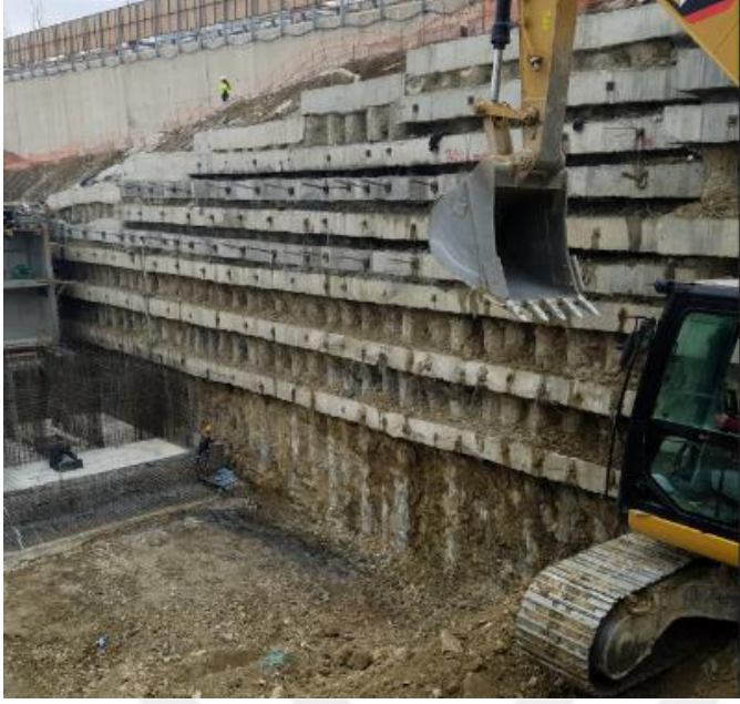
Resim 4.1. İmalatı ve projesi yapılan iksa görüntüsü
