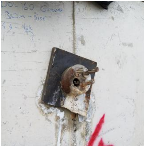
Resim 4.10. Ankraj plaka dönmesi
