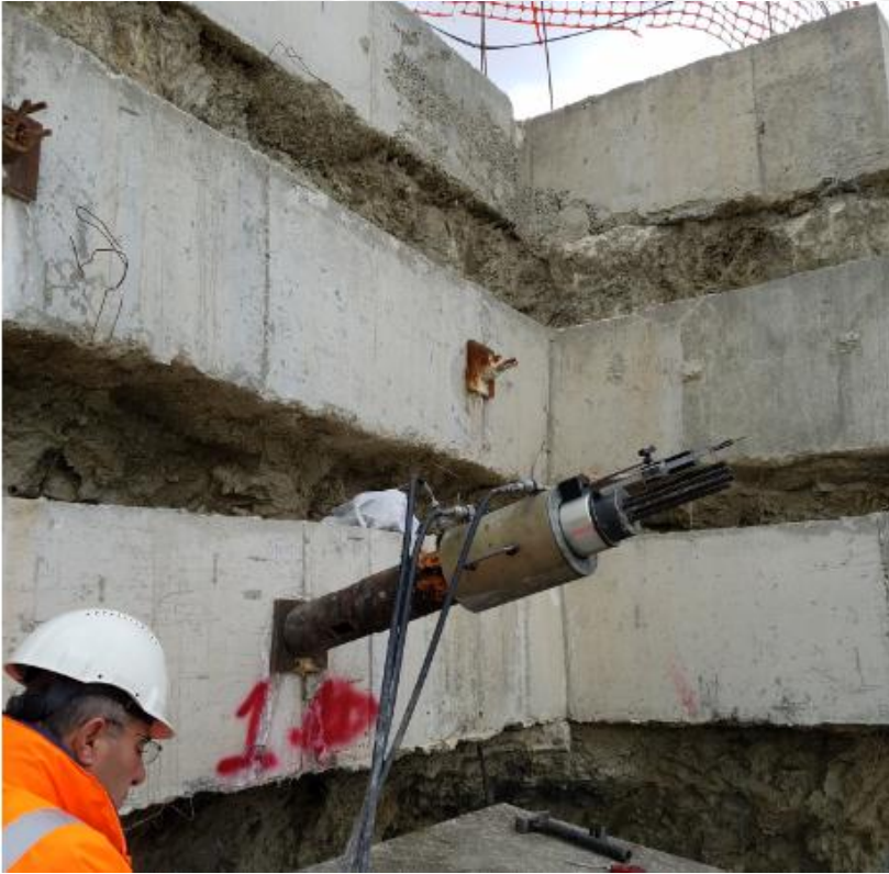
Resim 4.11. Ankraj taşıma kapasitesi kontrolü
