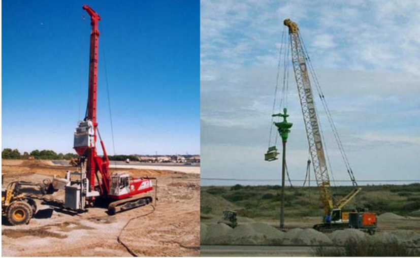
Şekil 2.40 Kuru tabandan beslemeli taş kolon uygulaması[37]
