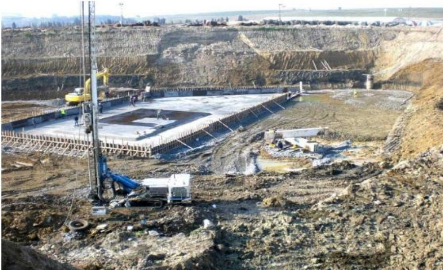
Şekil 2.3 Ordu Üniversitesi Tıp Fakültesi zemininde teşkil edilen jet kolonların yükleme deneyleri[6]
