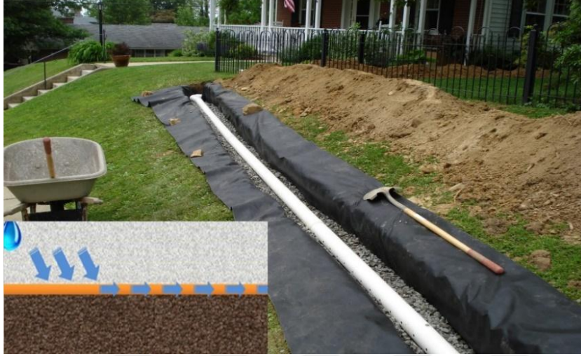
Şekil 2.59 Geotekstillerin drenaj fonksiyonu[52].
