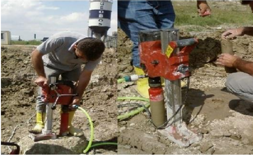
Şekil 2.30 Jet grout kolonlarından karot numunesi alınması[26]
