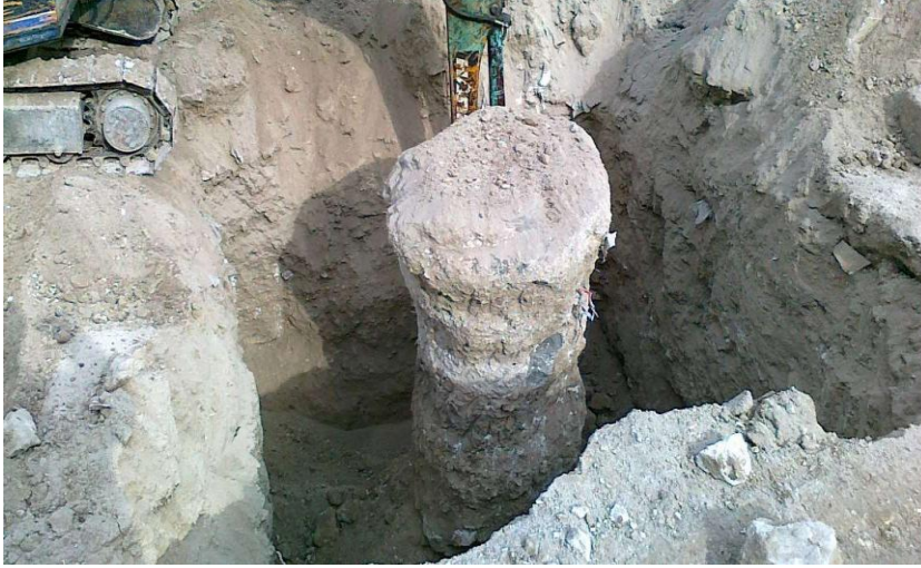
Şekil 2.26 Jet grout deneme kolonları örnekleri ve çap kontrolü[23]
