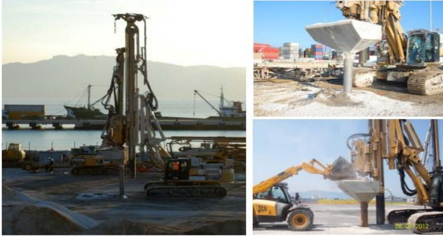
Şekil 2.50 Impact Sistemi ile Darbeli Kırmataş Kolon İmalatı[39]
