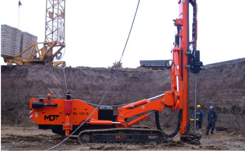
Şekil 2.22 Jet grout delgi makinesi[20]
