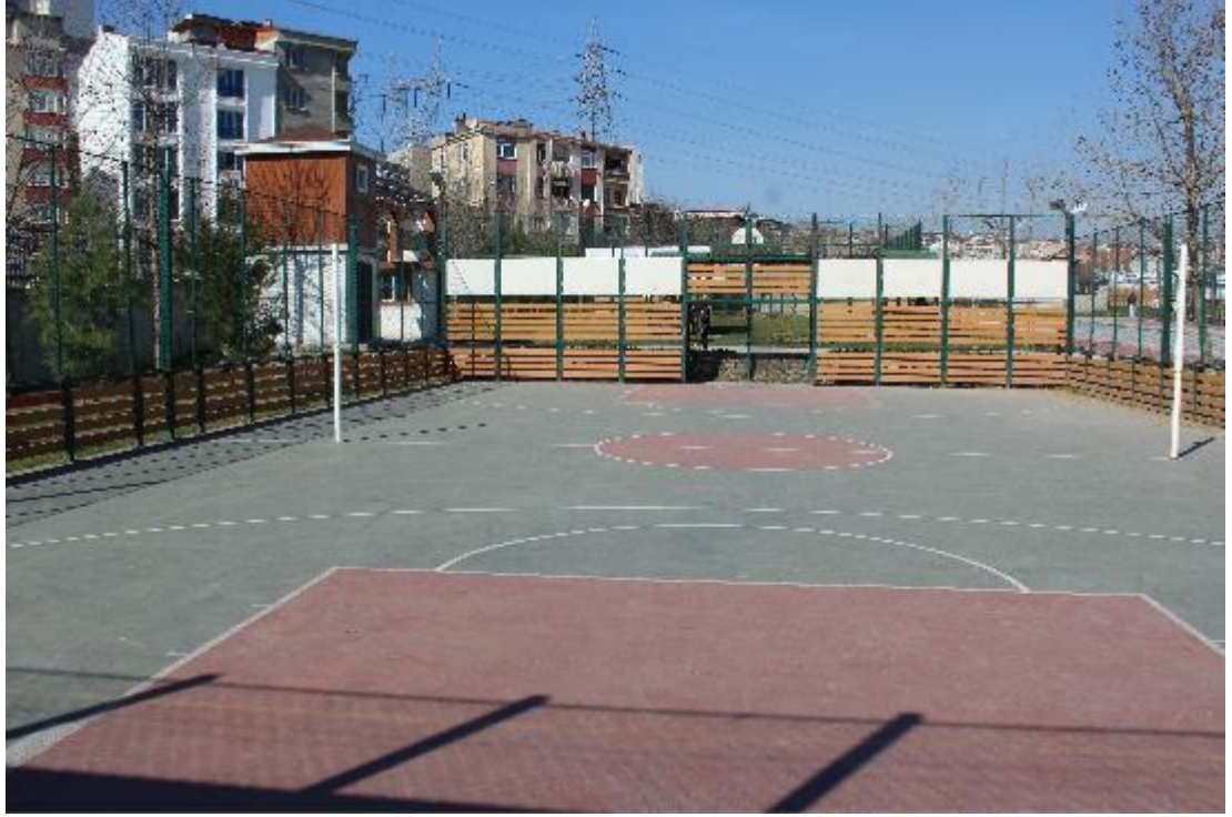
Fotoğraf 4.26. Zemin Durumu
