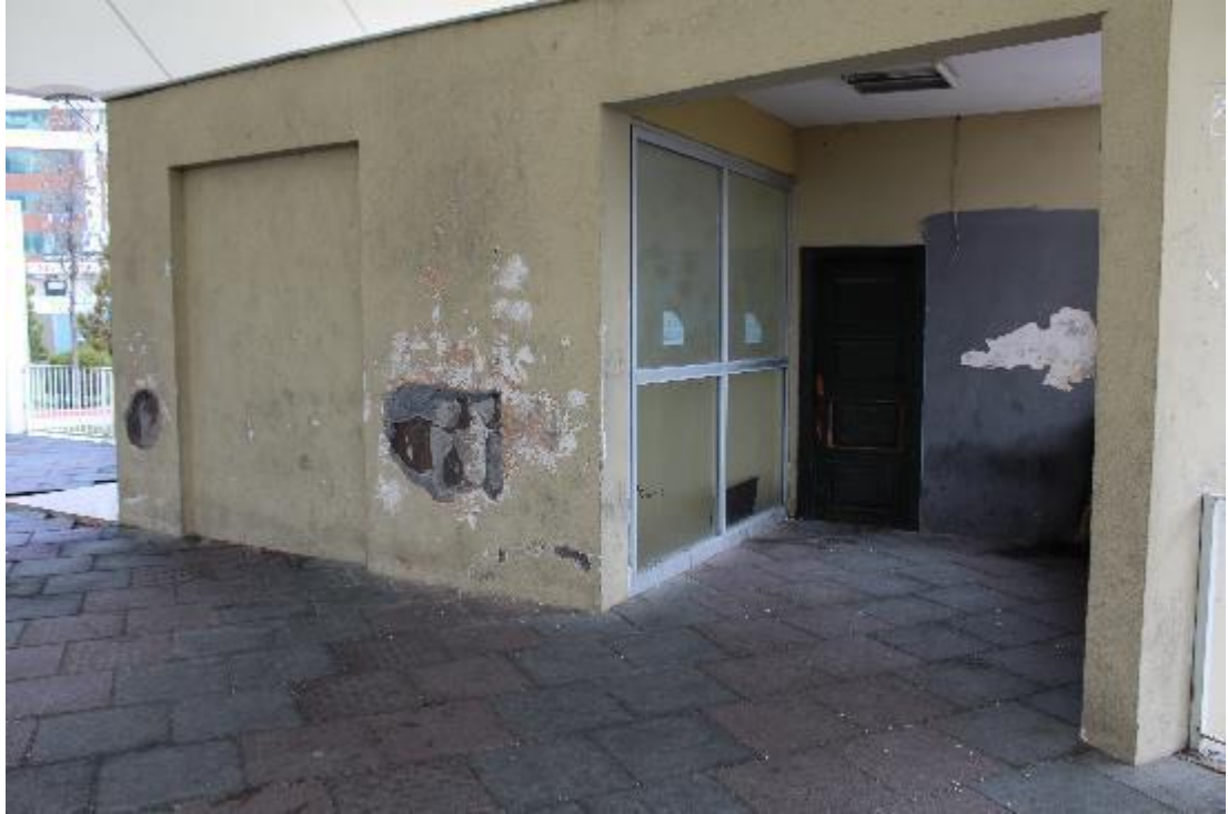
Fotoğraf4.5. Fitness Alanı Tesisi
