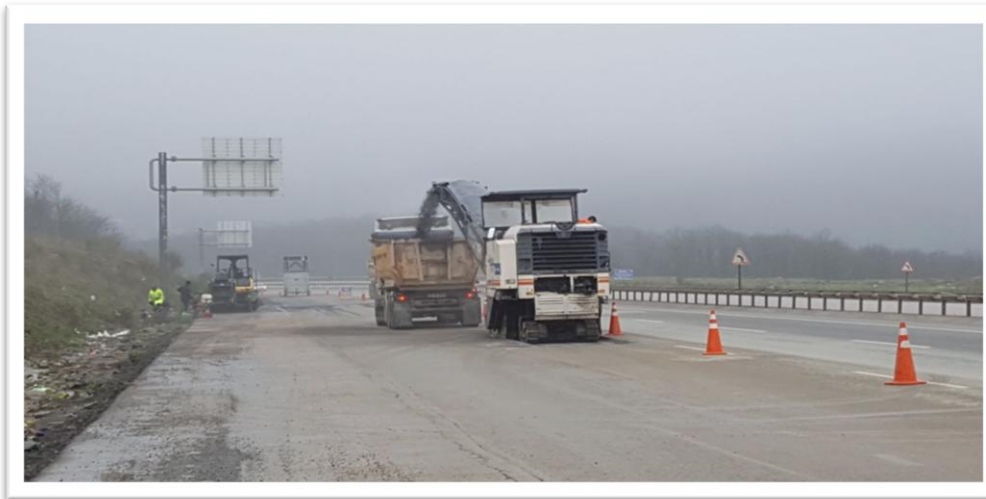
Resim 4.8. Freze ile bozulan asfaltın kazılarak damperli kamyonla yüklenmesi işlemi
