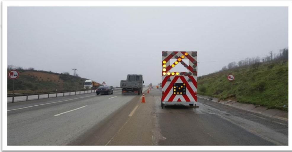
Resim 4.7. Uygulama öncesi römorklu ışıklı tabela ile alınan önlem
