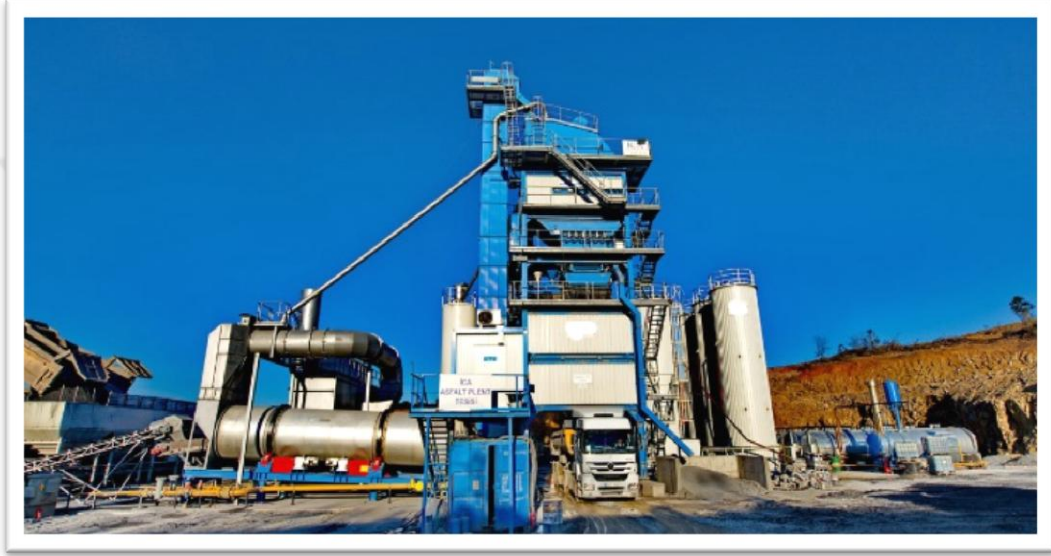
Resim 4.4. Asfalt fabrikasından bir görünüm
