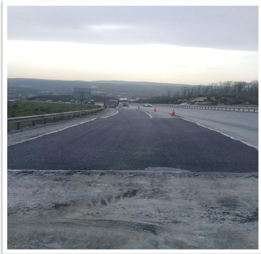
Resim 4.10. Finişlerle yapılan uygulamanın son hali
