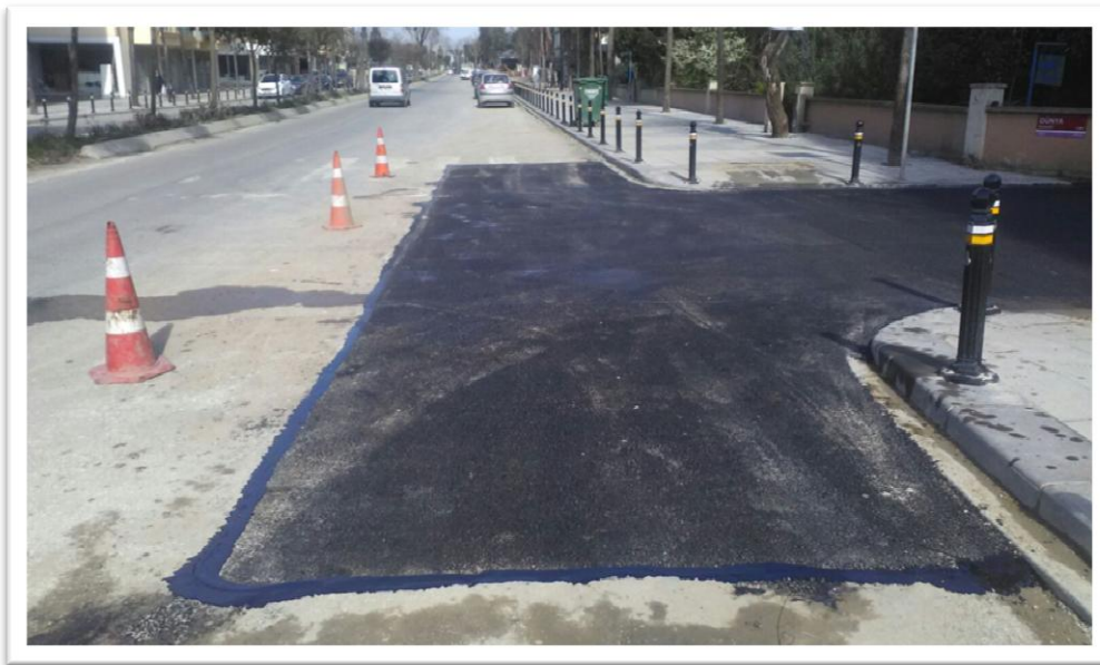
Resim 4.6. Uygulaması tamamlanan robotlu yama örneği
