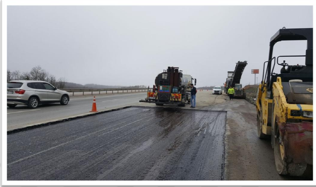
Resim 4.9. Temizlenen yüzeye distribütör ile dökülen emisyon maddesi
