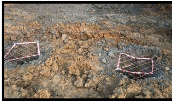
Resim 13. İmalatı Tamamlanan Delginin Üzerinin Kapatılması
