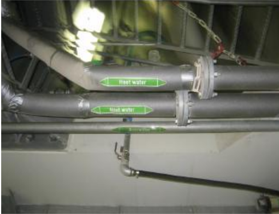
Şekil 19: Boru Yalıtımlarının İsimlendirilmesi
