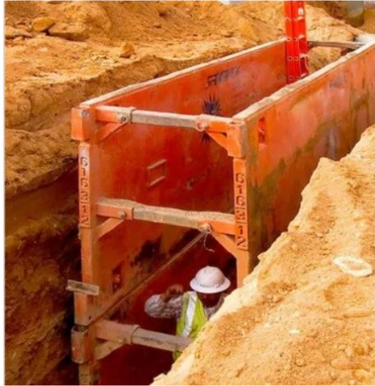
Şekil 26: Çelikten İksa ile göçük önlemi (18)
