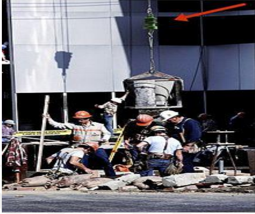
Şekil 17: Bakımsız makinelerin kilitlemesinin bozulması sonucu iş kazası
