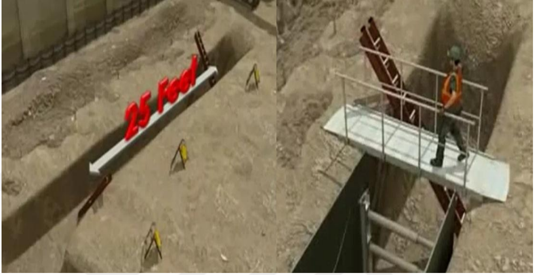
Şekil 27: Kazı için korkuluklu geçit (18)
