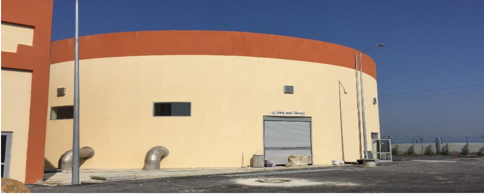
Resim 17. Silivri Giriş Terfi Ünitesi
