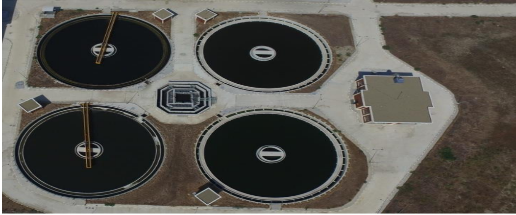
Resim 13. Çanta Son Çöktürme Havuzları
