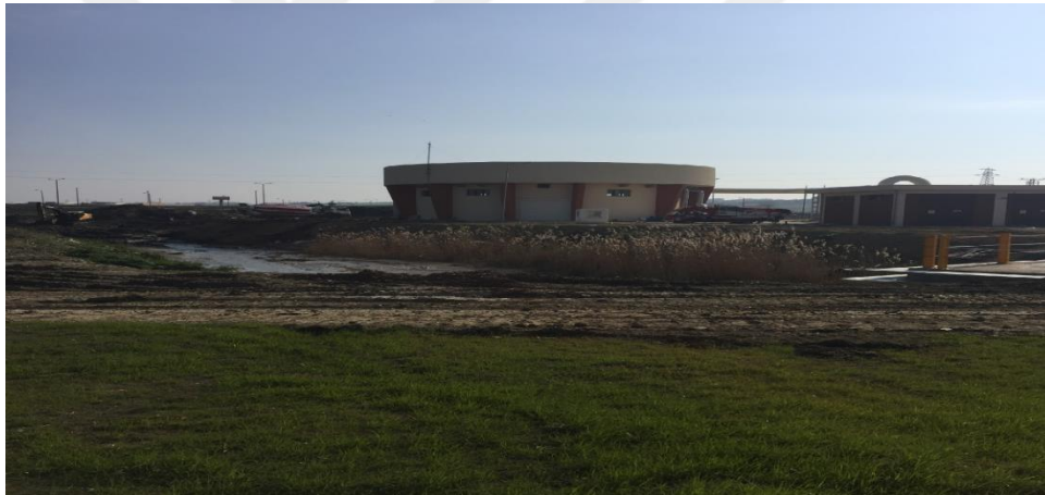
Resim 6. Çanta Giriş Terfi Ünitesi
