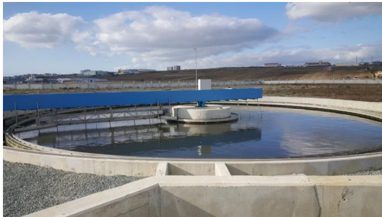
Resim 23. Silivri Son Çöktürme Havuzu
