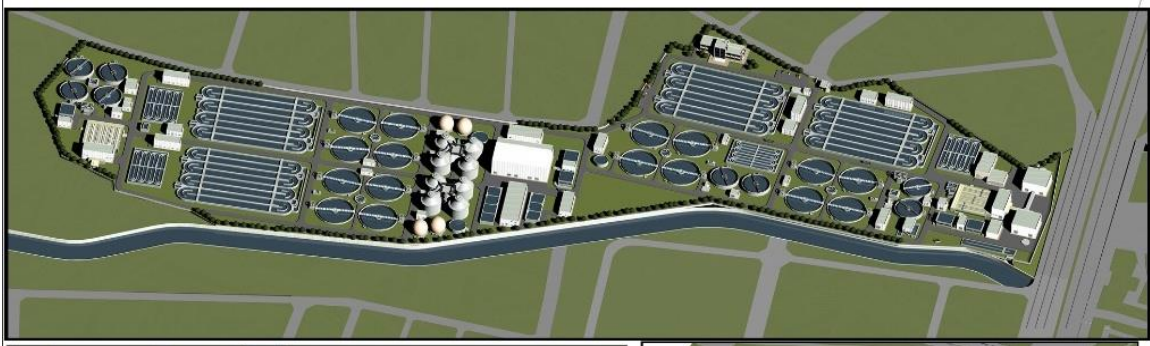
Resim 25. Selimpaşa İleri Biyolojik Atıksu Arıtma Tesisinin Görünüşü
