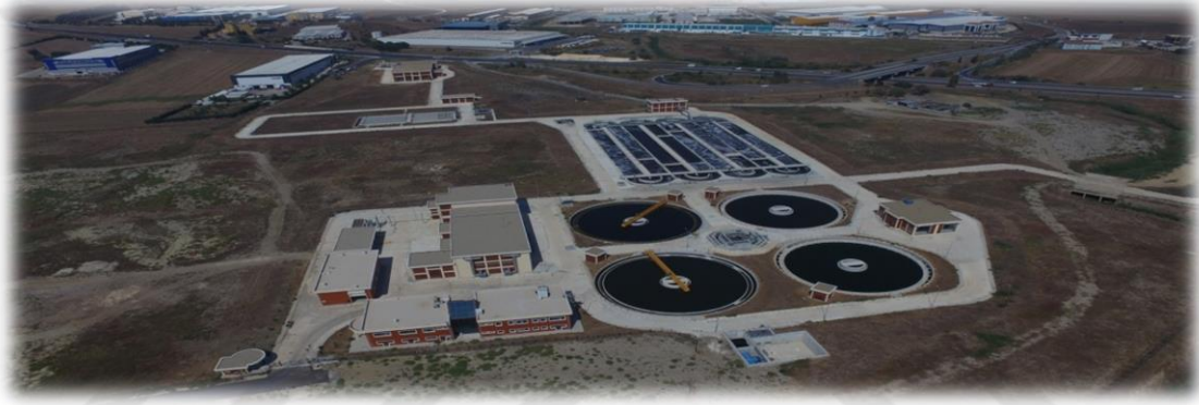
Resim 4. Çanta İleri Biyolojik Atıksu Arıtma Tesisinin Görünüşü
