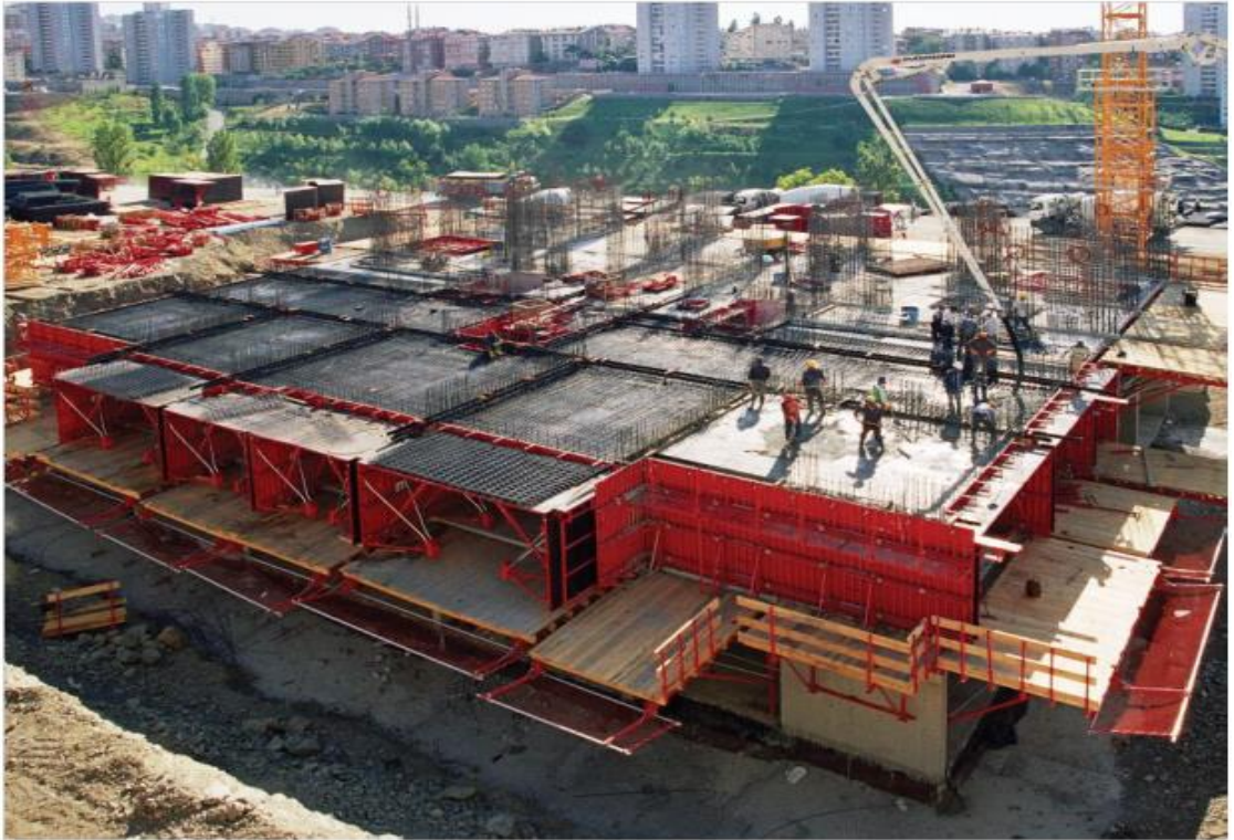
Şekil 12 Tünel Kalıp Sistemi[1]
