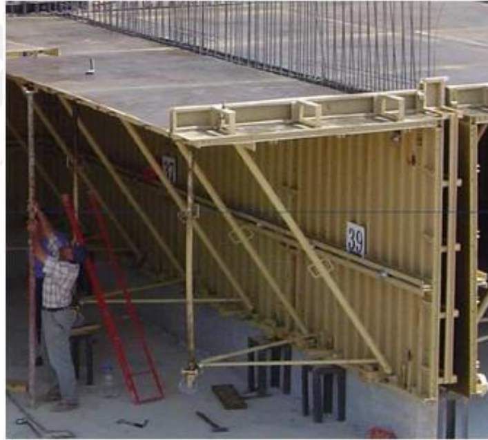
Şekil 13 Yarım Tünel Kalıp [3]
