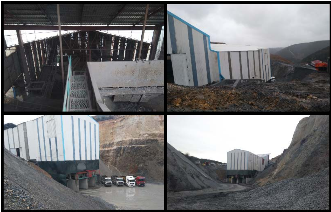
Şekil 2.4. Kırma- eleme tesisi.
