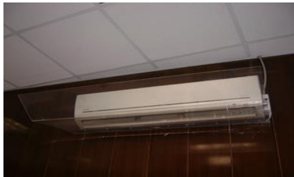
Şekil 5.9. Klimanın Altına Vida İle Monte Edilen Sert Plastik
