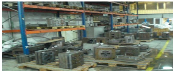
Şekil 5. 19. Kalıpların Depolandığı Alanda Yerde Oluşan Su Birikintisi
