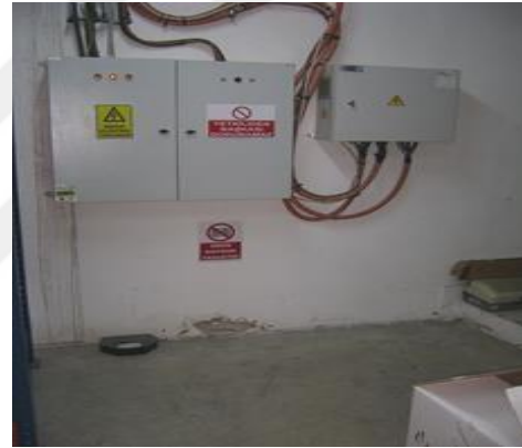
Şekil 5. 21. Yalıtkan Paspas Bulunmayan Elektrik Panoları
