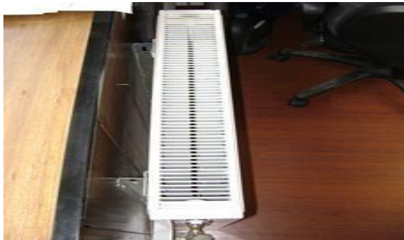
Şekil 5.6. Radyatör Peteğinin Ahşap Kapak Üzerine Monte Edilmesi
