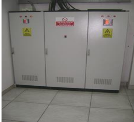
Şekil 5. 21. Yalıtkan Paspas Bulunmayan Elektrik Panoları
