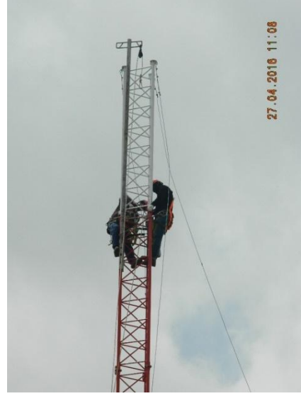
Şekil.7 Rüzgar ölçüm direği tırmanıcılar ile
