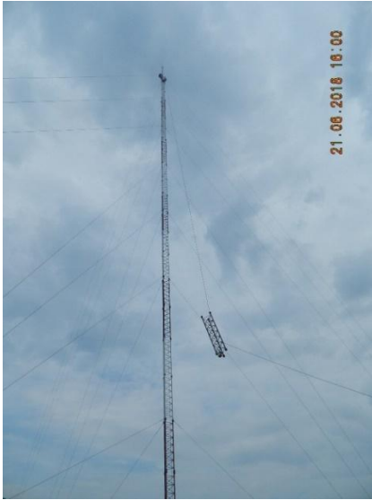
Şekil.8 Rüzgar ölçüm direği modüllerinin sökülmesi
