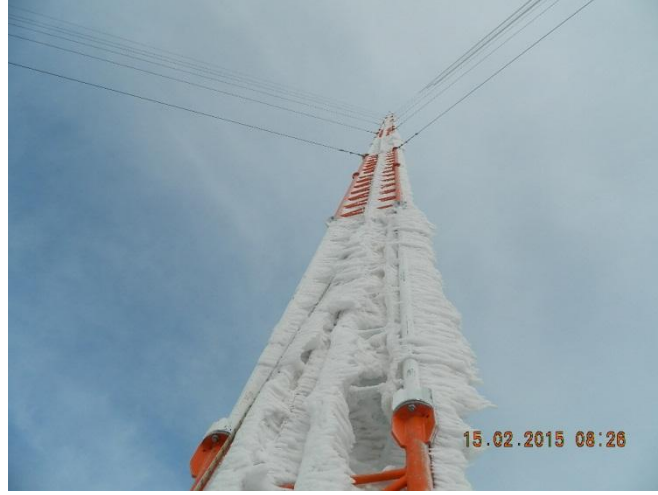
Şekil.12 Buzlanmış rüzgar ölçüm direği
