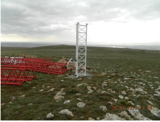
Şekil.6 Rüzgar ölçüm direği kurulum çalışmaları
