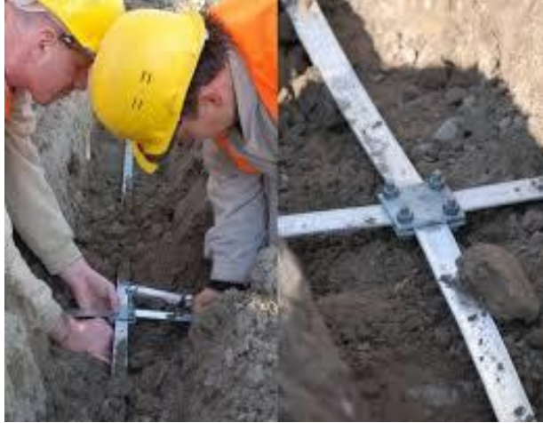
Şekil 2.3. Şerit Topraklayıcı (42)
