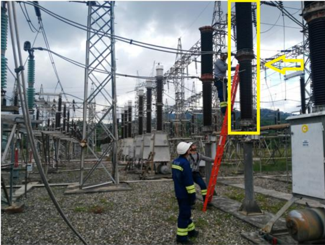
Resim 4. Açık şalt sahasında kesiciler üzerinde yapılan bir çalışma
