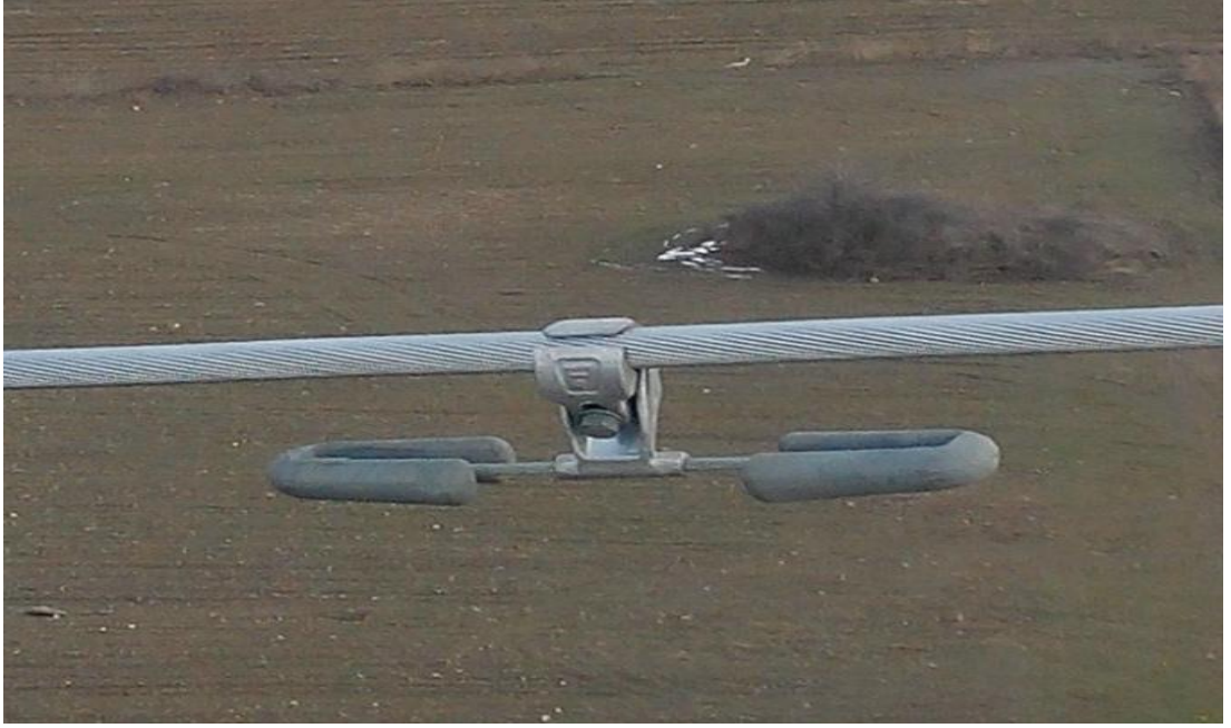
Resim 2.6. : Enerji İletim Elemanı Damper
