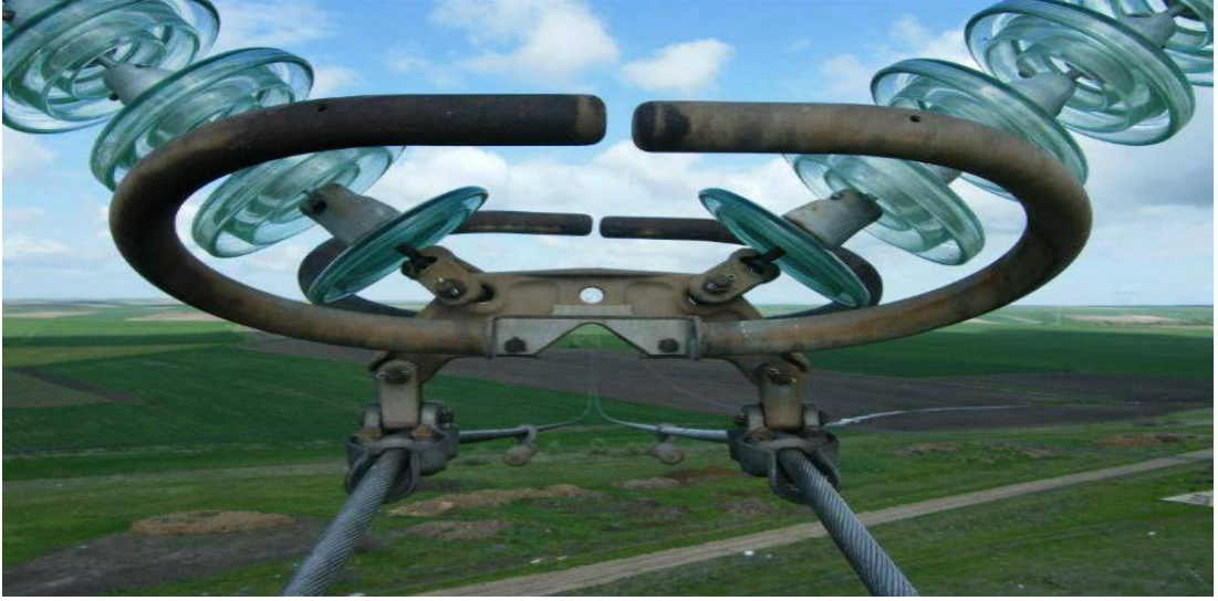
Resim 2.9. : Enerji İletim Elemanı Korona Halkası
