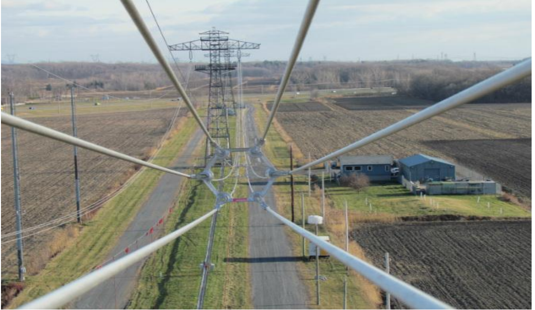
Resim 2.7. : Enerji İletim Elemanı Spacer
