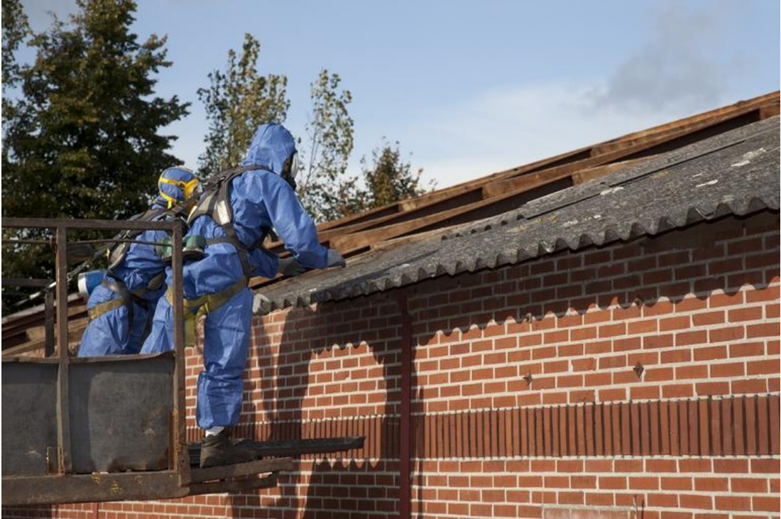
Şekil 4: Asbestin yapılarda kullanımı. [Mahir E. Ocak, Asbest Nedir?, http://www.bilimgenc.tubitak.gov.tr/makale/asbest-nedir , 19.01.2015, Erişim Tarihi: 04.07.2017]
