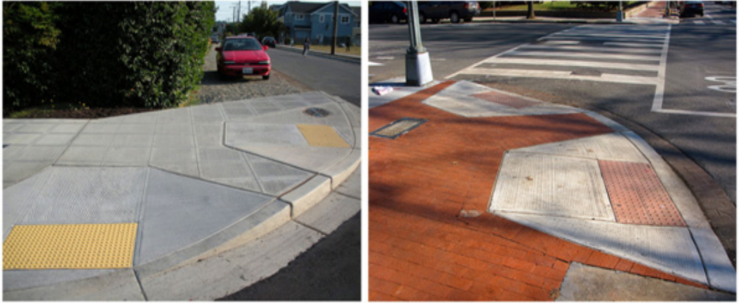
Şekil 3.26: Kaldırımdaki Bitkilendirmeden Dolayı 3. Yöne Eğimli Rampa 196
