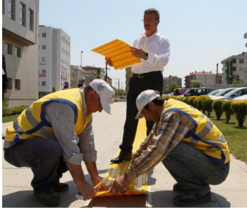
Fotoğraf 3.14: Gebze’de Engelliler İçin Kaldırma Hissedilebilir Yüzey Döşenmesi 220
