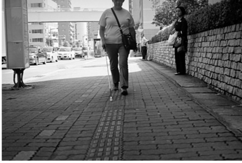
Fotoğraf 3.2: Hissedilebilir Yüzey Kaplamalı Kaldırım Örneği 172
