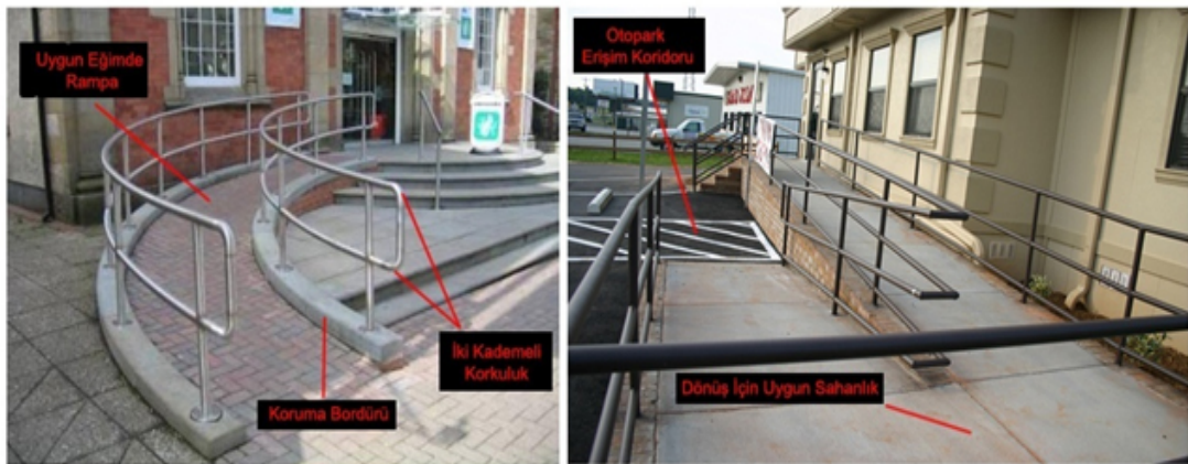
Şekil 3.19: Bina Girişlerinde Rampa Örnekleri 188
