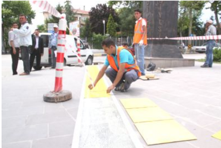
Fotoğraf 3.15: Ankara Polatlı Belediyesi Engelliler İçin Kaldırımlara Hissedilebilir Yüzey Döşenmesi 222
