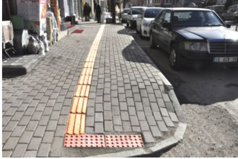
Fotoğraf 3.22: Bursa Kestel'de Engelli Vatandaşlar İçin Hissedilebilir Kaldırım Yüzey Uygulaması 235
