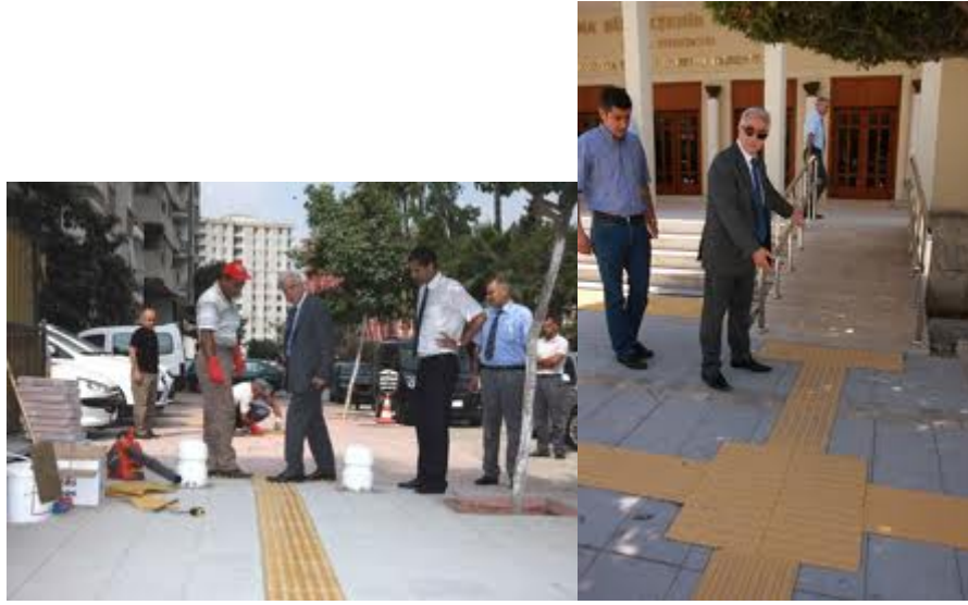
Fotoğraf 3.21: Adana İli Engelli Vatandaşlar İçin Hissedilebilir Kaldırım Yüzey Yapımı 233
