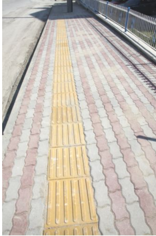
Fotoğraf 3.13: Ankara Sincan'da Engelliler İçin Kaldırımda Hissedilebilir Yüzey Örneği 219
