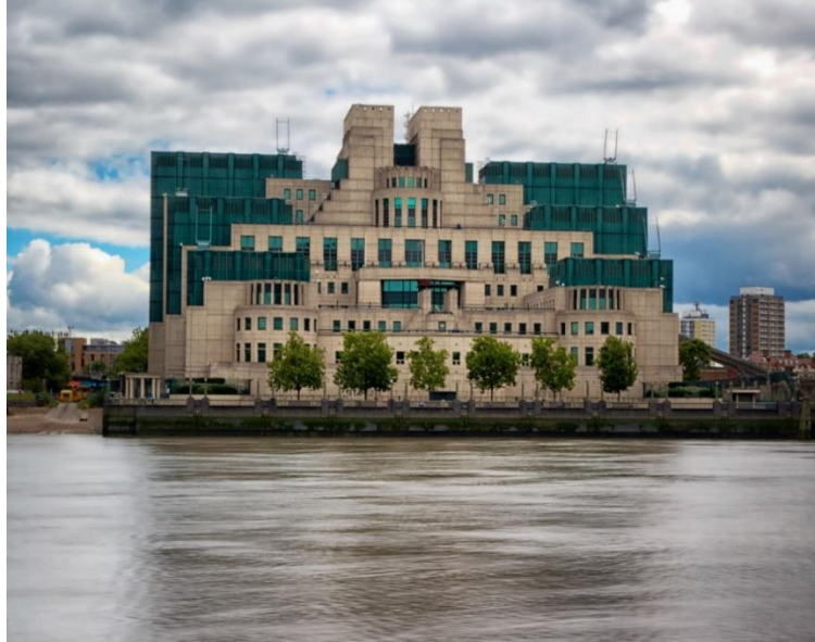
Şekil 4.37: Vauxhall Cross, Vauxhall SIS'in şuan ki merkezi binası
