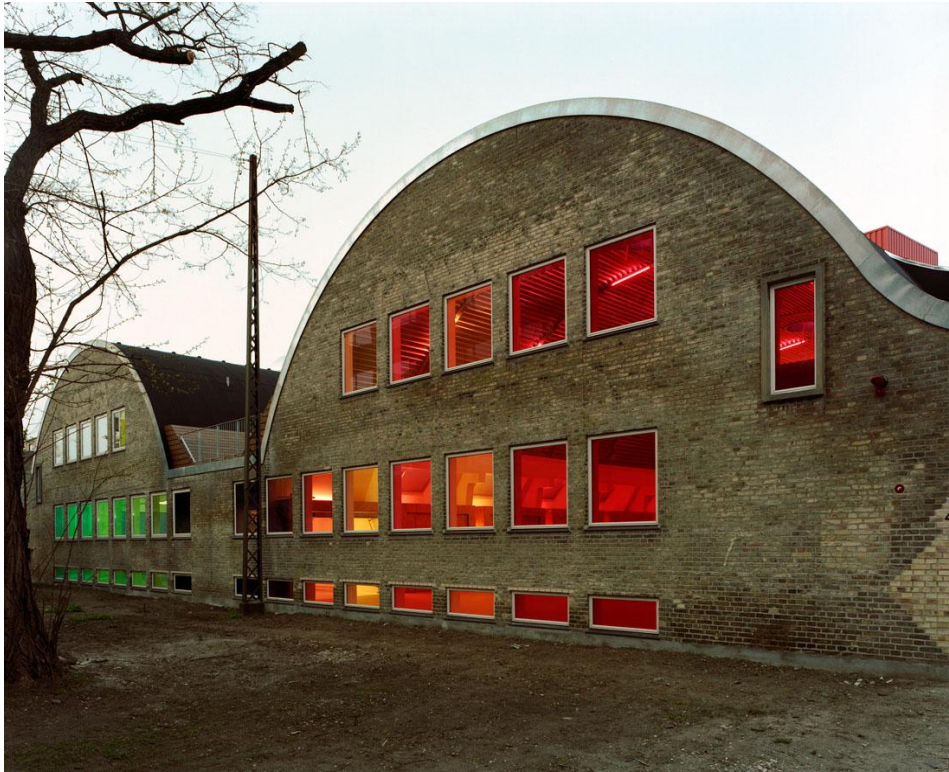
Şekil 5.3.8. Sjakket Gençlik Kulübü genel görünüm (Projeler/ Yapılar Kültür Yapıları, 2012)
