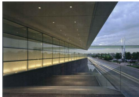
Şekil 5.1.5. Yapının girişinde saçak görünümü [9]
