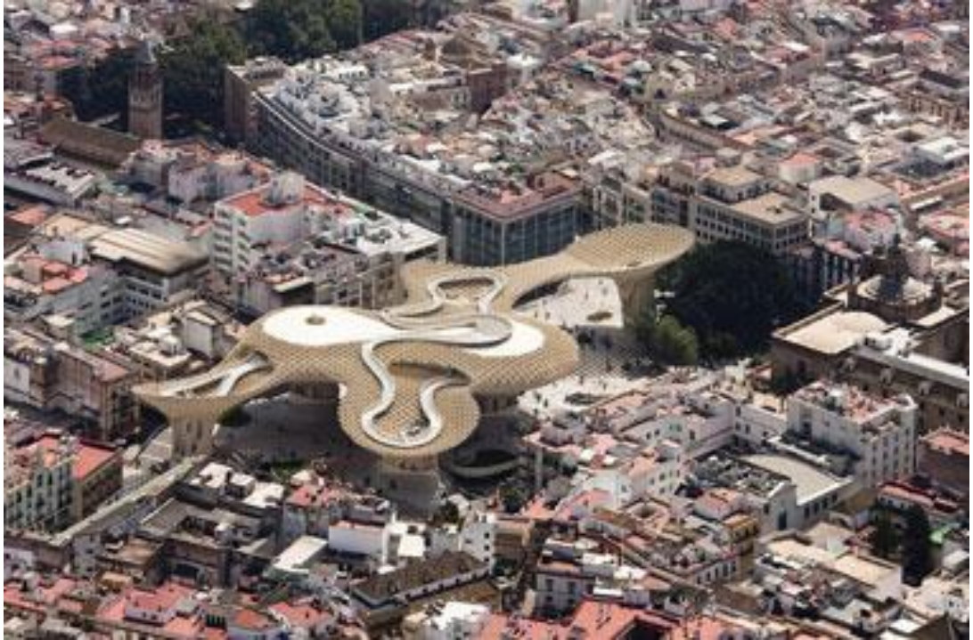
Şekil 5.1.23. Metropol Şemsiyesi genel görünüm [13]
