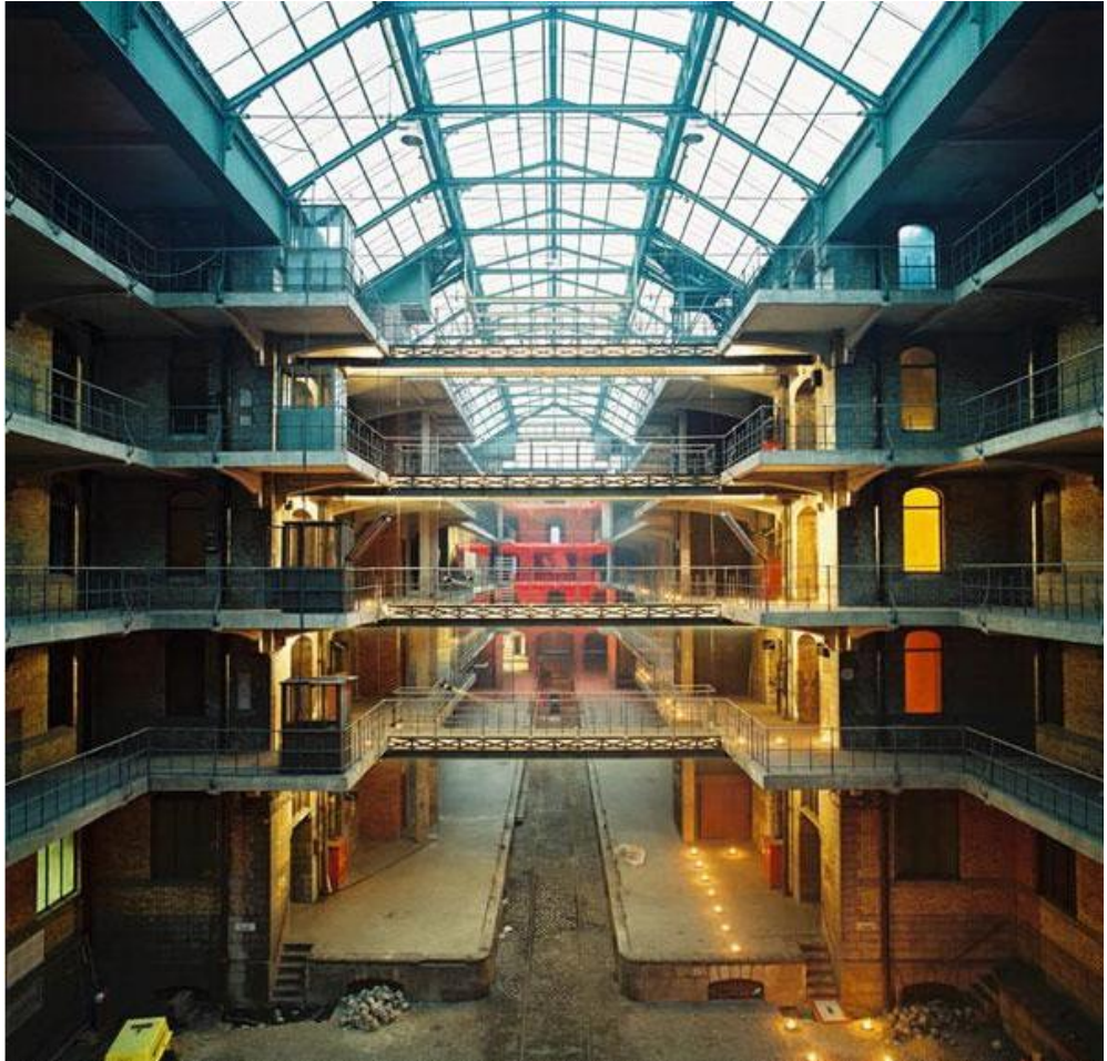
Şekil 5.3.29. Brüksel Kraliyet Antreposu iç mekan detayı [26]
