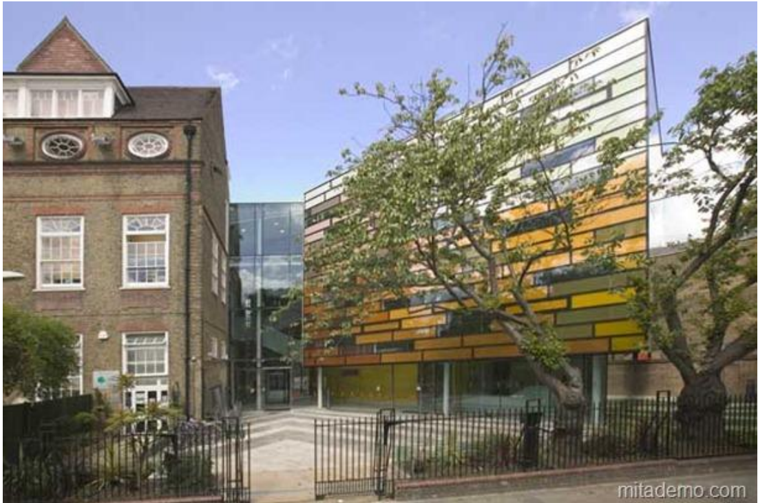
Şekil 5.2.21. Clapham Manor İlköğretim Okulu eski-yeni ilişkisi [22]
