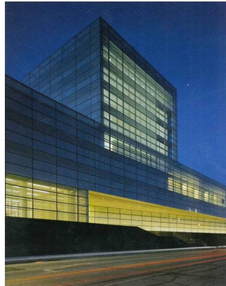
Şekil 5.1.4. Yapının girişindeki saçak [8]
