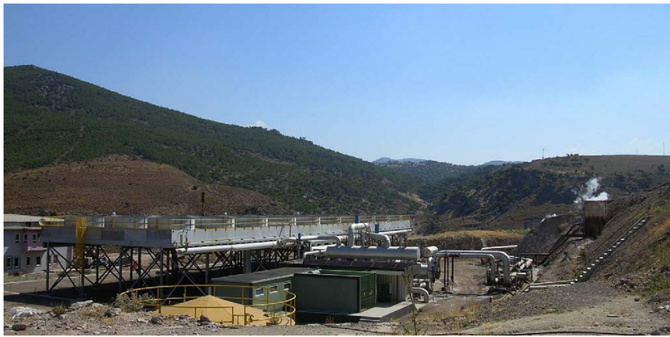
Şekil 21: Tuzla Jeotermal Güç Santrali [40]
