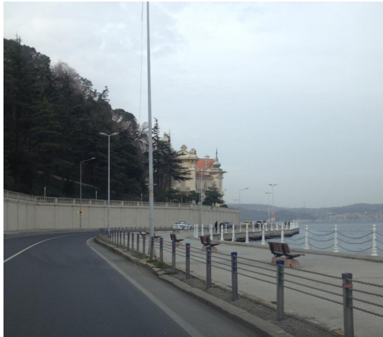
Şekil 3. Yeniköy Bölgesinde Kazıklı Yol Üzerinde Görüntü, 21/01/2014.
