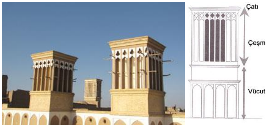
Şekil 4.3: Rüzgâr bacası birleşenleri.
