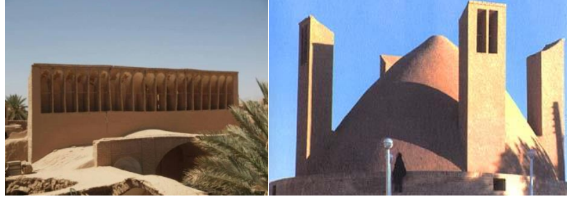
Şekil 4.9: Rüzgâr bacası 1. Tipin görünüşü.
