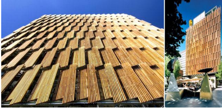
Şekil 2.10: CH2 binası, Çagdaş Malzeme.
