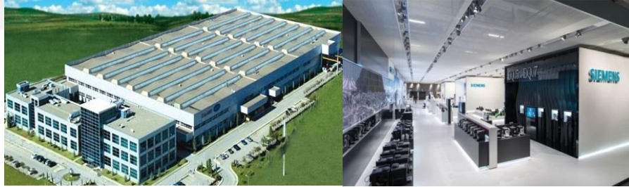
Şekil 2.9: İstanbul Gebze Siemens projesi, Çağdaş Malzeme [17].
