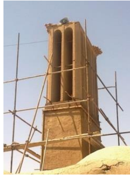
Şekil 4.11: Rüzgâr bacası 2. Tipin görünüşü.
