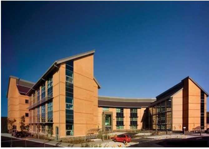
Şekil 3.10: Ofis kategorisinde Breeam sertifikalı Merthyr Building, Building Design.
