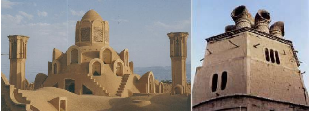
Şekil 4.16: Rüzgâr bacası 6. Tipin görünüşü.
