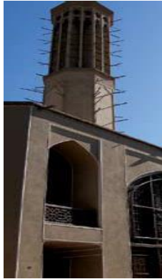
Şekil 4.15: Rüzgâr bacası 5. Tipin görünüşü.
