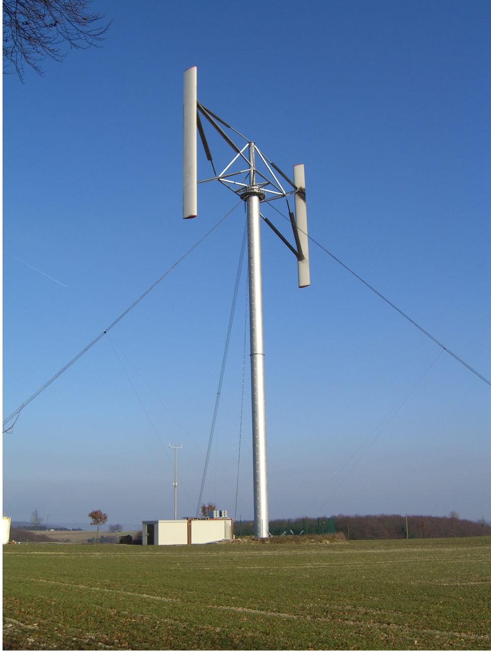
Şekil 3.46: H-Darrieus Rüzgar Türbinleri (Url-15)
